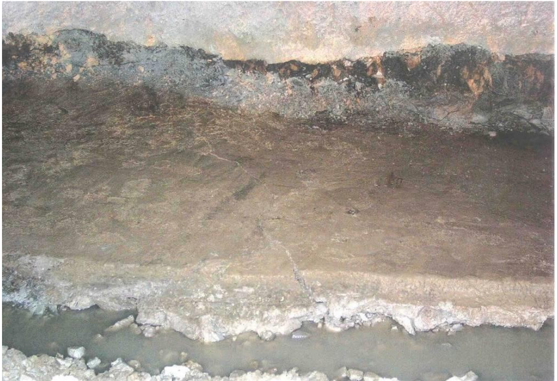
Şekil 4.5: Tüneli Tabanında Kabarmaların Gözlendiği Kesimler
