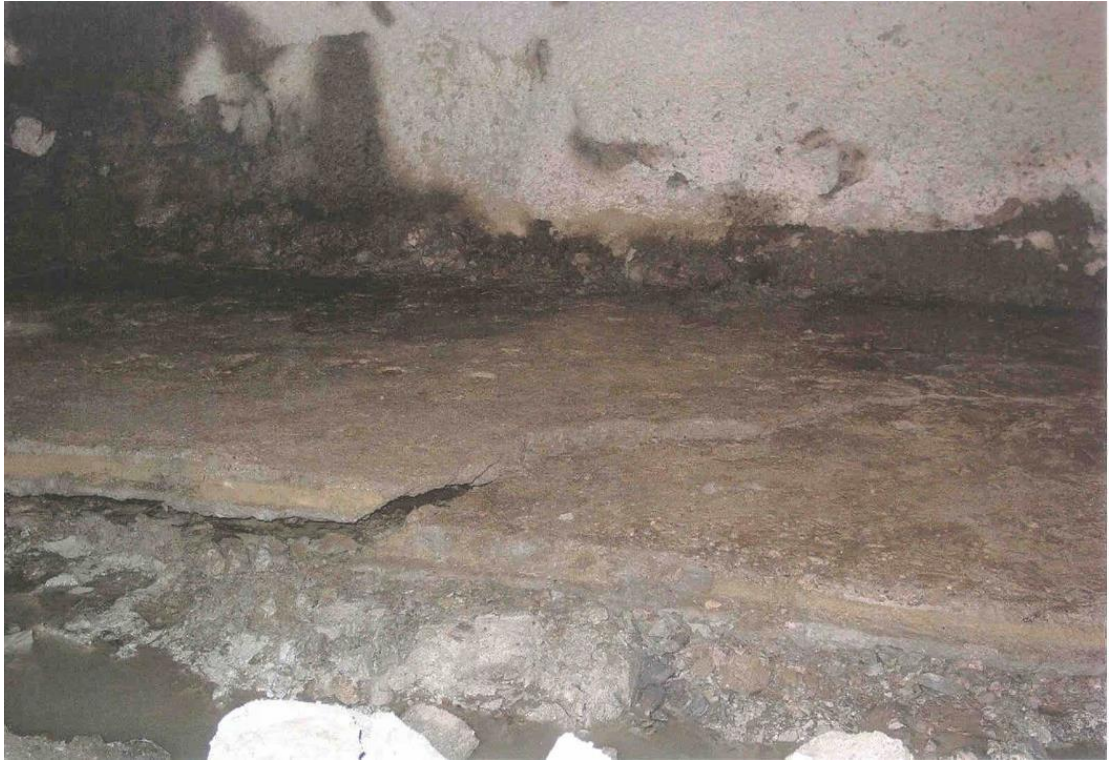
Şekil 4. 6: Su ile Temasta Kabararak Tabandaki Grobetonu Kıran Andezitik ve Bazaltik Bileşimli Kil Bantları
