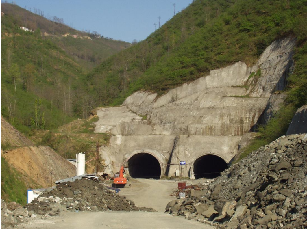
Şekil 4. 2: Hapan Tüneli Yapım Aşamasında Girişi Portalı
