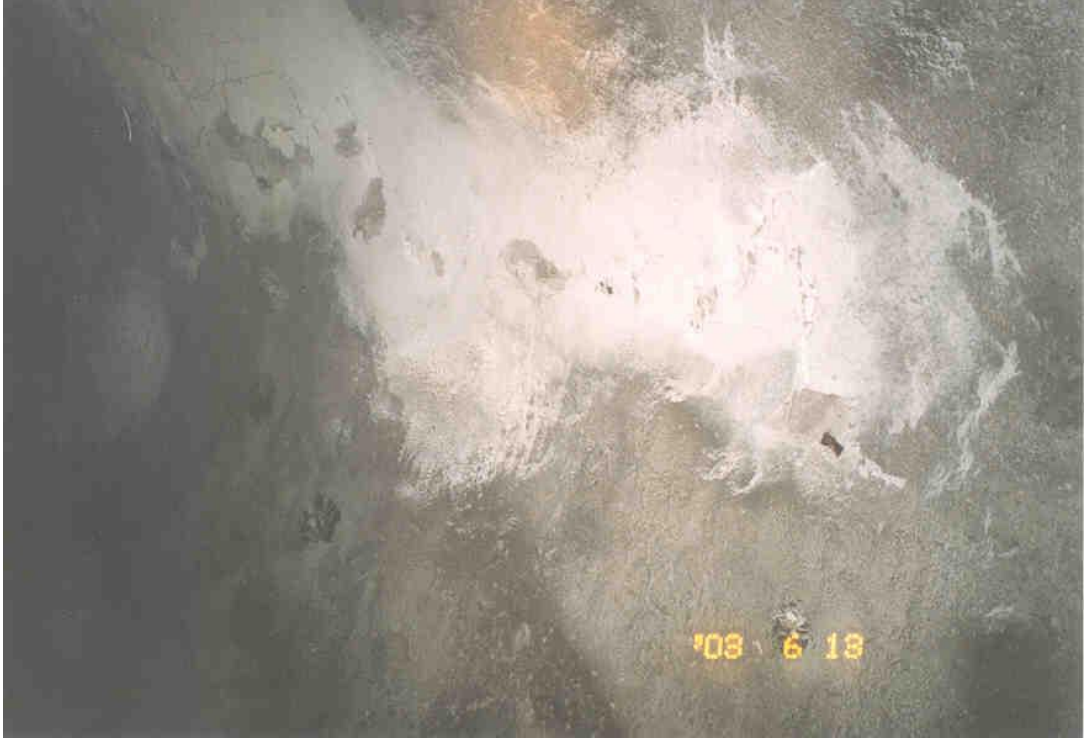
Şekil 4. 7: Tavanda Görülen Ayrışma ve Kavlaklanmalar
