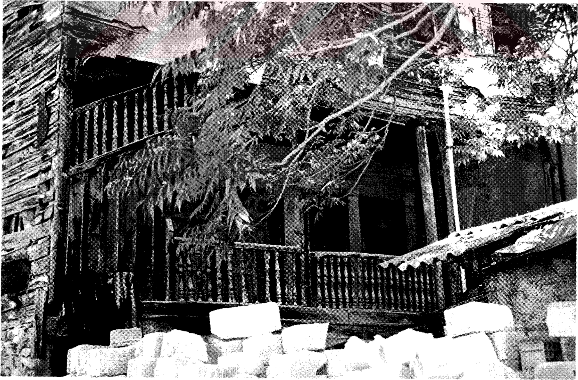
Şekil F57. Çeşmedamı Mahallesi, Çeşmedamı Çıkmaı Sokak, Şekil F56'daki konutun zemin katı (2000)
