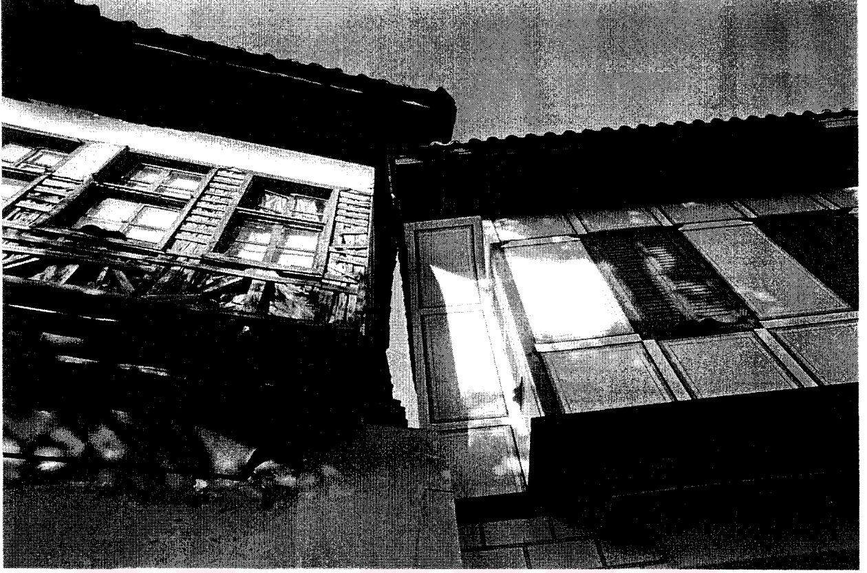
Şekil F122. Antalya, Kılınçarslan Mahallesi, Zafer Sokak, No:1, Sevgi Gönül Evi'nin cephesi (Bektaş, 1997)
