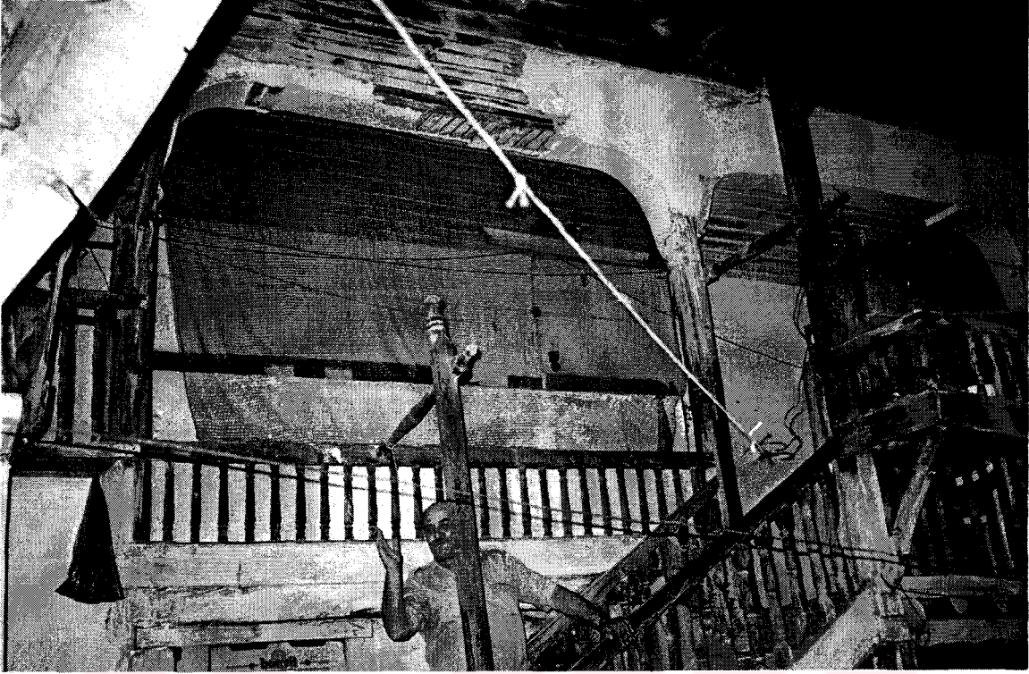
Şekil F64. Şekil F61'deki konutun ahşap basamaklarının üzerindeki tak (2000)
