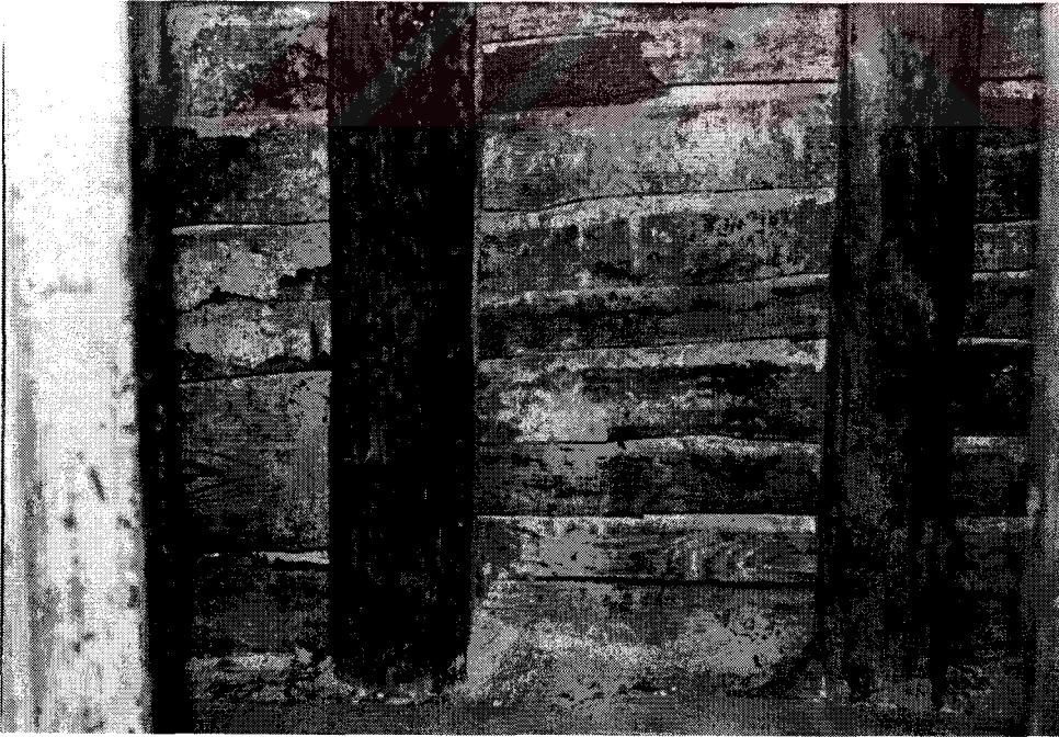
Şekil D100. Selamlık bölümü, 103 mekânı, kuzey duvarı, şerbetlik altı dolap içi ve taşıyıcı konstrüksiyonu (1999)
