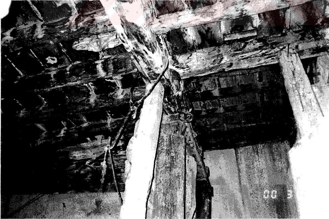
Şekil D58. Selamlık bölümü, kiler (Z03) mekânı, tavan kirişlemeleri (2000)
