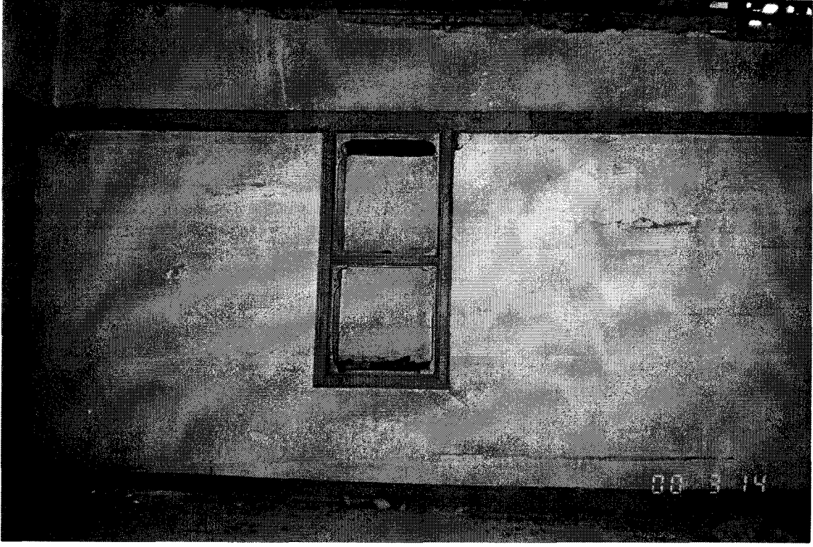
Şekil D159. Selamlık bölümü, 204 mekânı güney duvarı ve niş (2000)
