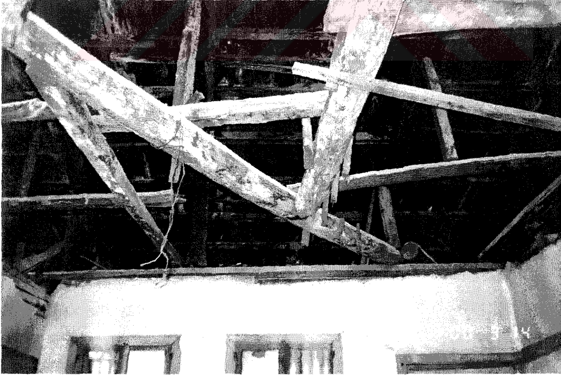
Şekil D168. Selamlık bölümü, 204 mekânı doğu duvarı üzeri çatı konstrüksiyonu (2000)
