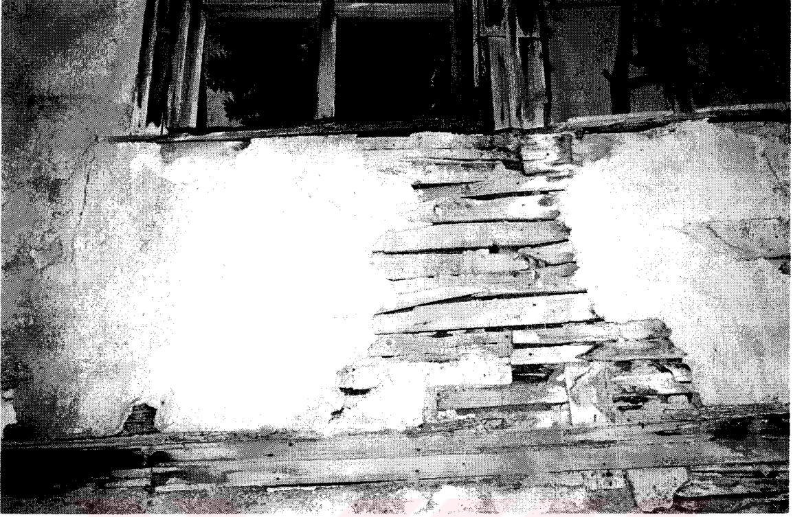
Şekil D185. Selamlık bölümü, P11-P12 pencereleri altındaki ahşap strüktür (2000)
