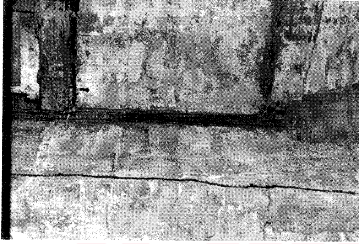
Şekil D77. Selamlık bölümü, Z05 mekânı doğu duvarı, ana taşıyıcı dikme, taş kaide ve merdiven altı dolgusu (1999)
