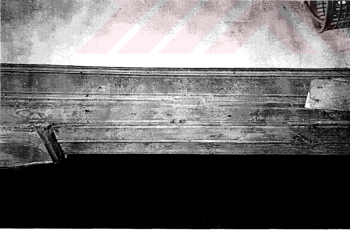
Şekil D193. Selamlık bölümü, ahşap merdivenin güneyinde yer alan ahşap dikme üzerindeki kapı izleri (2000)
