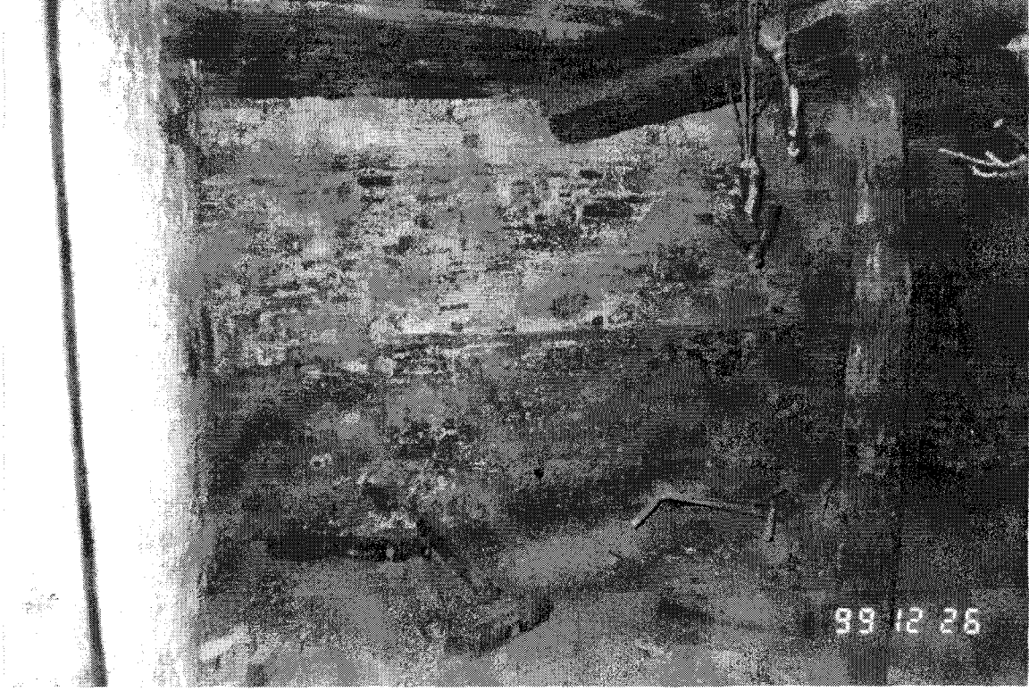
Şekil D69. Selamlık bölümü, soğuk depo (Z04) batı duvarı (1999)
