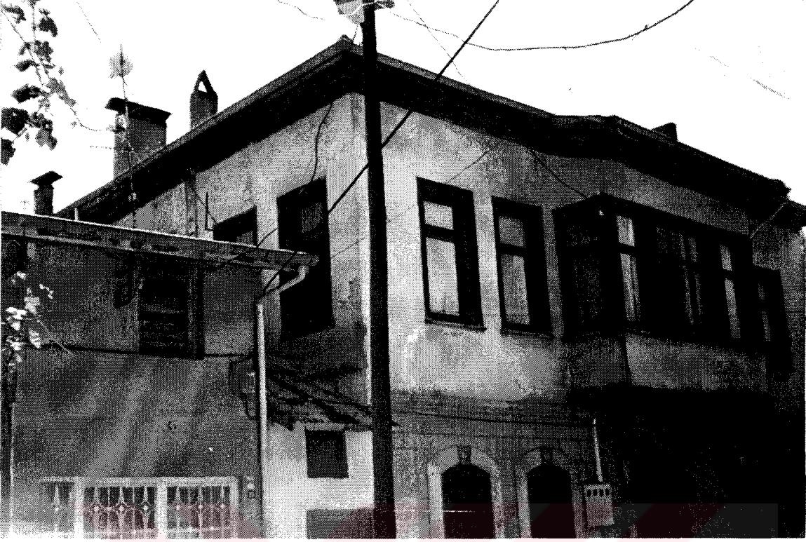
Şekil F37. Üçdibek Mahallesi, Boyacı Sokak, 425 ada, No.25, konut (2000)
