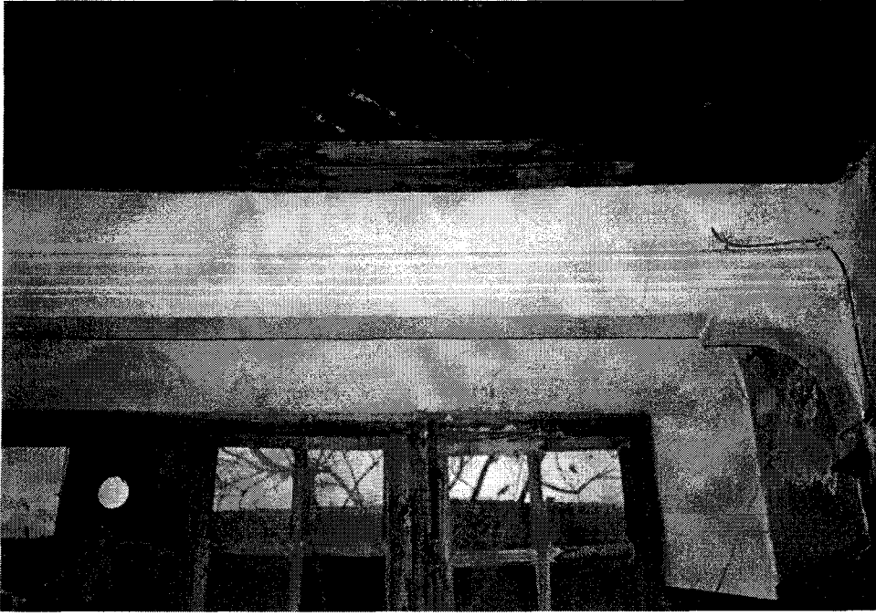
Şekil D87. Selamlık bölümü, 101 mekânı, Bursa kemeri - güney duvarı birleşimi (2000)
