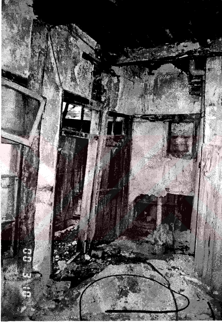
Şekil D37. Selamlık bölümü, mutfak mekânı (Z02) giriş kapısı ve kiler penceresi (1999)
