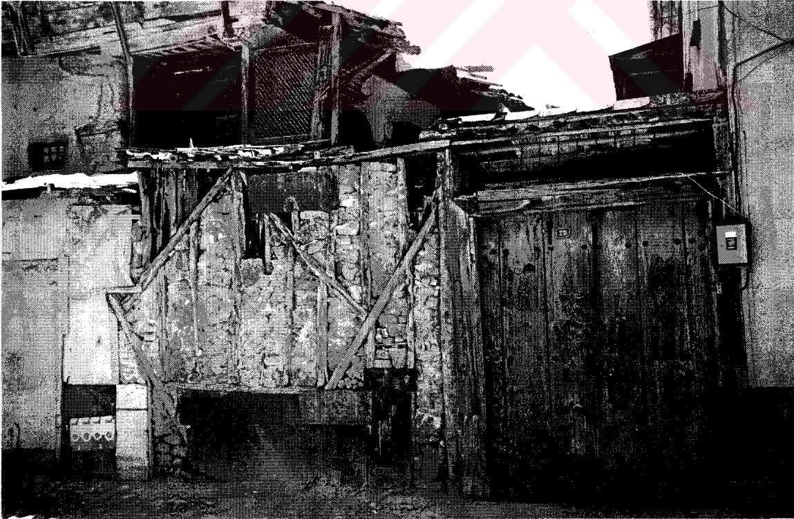
Şekil F61. Üçdibek Mahallesi, Atabey Caddesi, 420 ada, No.20, toprak damlı konut (2000)
