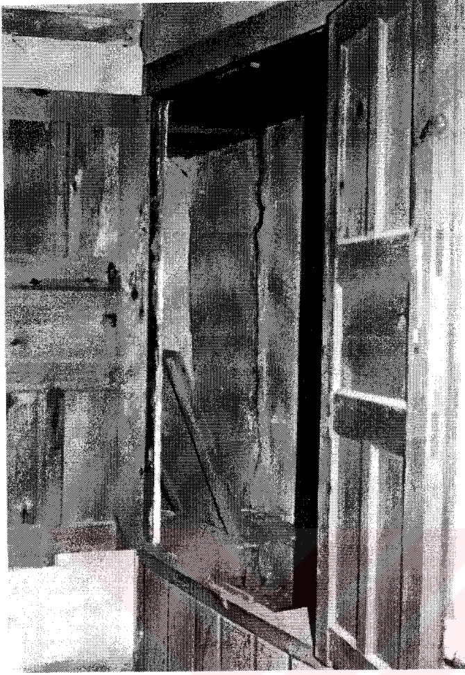
Şekil D151. Selamlık bölümü, 203 mekânı kuzey duvarı, yükçük içi (1999)
