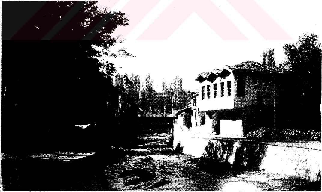
Şekil C4. Çay boyunda bir konut, 1955 (Burdur Belediyesi arşivi)
