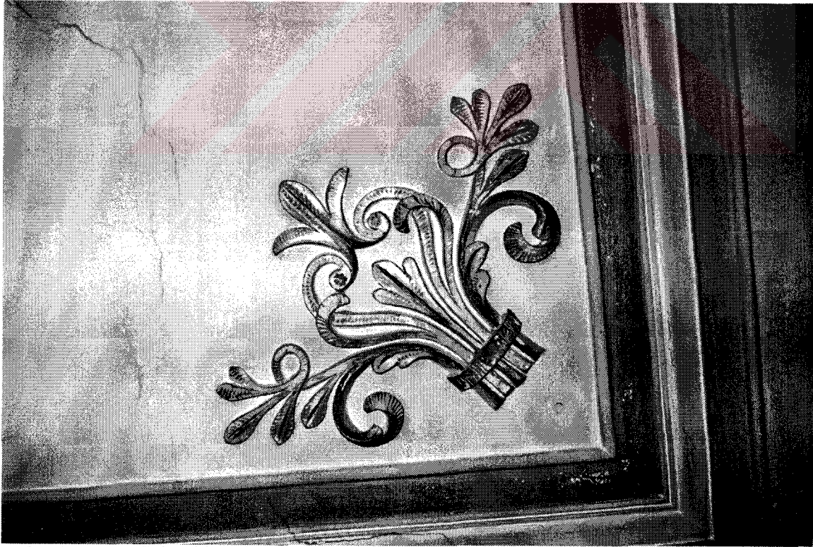
Şekil D140. Selamlık bölümü, 202 mekânı (köşk oda) tavanı, köşe motifi (1999)
