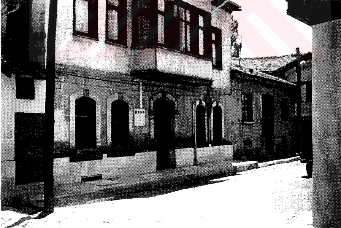
Şekil F38. Üçdibek Mahallesi, Boyacı Sokak, Şekil F37'deki konutun zemin katı (2000)
