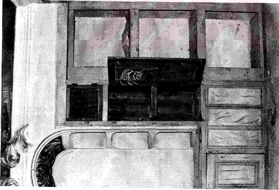
Şekil D149. Selamlık bölümü, 203 mekânı kuzey duvarı, kapı arkası dolap ve şerbetlik yanı dolap (1999)
