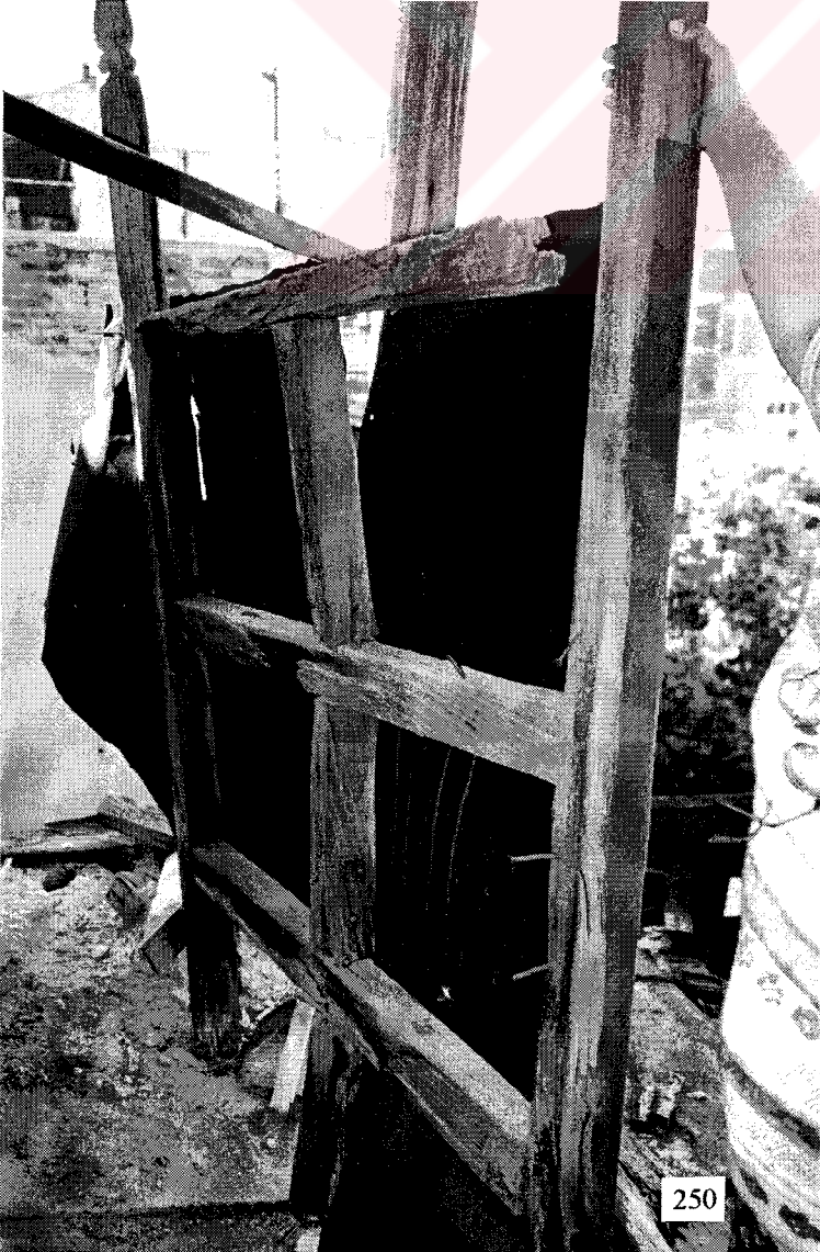
Şekil D189. Selamlık bölümü, seyir terası (205) kaplamasının altındaki ahşap kaplama (2000)
