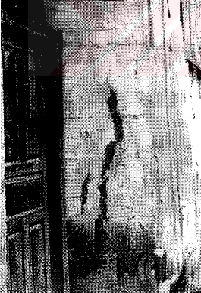
Şekil D177. Selamlık bölümü, 106 mekânı (hela) giriş kapısı üzerinde yer alan çürümüş ahşap lento
