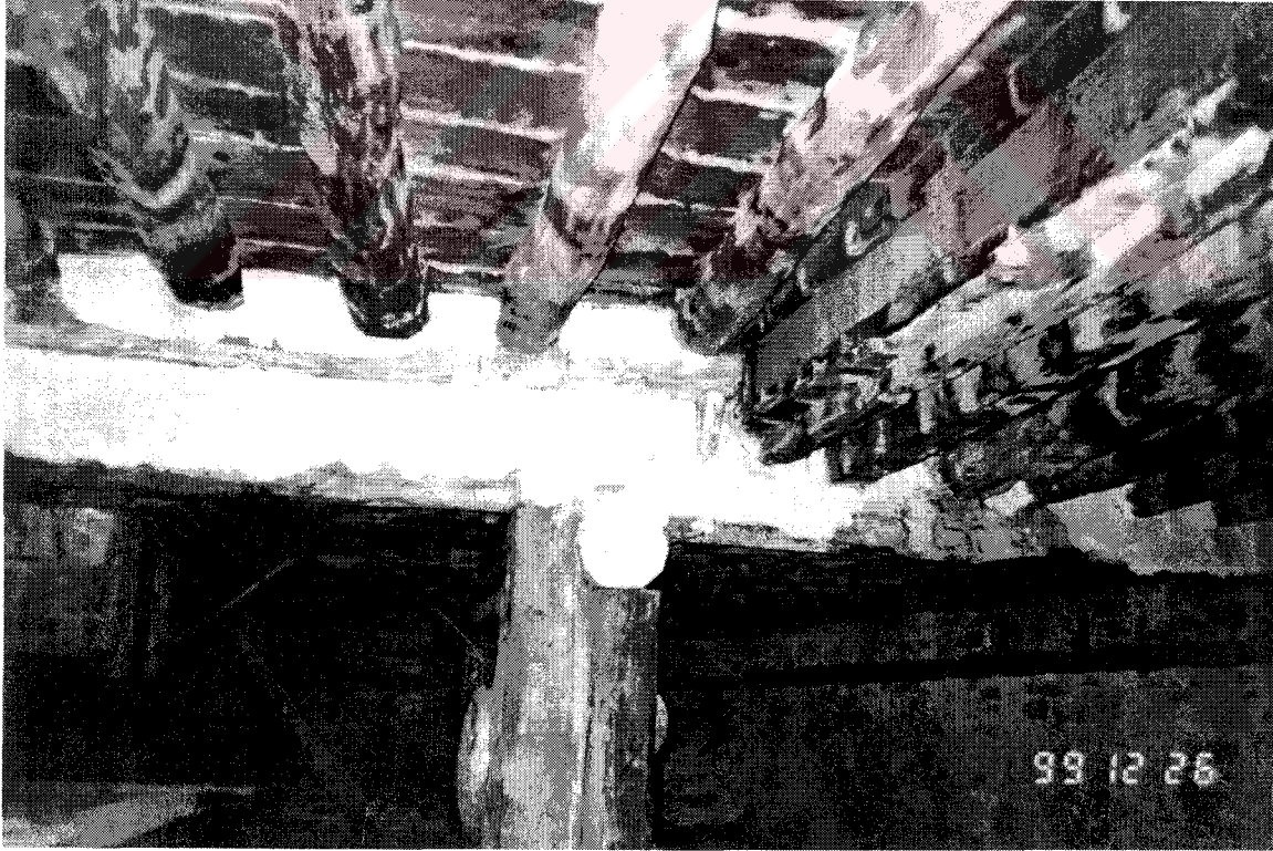
Şekil D75. Selamlık bölümü, Z05 mekânı taşıyıcı sistemi (1999)
