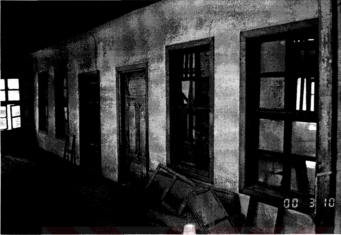
Şekil D121. Selamlık bölümü, 201 mekanı (sofa) batı duvarı
