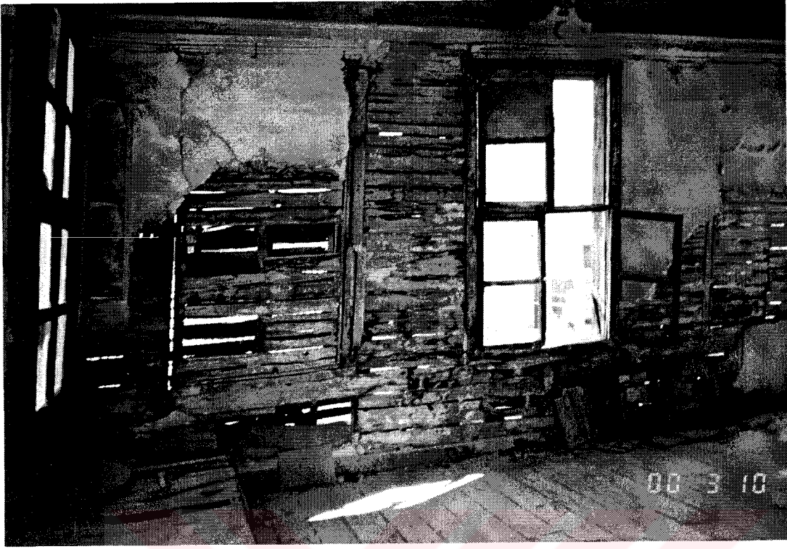
Şekil D126. Selamlık bölümü, 202 mekanı (köşk oda) güney duvarı
