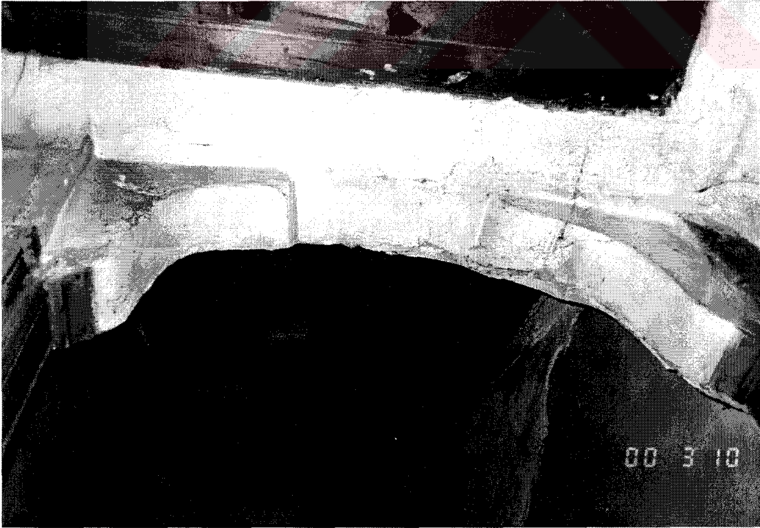
Şekil D115. Selamlık bölümü, merdiven girişi kemerleri (2000)
