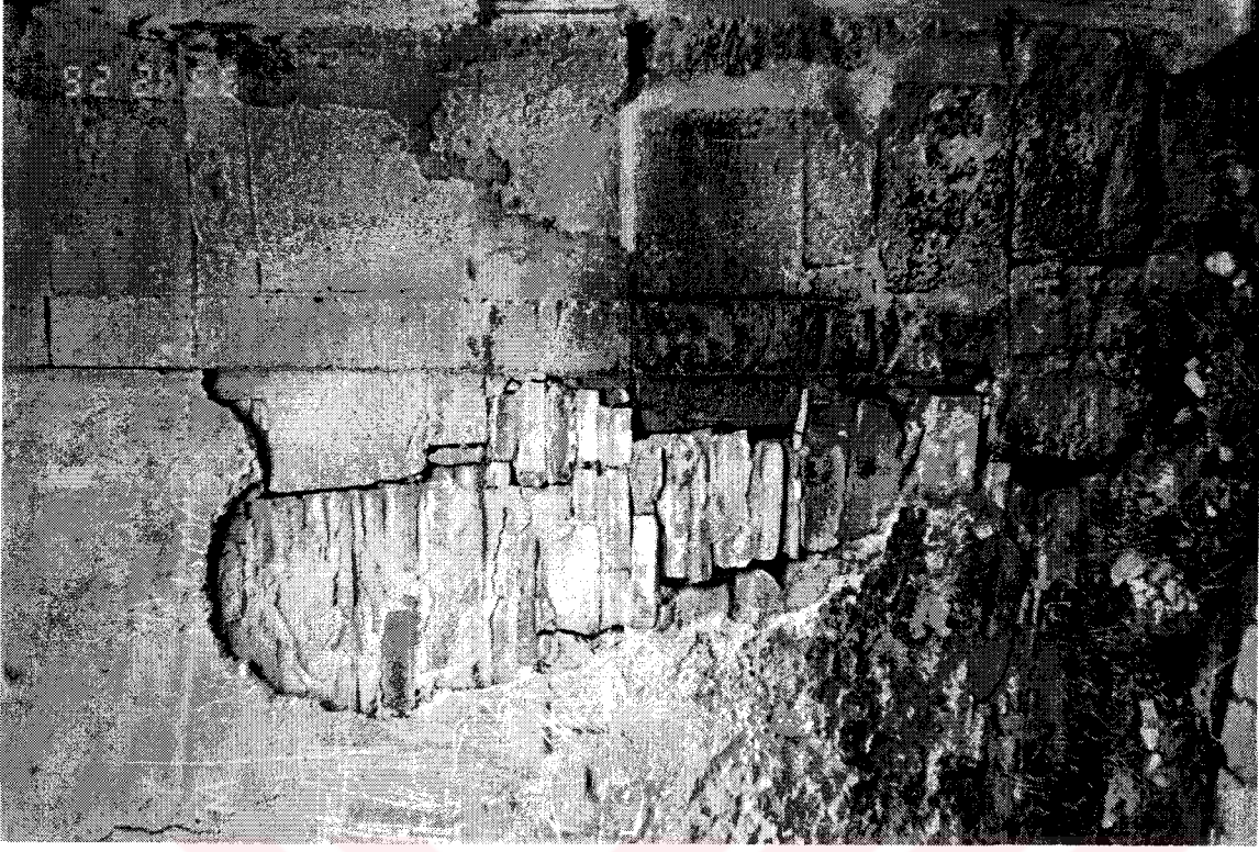
Şekil D16. Selamlık bölümü, giriş cephesi özgün sıva ve taş örgü sistemi (1999)
