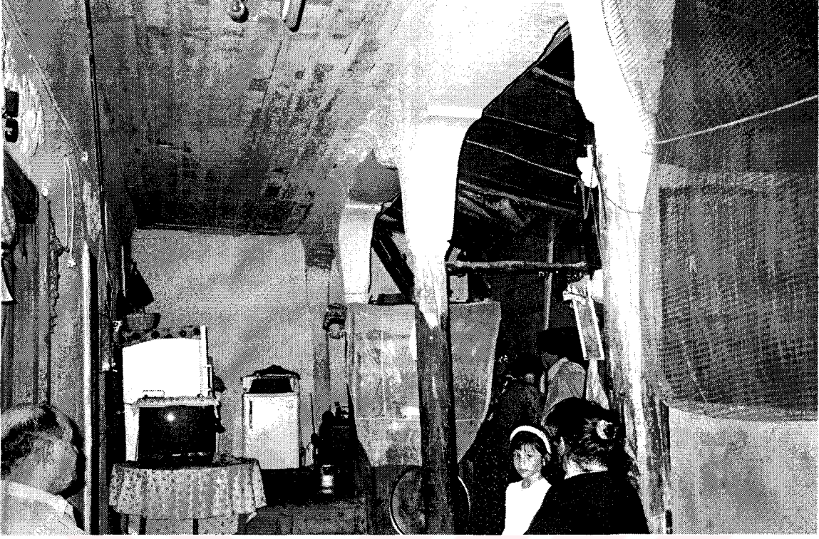
Şekil F66. Şekil F61'deki konutun zemin kat sofasının genel görünümü (2000)
