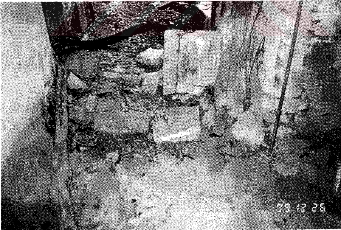
Şekil D50. Selamlık bölümü, sarnıç (Z06) önü taşlıktan ahır ve depo mekânına (Z05) geçiş (1999)
