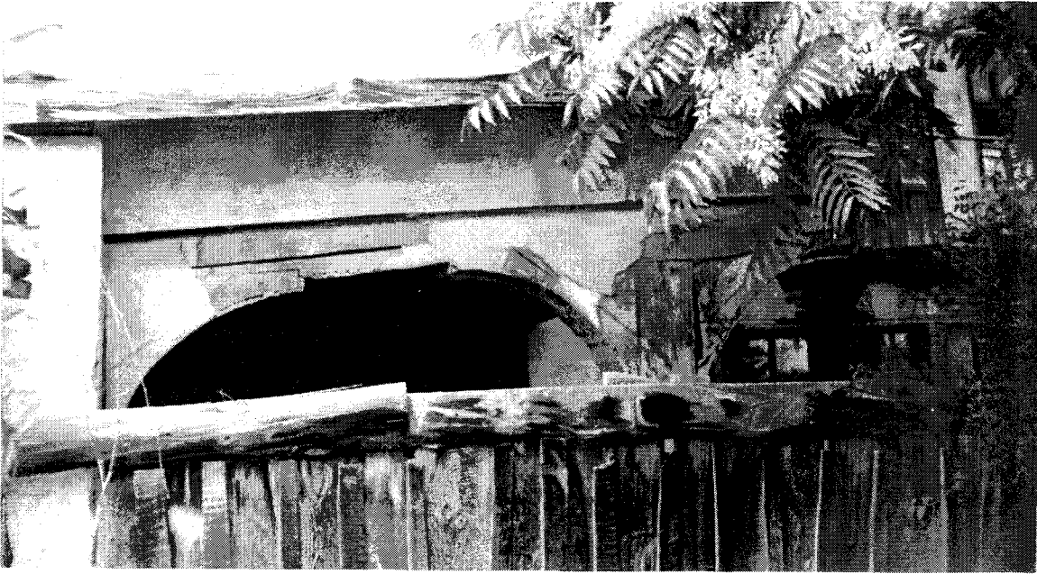
Şekil D25. Selamlık bölümü, köşk oda (202) doğu cephesi, çıkma altı bursa kemeri (2000)
