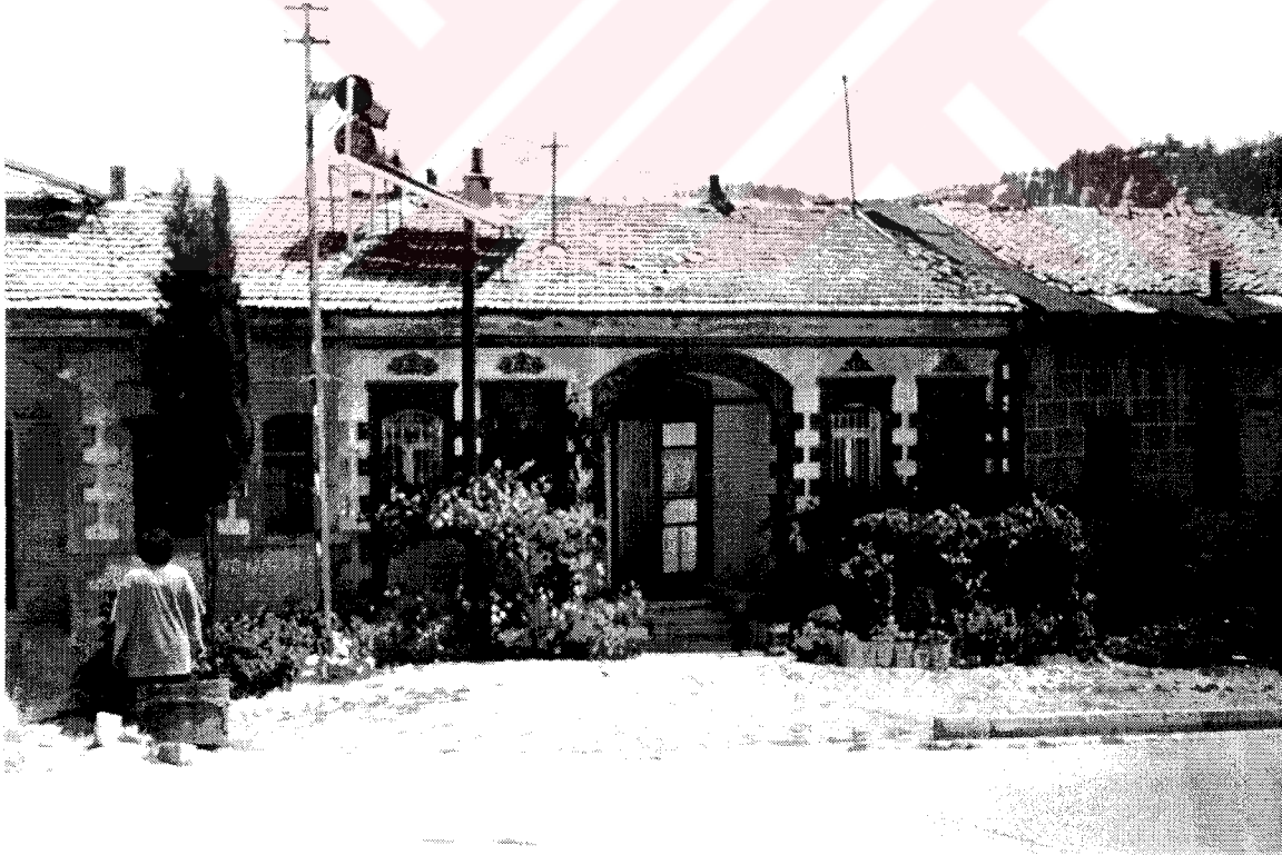
Şekil F20. İnönü Mahallesi, Yeni Hamam Caddesi, 347 ada, No.73, konut (2000)
