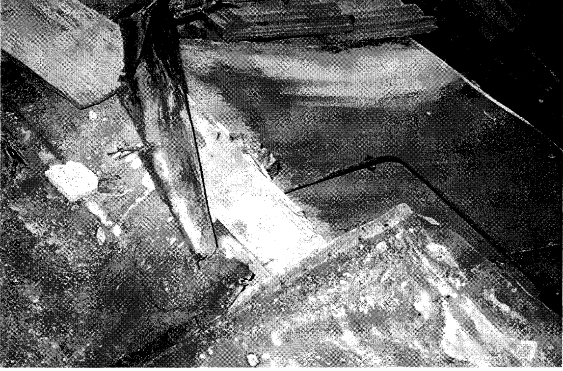
Şekil D189. Selamlık bölümü, seyir terası (205) kaplamasının altındaki ahşap kaplama (2000)
