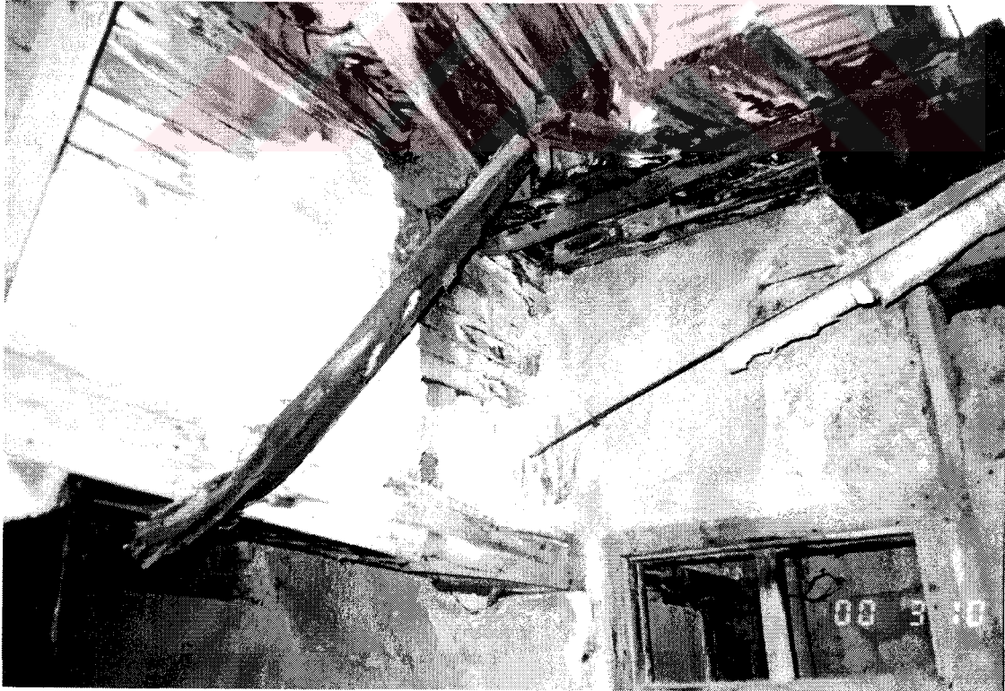
Şekil D174. Selamlık bölümü, doğu duvarı ile mutfak (Z02) cephesi birleşimi
