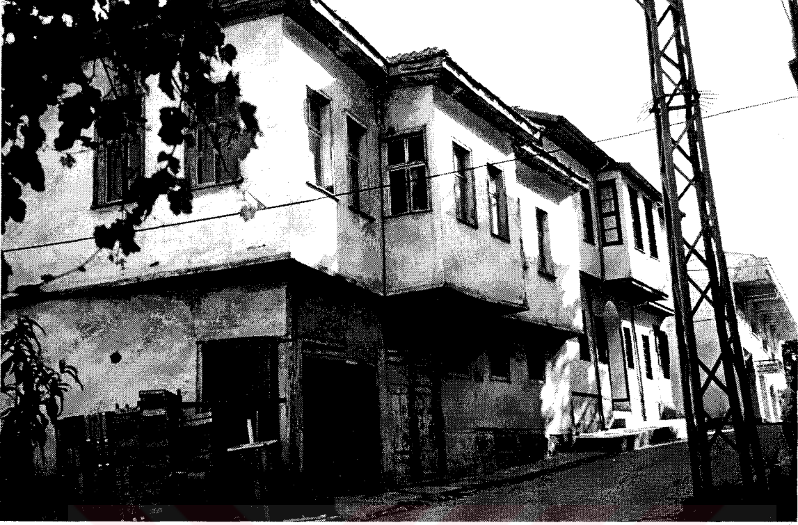
Şekil F25. Pazar Mahallesi, Şekerci Sokak, 344 ada, konutlar (2000)
