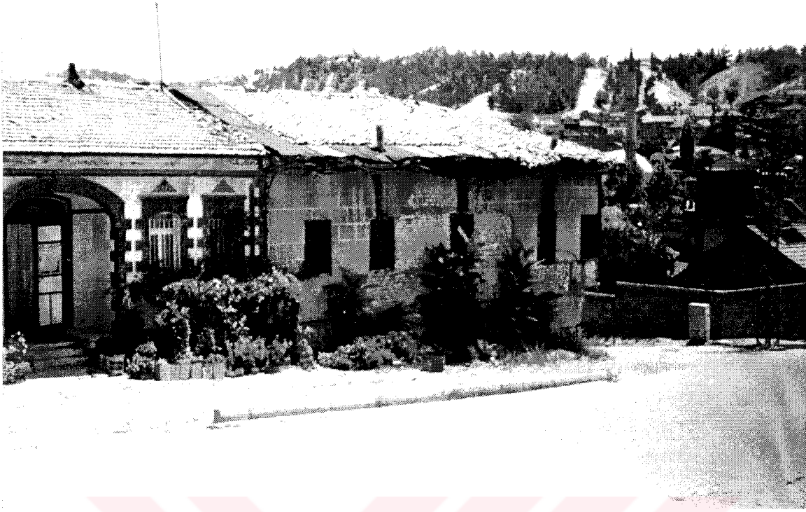
Şekil F19. İnönü Mahallesi, Veyis Sokak, 347 ada, No.8, konut (2000)
