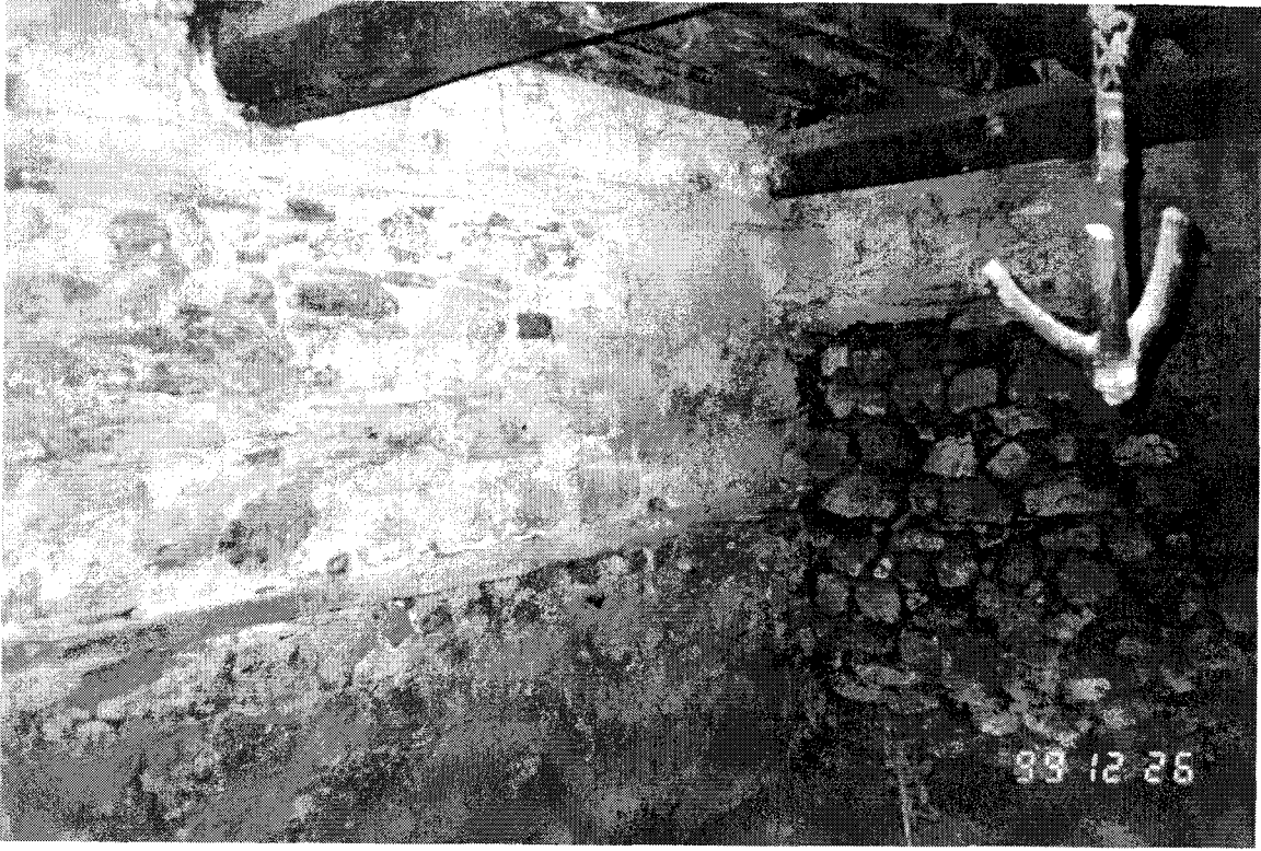
Şekil D67. Selamlık bölümü, soğuk depo (Z04) batı ve kuzey duvarı birleşimi (1999)
