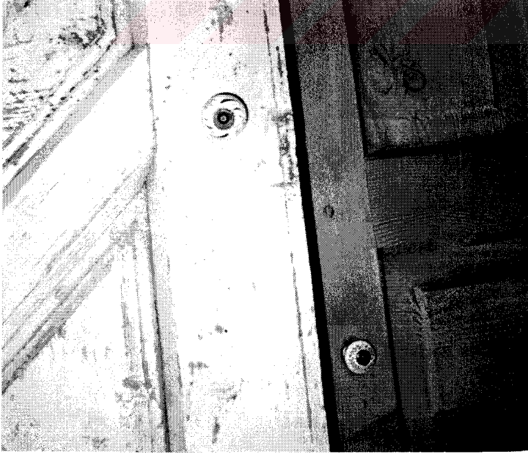
Şekil E18. Harem bölümü, üst kat özgün, porselen kapı kulpu (1999)
