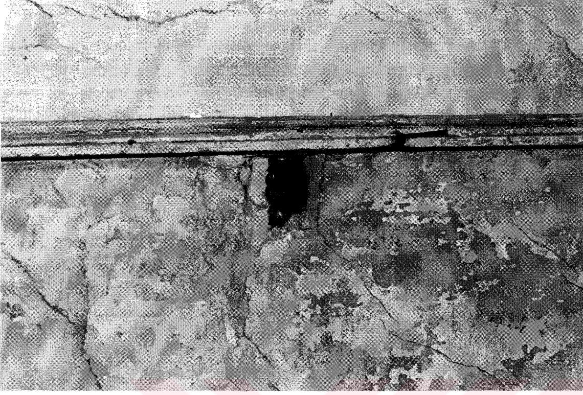
Şekil D129. Selamlık bölümü, 202 mekânının (köşk oda) giriş kapısı arkasında yer alan profil ve kilit yuvası (1999)
