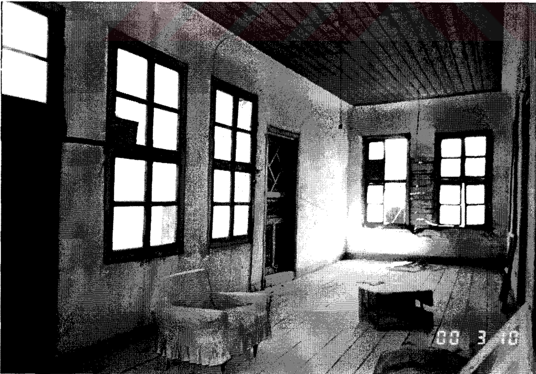
Şekil D120. Selamlık bölümü, 201 mekanı (sofa) güney ve doğu duvarı
