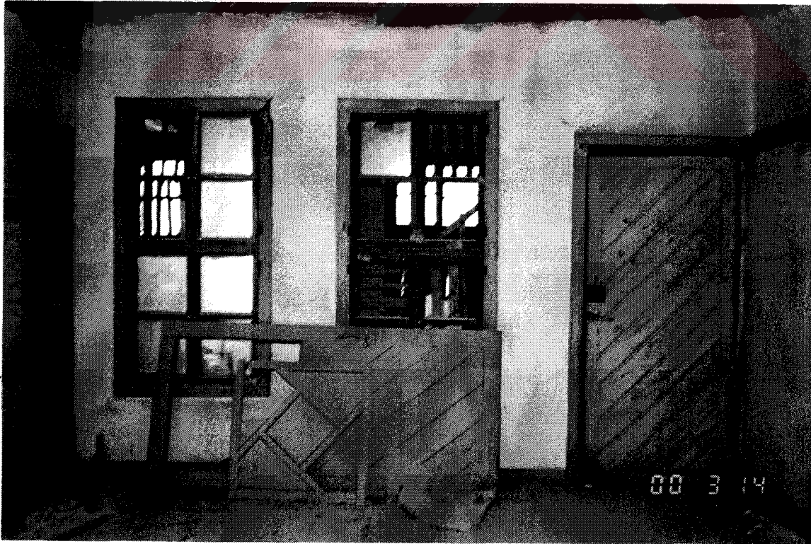
Şekil D158. Selamlık bölümü, 204 mekânı doğu duvarı (2000)
