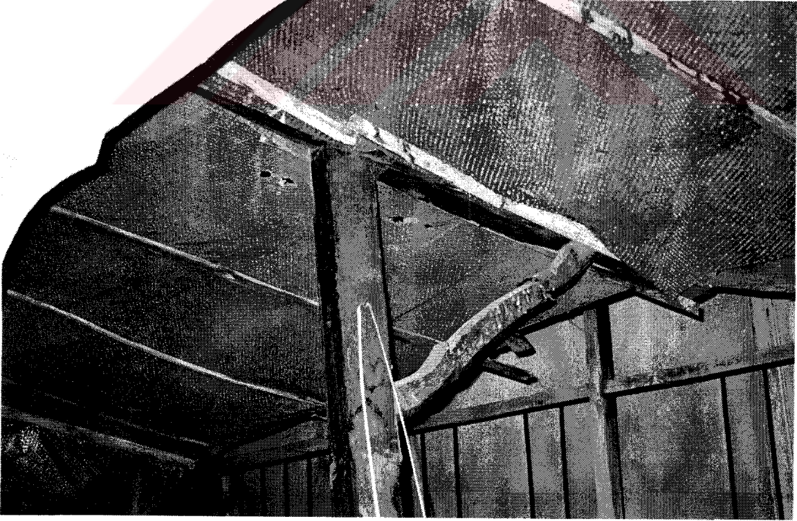
Şekil F69. Şekil F61'deki konutun saçağını taşıyan ahşap dikme ve payanda (2000)
