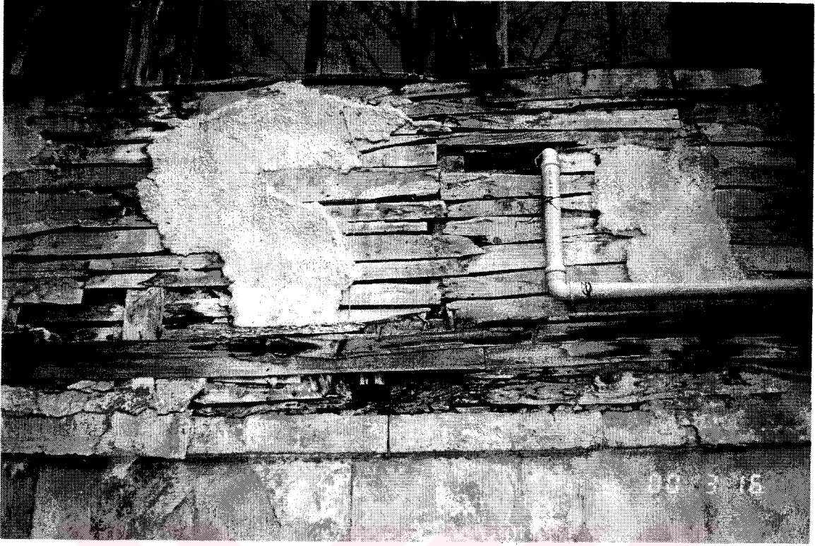
Şekil D173. Selamlık bölümü doğu cephesi sarnıç duvarı üzeri ahşap hatıl ve ahşap Konstrüksiyon
