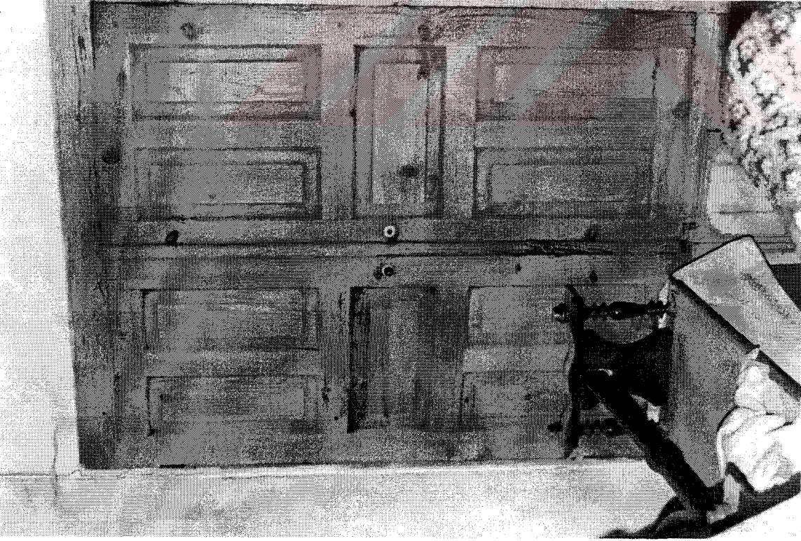
Şekil D97. Selamlık bölümü, 103 mekânı yüklük (1999)
