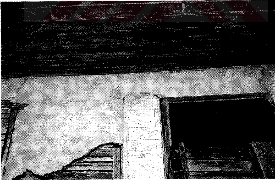
Şekil D198. Selamlık bölümü, köşk oda (202) doğu cephesi kalem işi bezemesi (2000)
