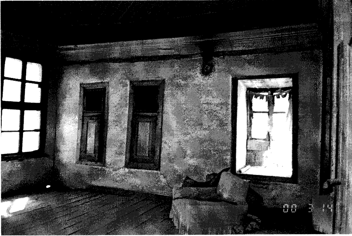
Şekil D145. Selamlık bölümü, 203 mekânı batı duvarı (2000)
