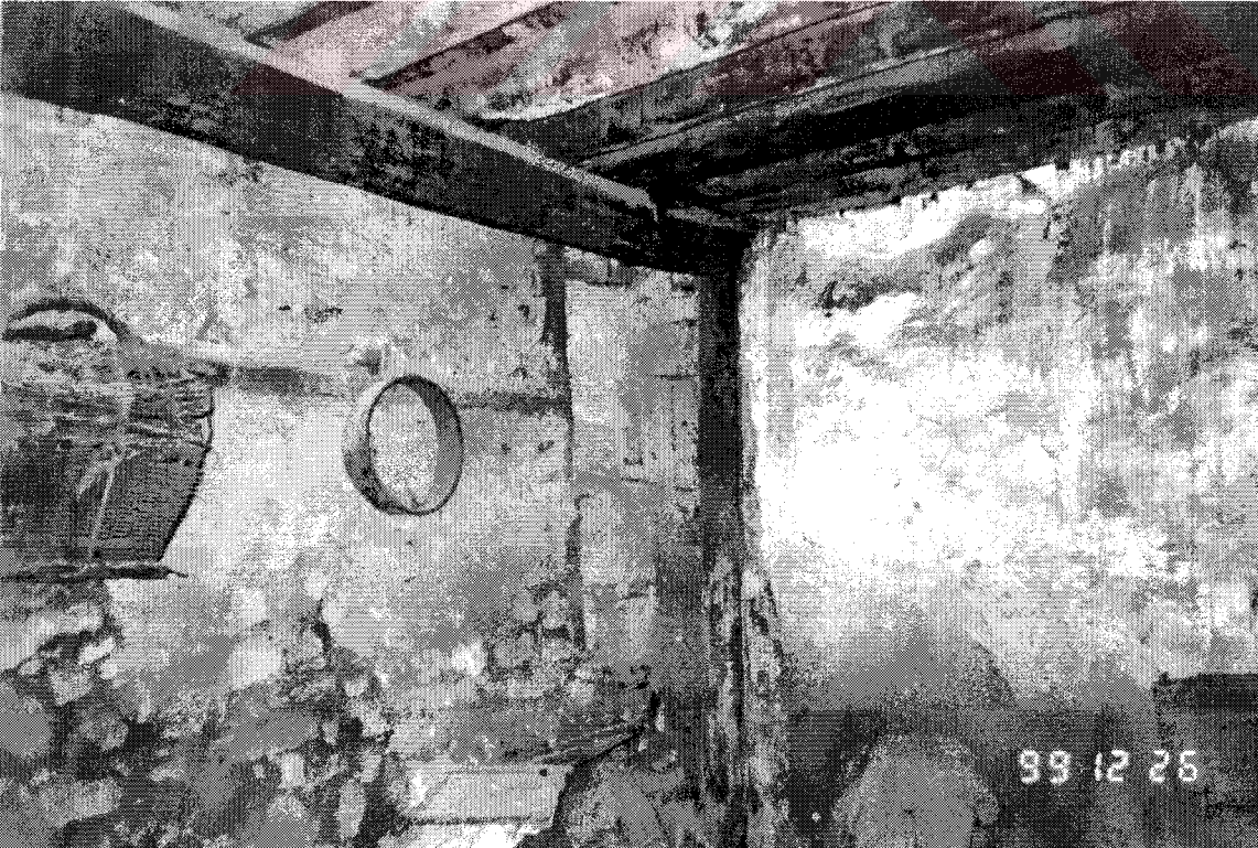
Şekil D66. Selamlık bölümü, soğuk depo (Z04) doğu ve kuzey duvarı birleşimi (1999)
