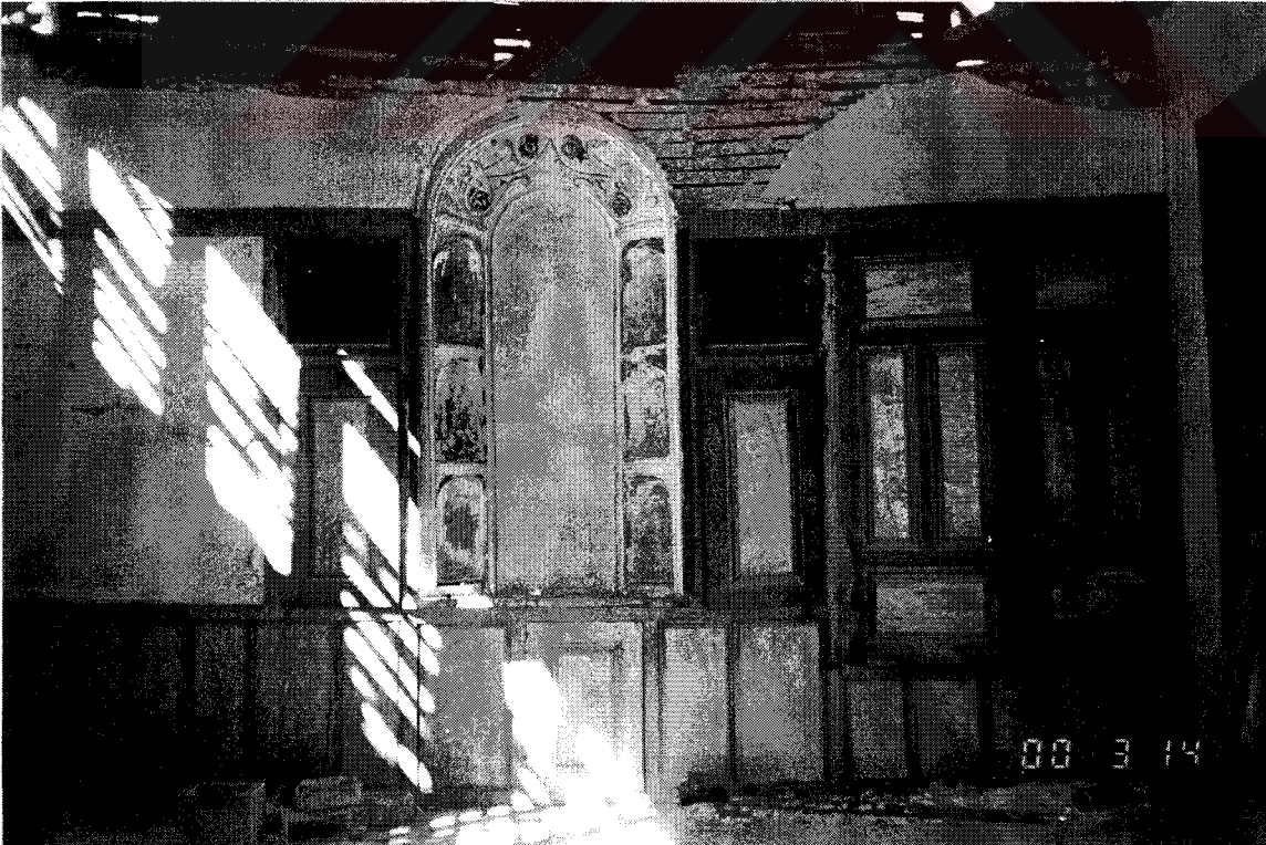
Şekil D162. Selamlık bölümü, 204 mekânı kuzey duvarı (2000)
