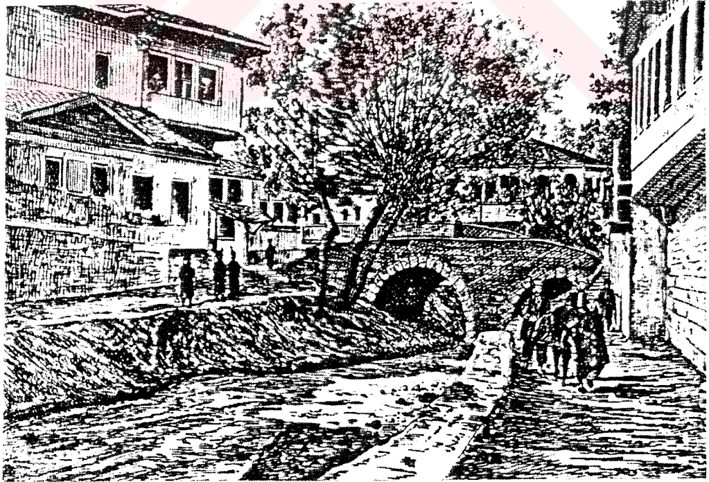
Şekil C6. Çay boyu ve etrafındaki ahşap konutlar (Jeancard, 1919)
