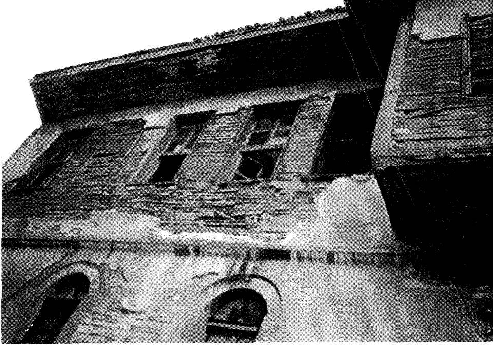
Şekil D8. Selamlık bölümü, giriş cephesi, normal kat pencereleri (1999)
