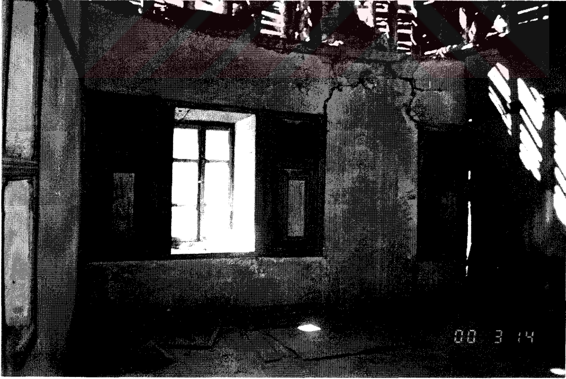
Şekil D160. Selamlık bölümü, 204 mekânı batı duvarı (2000)
