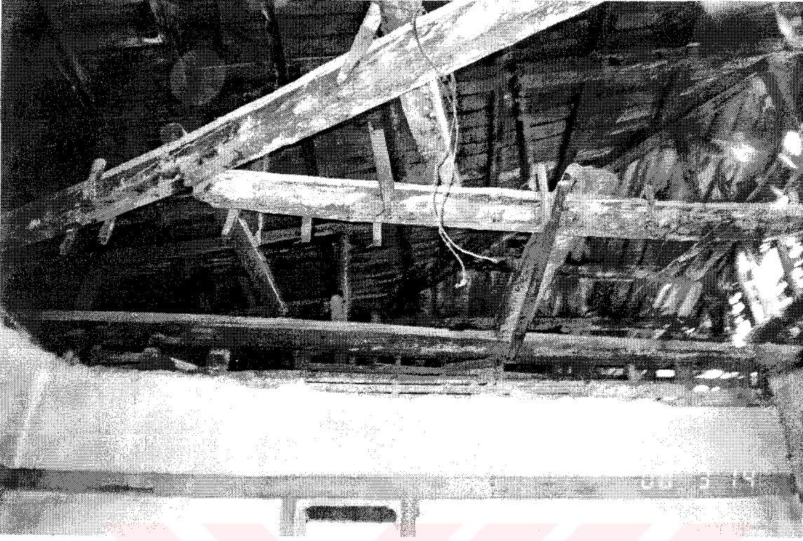
Şekil D169. Selamlık bölümü, 204 mekânı güney duvarı üzeri çatı konstrüksiyonu
