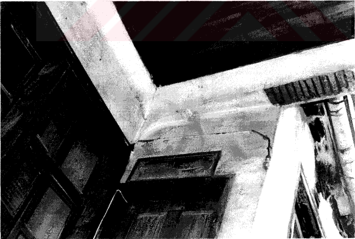
Şekil D40. Selamlık bölümü, giriş kapısı üstü Bursa kemer (1999)
