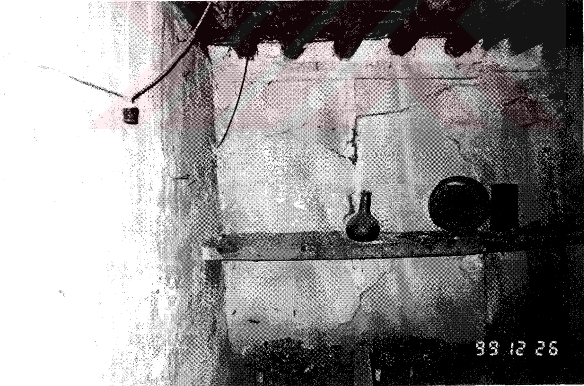
Şekil D60. Selamlık bölümü, kiler (Z03) rafı (2000)
