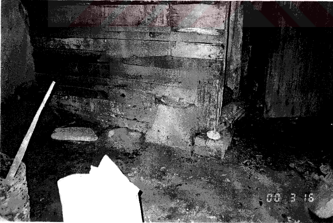
Şekil D56. Selamlık bölümü, kiler (Z03) mekânı ahşap bölme duvarı altında taş kaide (2000)
