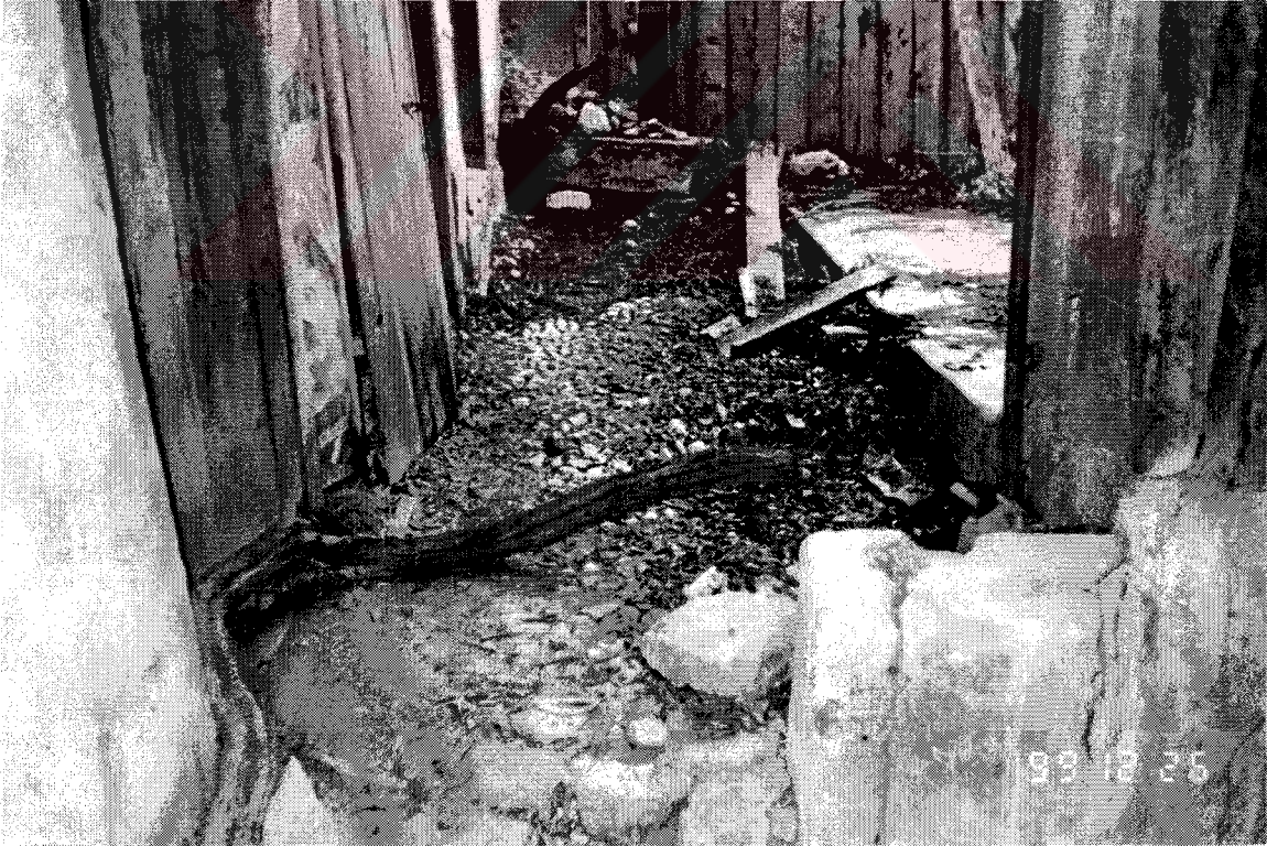
Şekil D43. Selamlık bölümü, avlu döşemesi (1999)
