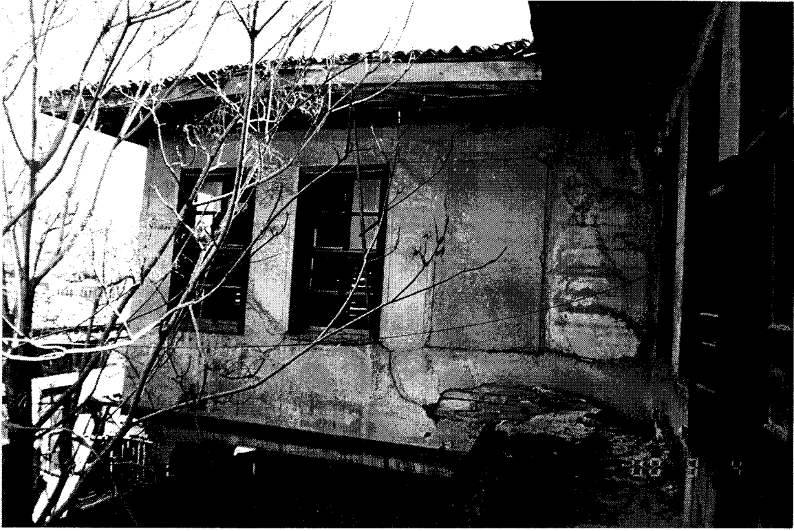
Şekil D28. Selamlık bölümü, köşk oda (202) kuzey (avlu) cephesi (1999)
