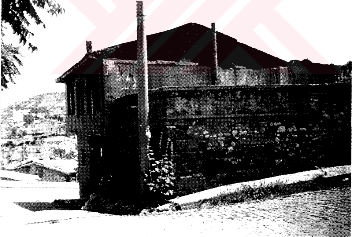
Şekil F28. Pazar Mahallesi, Karagöz Sokak, 346 ada, köşe konut (2000)
