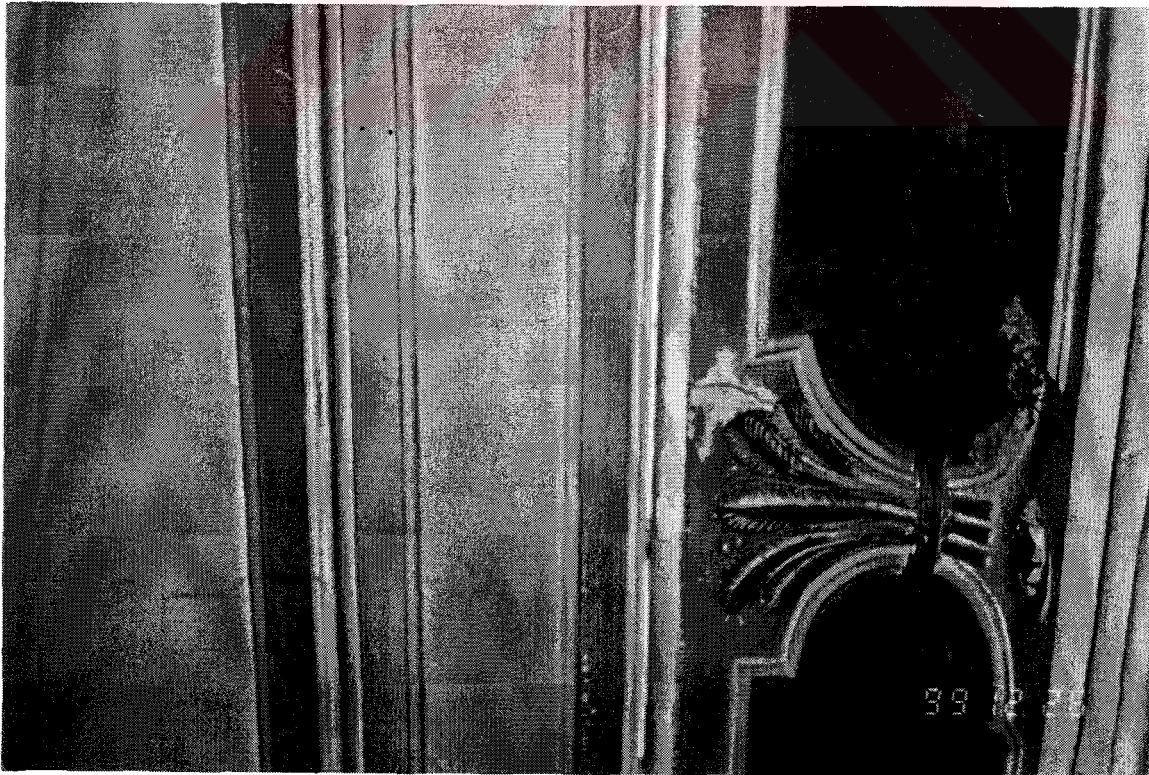
Şekil D138. Selamlık bölümü, 202 mekânı (köşk oda) eğrisel tavan geçişi, ay-yıldız motifi ve tavan profili (1999)
