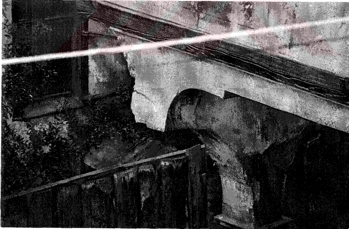
Şekil D200. Selamlık bölümü, köşk odanın (202) kuzey cephesi altında yer alan Bursa kemeri üzeri mavi renkli kalem işi bezeme (2000)
