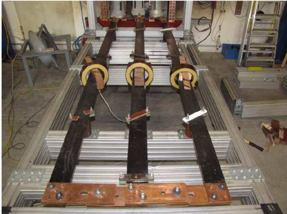
Şekil 5.3: Akım Transformatörlerinin fazlara bağlanması
