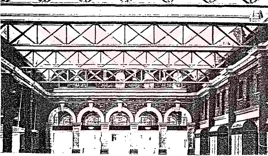
Sekil.4.34 Fish Market Binası'na ek
