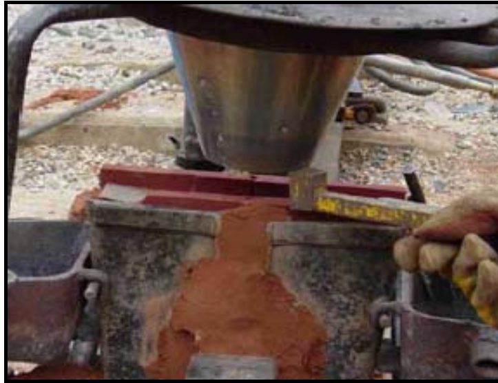
Şekil 4.19: Termit Potasının Yerleştirilmesi
