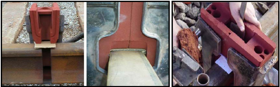
Şekil 4.17: Kaynak Kalıplarının Montajı ve Kumlama
