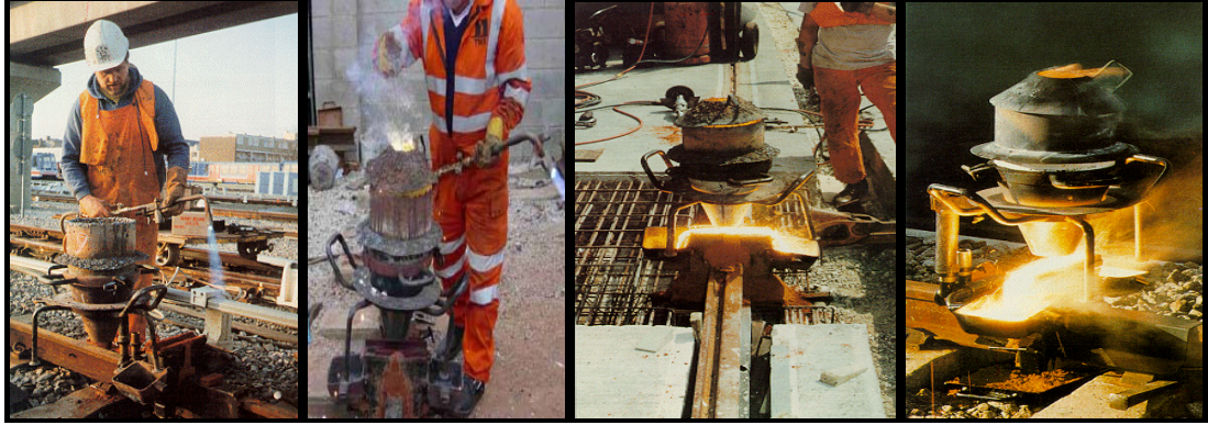
Şekil 4.20: Rayların Isıtılması Ve Termit Porsiyonun Erimesi
