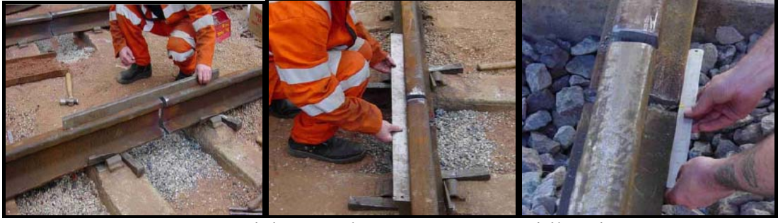
Şekil 4.15: Ray Yan Yüzeyinin Ve Tabanının Mastara Getirilmesi
