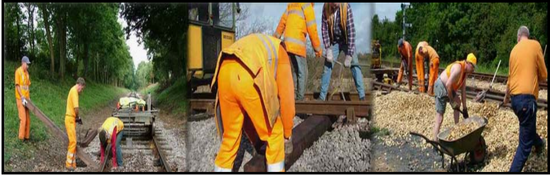
Şekil 4.22: Balastlı Hatlarda Travers Değiştirme
