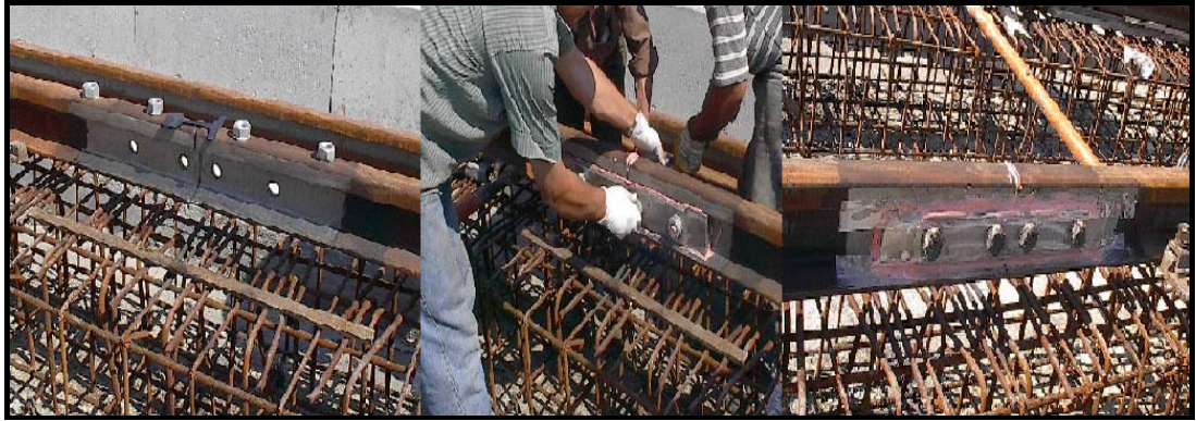
Şekil 4.37: Yeni İzolecebre Raylarının Yapılması
