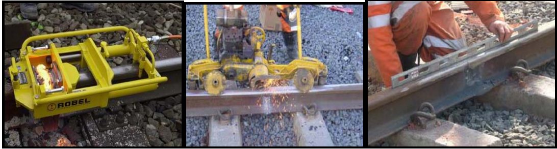
Şekil 4.21: Kaynağın Sıyrma Makinesi İle Tıraşlanması ve Rayın Taşlanması
