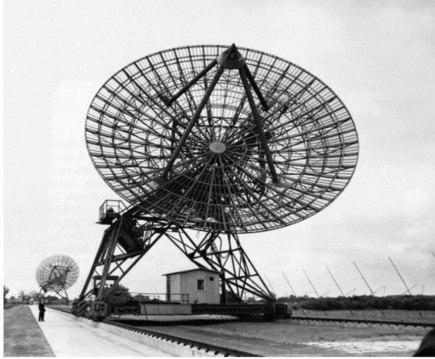
Şekil 2.7 : Yansıtıcı yüzeyleri ızgara biçiminde olan parabolik reflektör antenler.
