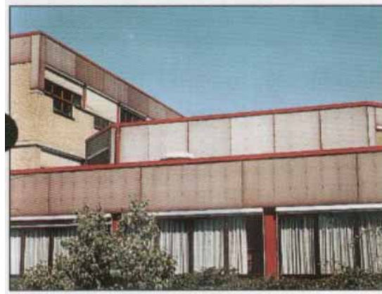
Şekil 5.1 : Okul kompleksinde HPL cephenin renginin ağarması.
