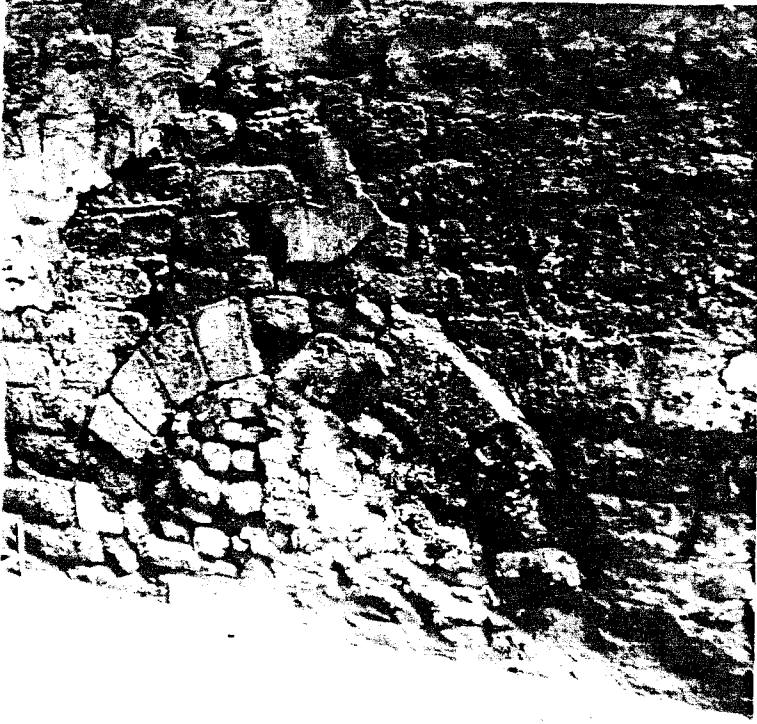
FOTO 75. Zemin kat duvarı üzerindeki örülü K 1 kemer ve duvar dokusu
