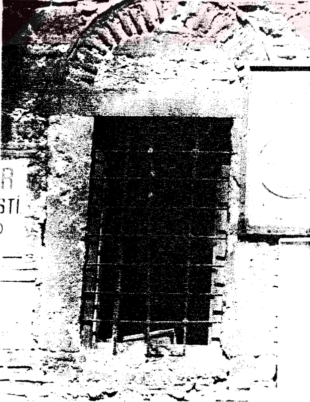
FOTO 18. Bakır Sokağı Cephesi 17 No'lu Pencere
