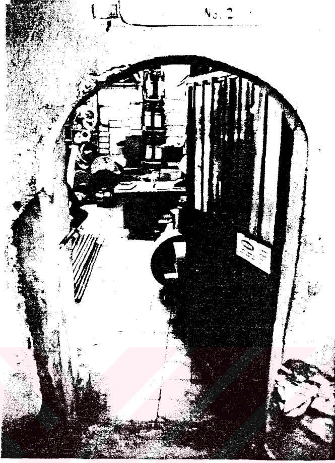
— FOTO 98. 102 nolu mekanın kapısı (K12)
