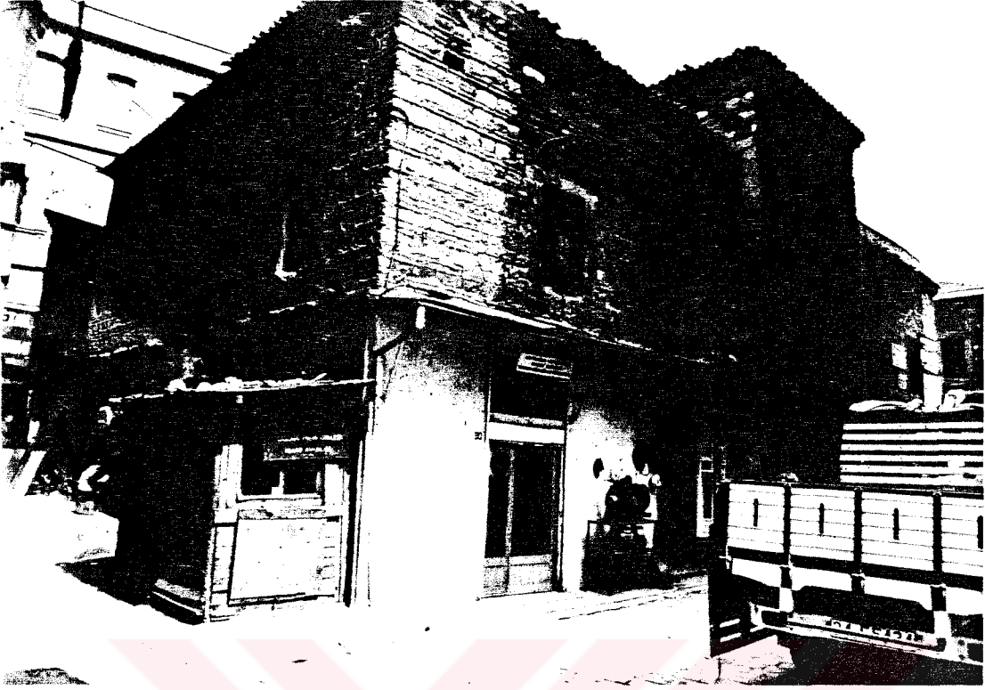
FOTO 7. Bakır Sokağı ve Zencefil Sokağı Köşesinden Bakış
