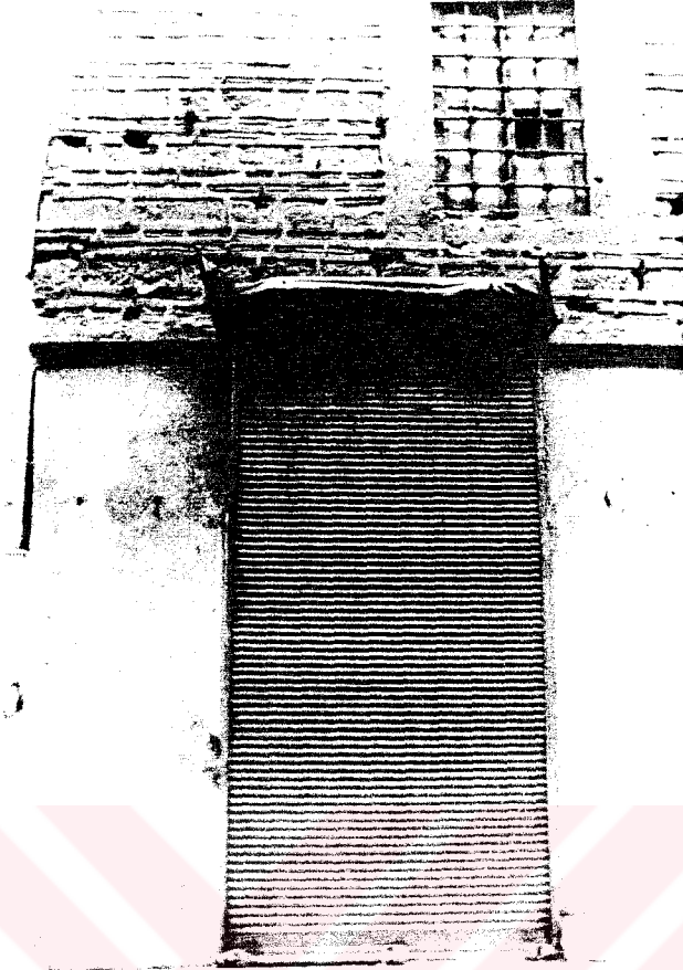
FOTO 28. Perşembe Pazarı Caddesi Cephesi, 09 no'lu kapı
