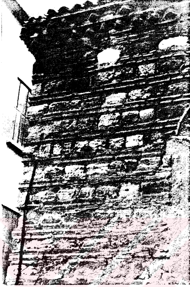
FOTO 17. Duvar örgüsü ve sol üst köşede bir kuşluk
