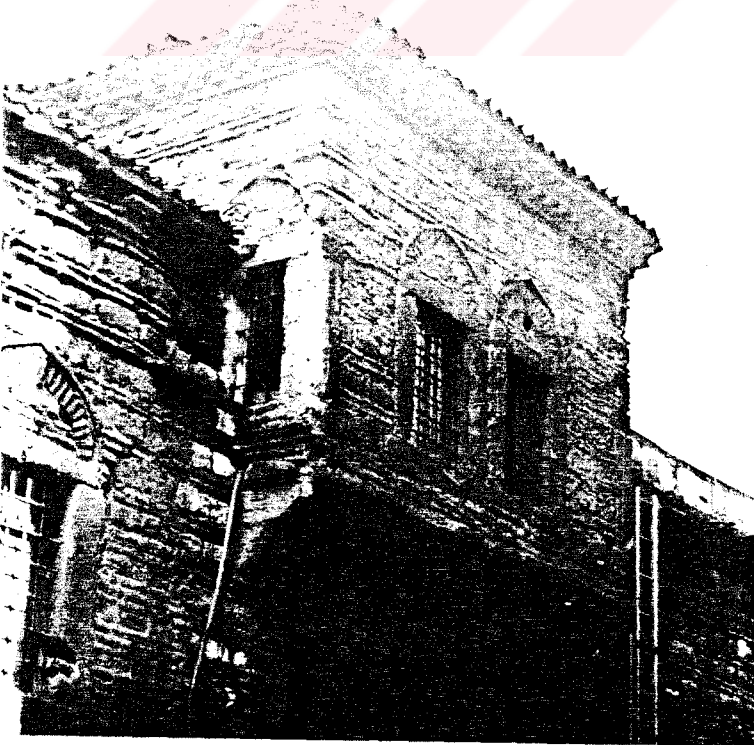
FOTO 10. Bakır Sokağı Cephesi Çıkma Kat ve Ara Kat
