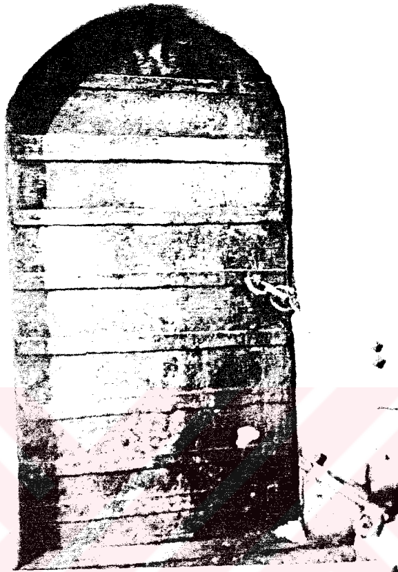
FOTO 112. 106 nolu mekanın kapısı (K16)
