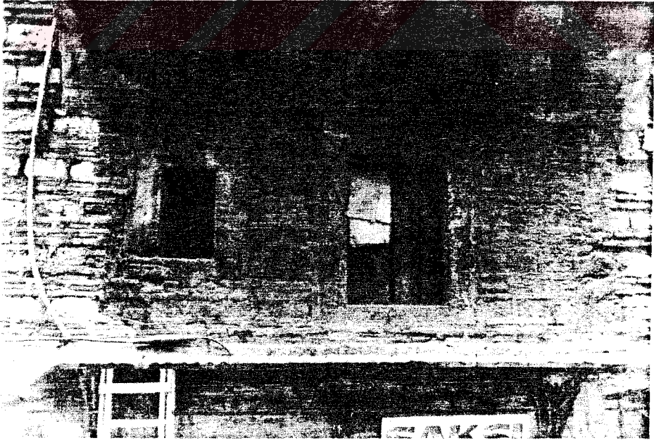
FOTO 14. Bakır Sokağı Cephesi, Solda 20 No'lu ve Sağda 19 No'lu Pencere
