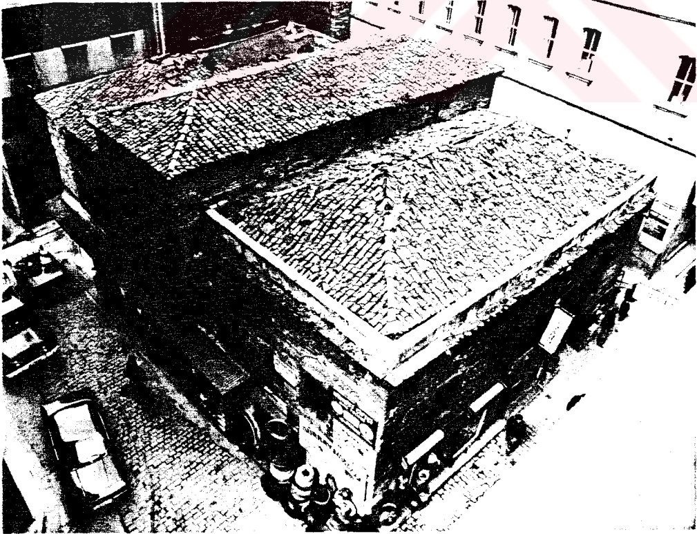
FOTO 80. Saksi Han'ın çatı örtüsü, Güney Yönünden
