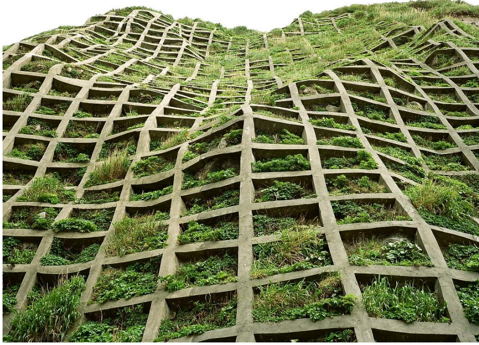
Şekil 2.15 : Japonya’da toprağı tutmak için uygulanan grid strüktür (Aslan, 2009).
