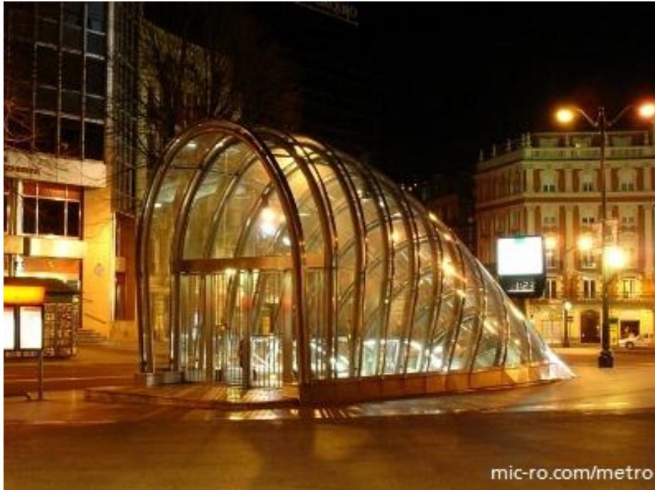
Şekil 3.16 : Bilbao’da metronun yeraltı girişi, Norman Foster (mic-ro.com/metro).
