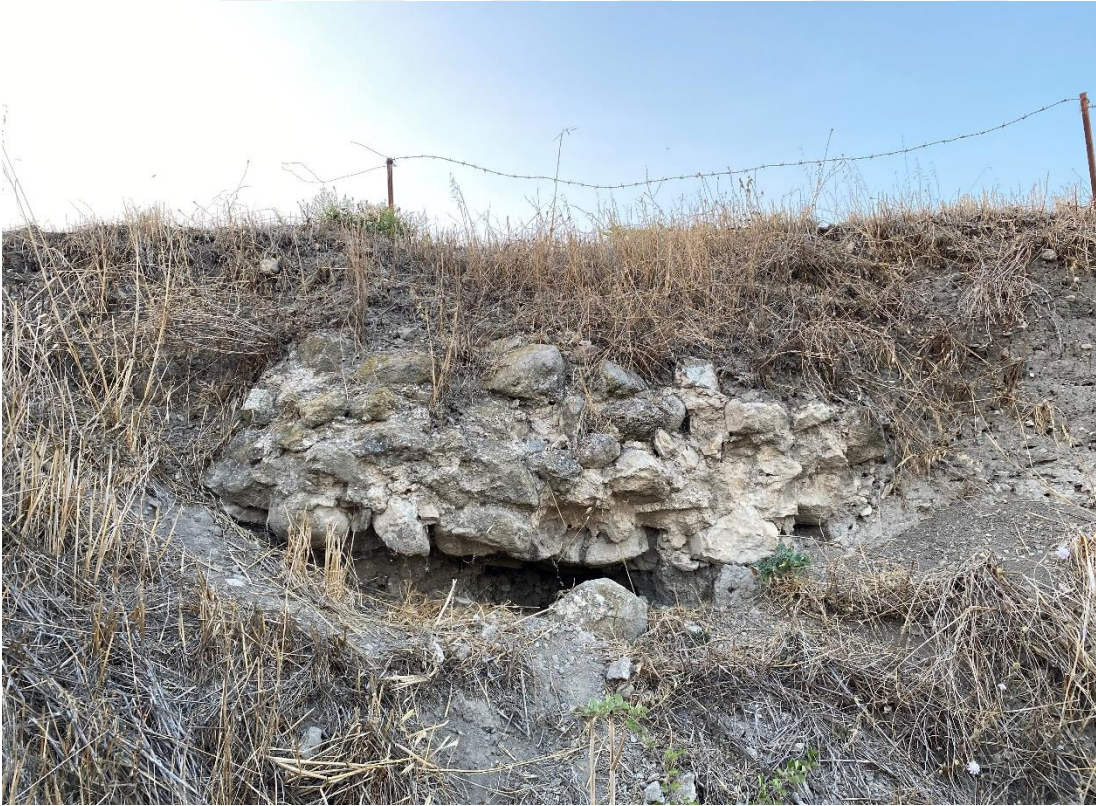
Şekil C.6 : Kule 3-Kule 4 Duvarı'nın toprak kayması sonucu görülen moloz dolgu yüzeyi (Kaymak, 2022)
