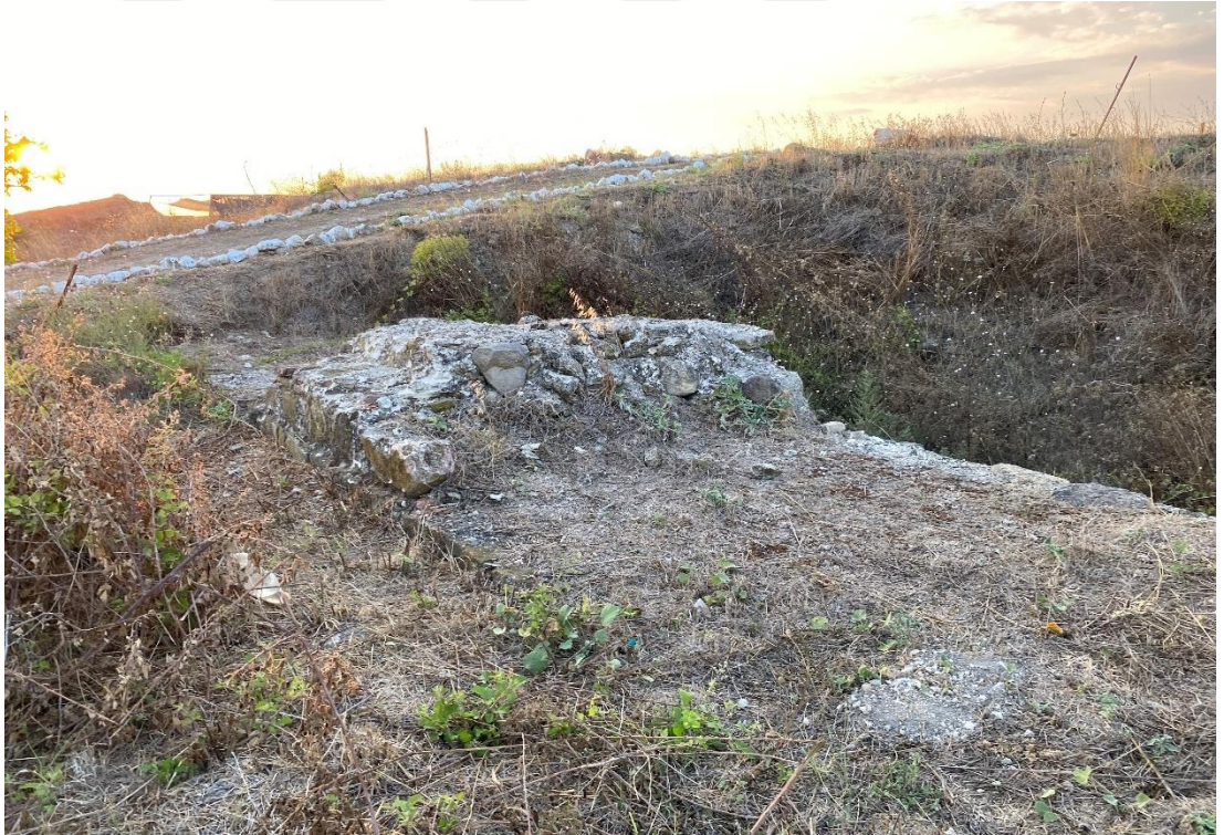
Şekil C.4 : Kule 2-Kule 3 Duvarı'nın güney cephesindeki kademelenme (Kaymak, 2022)
