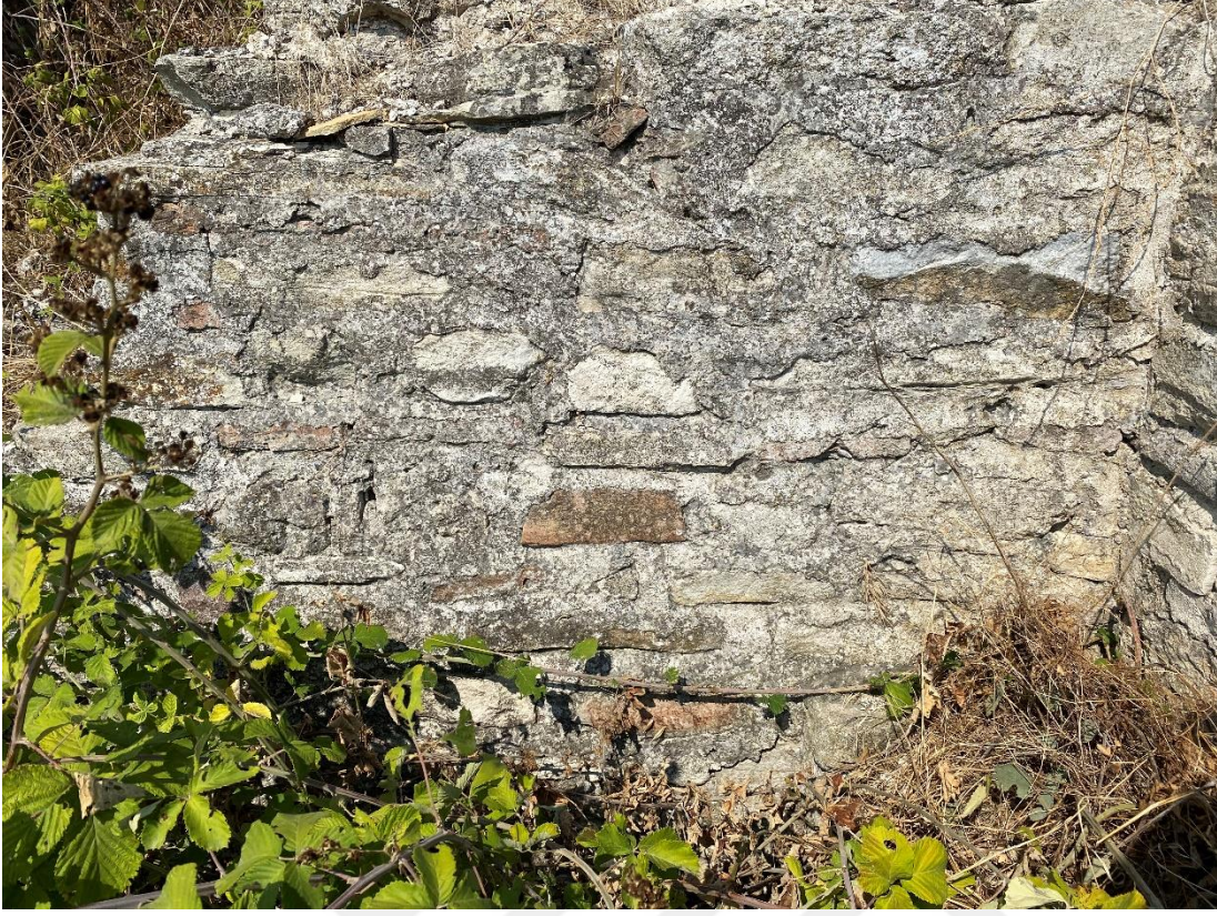
Şekil C.9 : Kule 6 boşluğunun doğu cephesindeki yoğun harçlı duvar örgüsü ve düzensiz tuğla sıraları (Kaymak, 2022)
