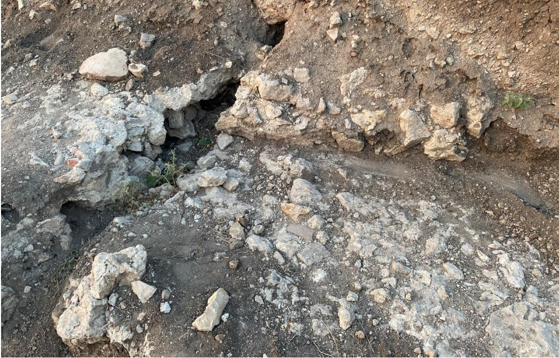
Şekil 3.17 : Kule 4'ün güney duvarındaki hatıl izi ve boşlukları (Kaymak, 2022)
