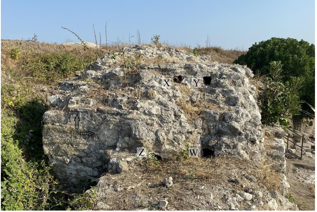
Şekil 3.21 : Kule 4 dolgusunun güney yüzeyindeki hatıl boşlukları ve izleri ve kule duvarının batıya doğru kırıldığı cephede sütun tamburu ve tuğla sırası (Kaymak, 2022)
