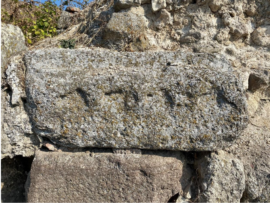
Şekil 3.23 : Ana kapının kuzey cephesinde, üzerinde kama oyuklarının izleri görülen andezit blok (Kaymak, 2022)
