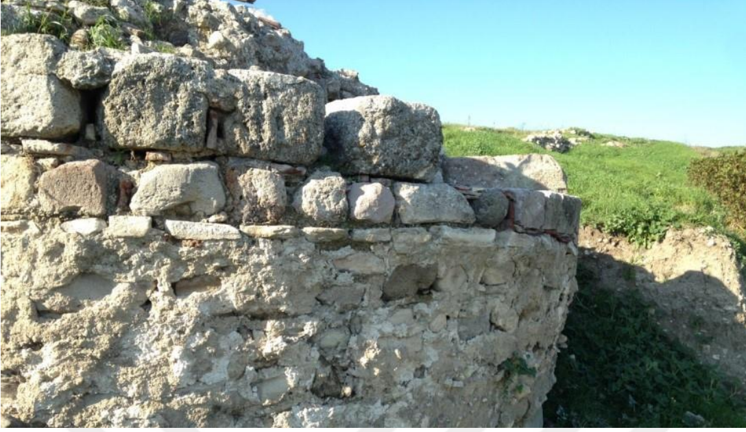
Şekil 3.24 : Restorasyon sürecinde in situ blokların altındaki tuğla sırası ve bloklar arasına dikey olarak yerleştirilen kırık tuğlalar (Daskyleion Kazı Arşivi, 2018)
