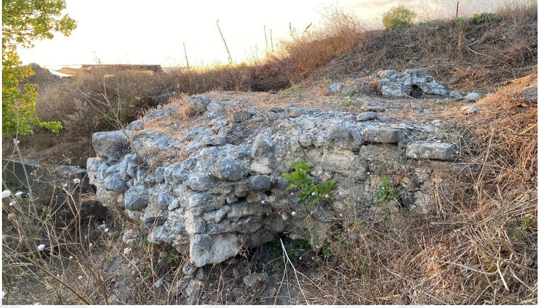
Şekil C.3 : Tahrip olan Kule 2 duvarının, beden duvarıyla bağlandığı güney cephe (Kaymak, 2022)
