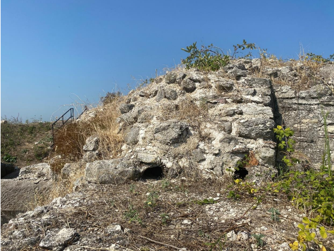
Şekil 3.25 : Kule 6 dolgusunun doğu yüzeyindeki mevcut hatıl boşlukları (Kaymak, 2022)
