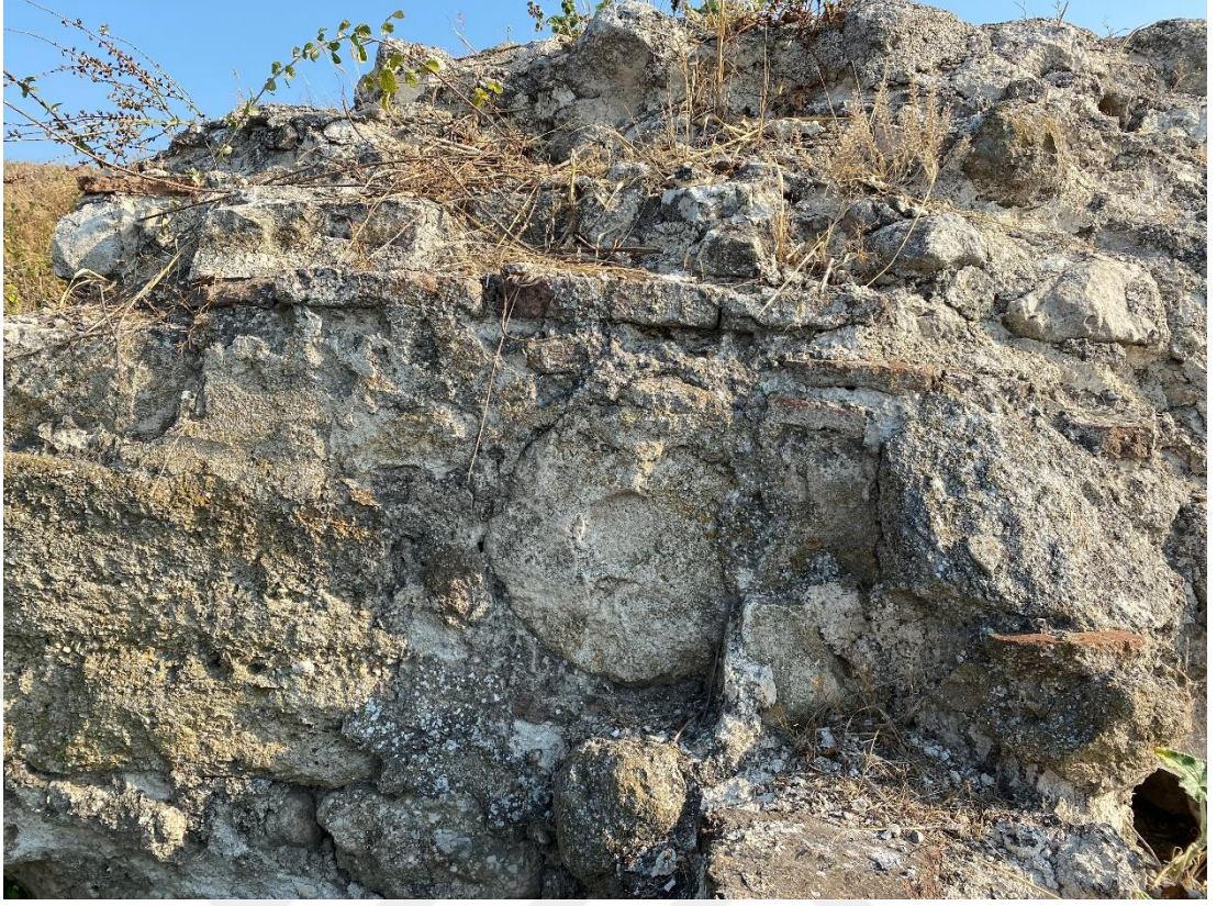
Şekil C.7 : Kule 5'in güney cephesindeki sütun tamburu ve tuğla sırası (Kaymak, 2022)
