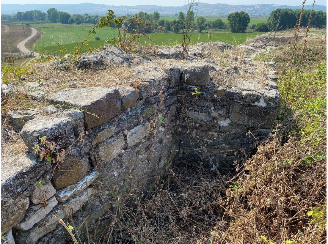
Şekil 3.27 : Kule 6'nın batı cephesi (Kaymak, 2022)
