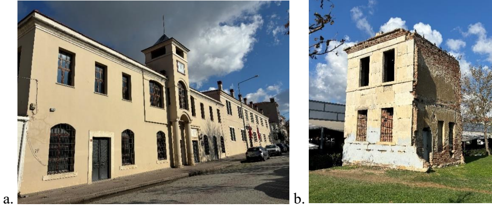
Şekil 2.10 : a. Kız Okulları yapısının günümüzdeki durumu. b. Günümüzde Selimpaşa İlkokulu olarak kullanılan okul yapısı. c. Erkek Okulu (Elenion) yapısı kalıntısı. (Fotoğraflar. N. C. Karagülle, 2025)
