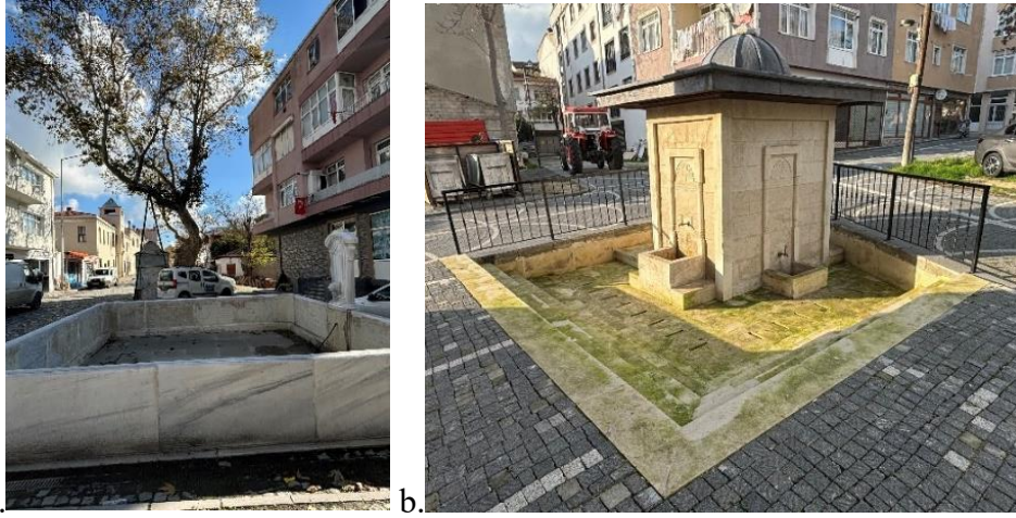
Şekil 2.17 : a. İkizli Çeşme'nin yanında bulunan havuzlu çeşme. b. Yukarı Çeşme Sokak çeşmesi. (Fotoğraflar N.C. Karagülle, 2025)
