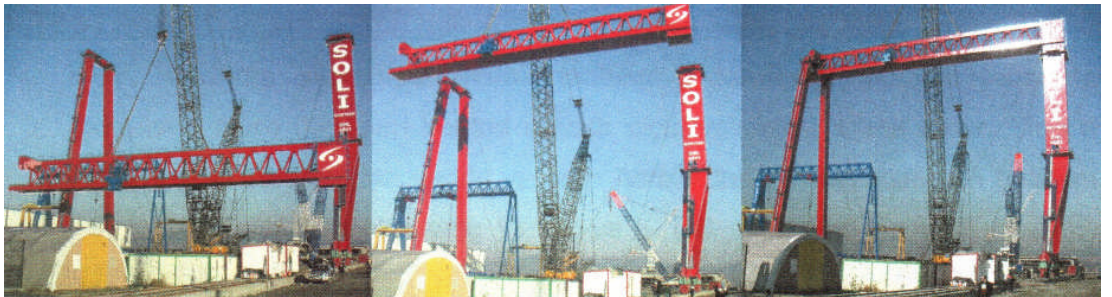
Şekil 3.14: Ana Kiriş Montajı
