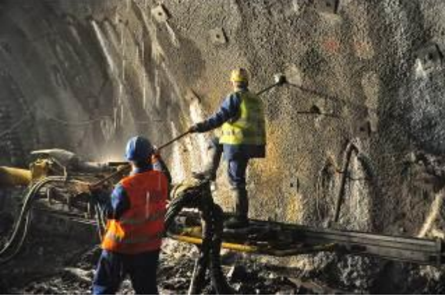
Şekil 2.9: NATM ile kazılan tünelde kaya bulonu uygulaması
