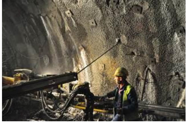
Şekil 2.9: NATM ile kazılan tünelde kaya bulonu uygulaması
