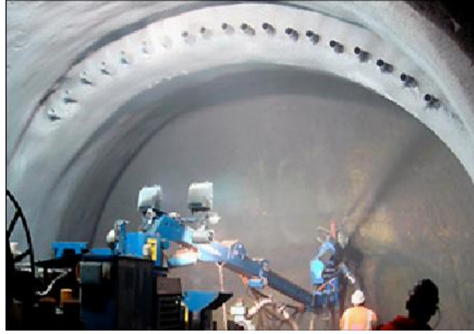
Şekil 2.8 : NATM ile kazılan tünelde püskürtme beton uygulaması
