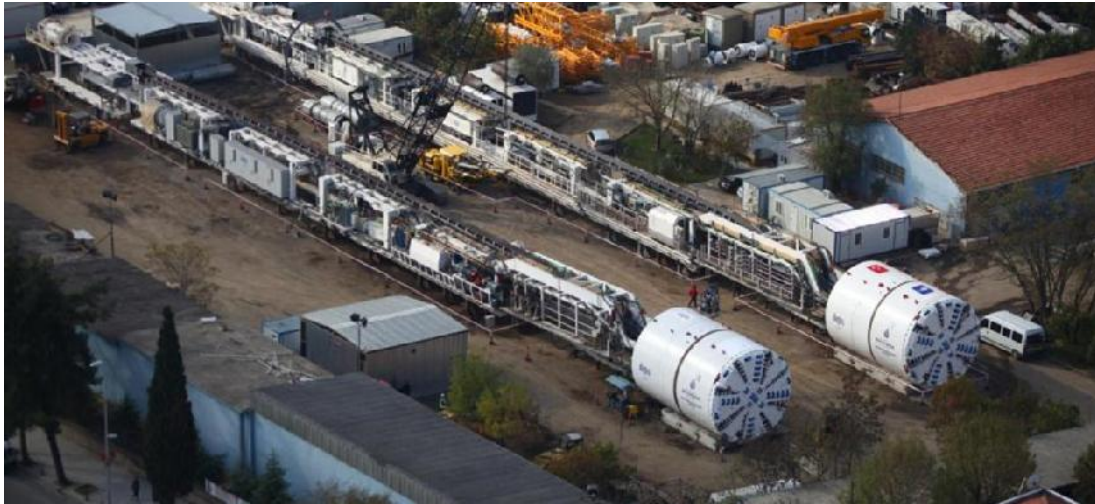
Şekil 2.2 : TBM Montajı
