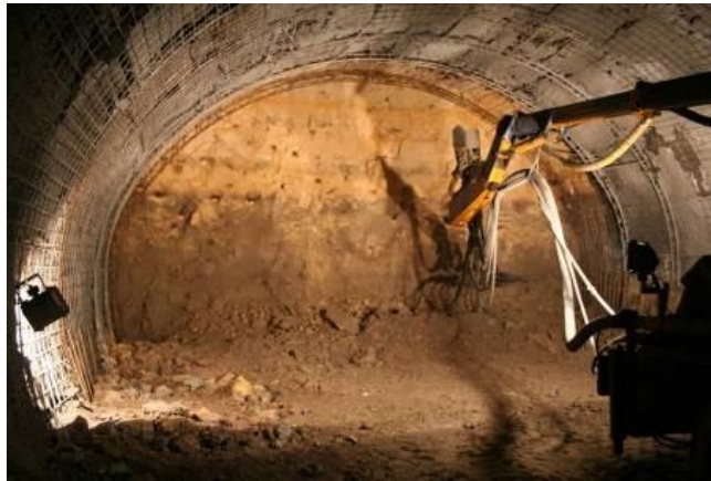
Şekil 2.10 : NATM ile kazılan tünelde hasır çelik ve iksa uygulaması
