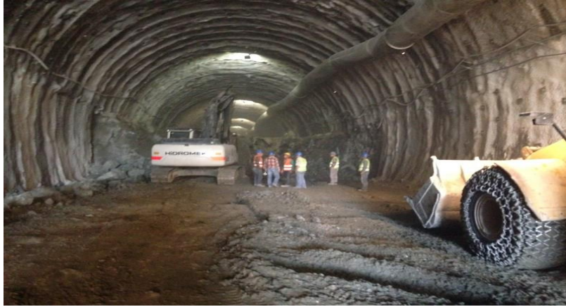
Şekil 4.29: Yerköy-Sivas altyapı ikmal işleri kesim 1 (t - 1 tüneli çıkışı) alt yarı kazısı.
