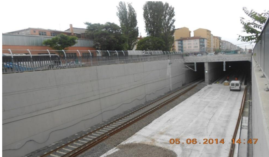
Şekil 4.25: Eskişehir Gar geçişi imalatları devam ederken.
