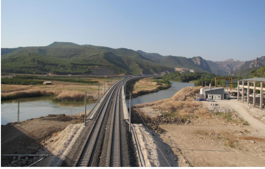
Şekil 4.20: Eskişehir-İstanbul hattı Sakarya geçişi Viyadük 14 ve 14A.
