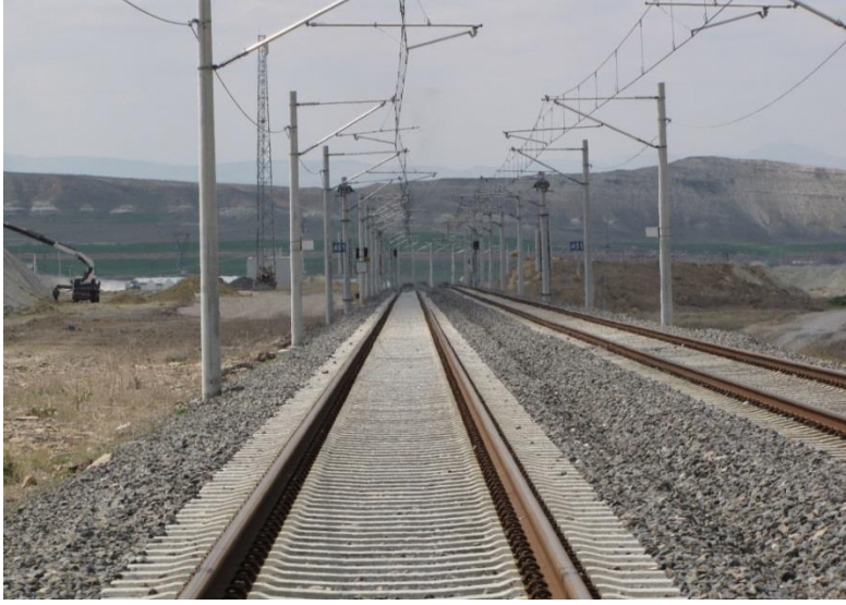
Şekil 4.6: Ankara-Konya hattı imalatları tamamlanmış.
