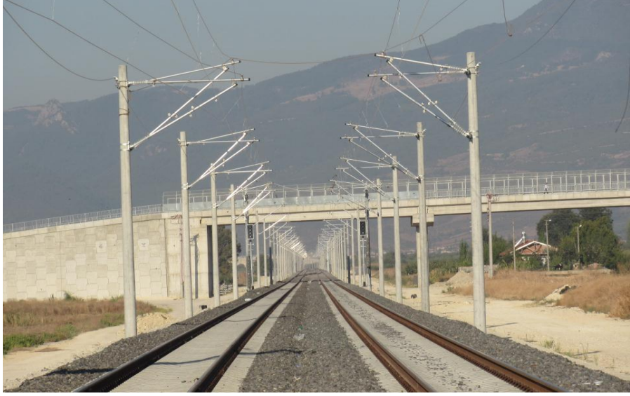
Şekil 4.18: Eskişehir-İstanbul hattı Pamukova -Mekece Üstgeçit 5- Üstgeçit 6 arası.
