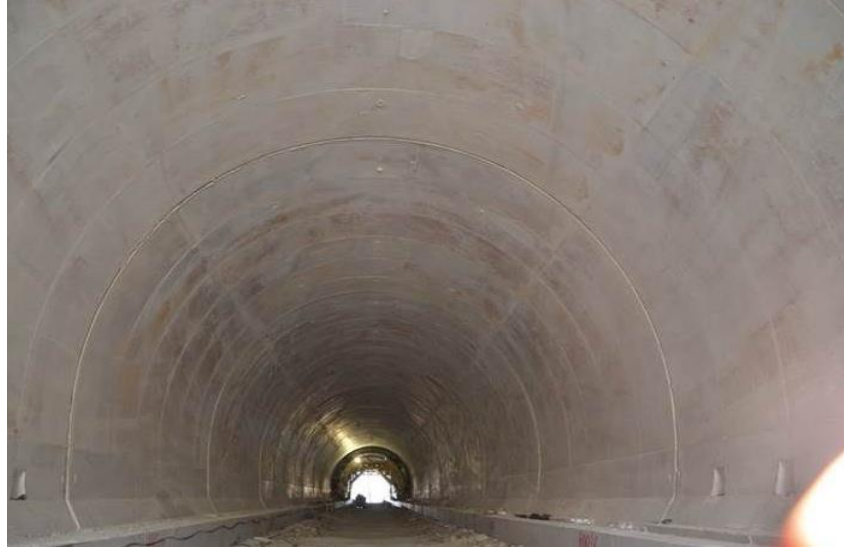
Şekil 4.42: Bursa- Yenişehir Tünel 5 (KM.61+190.00-61+420.00).
