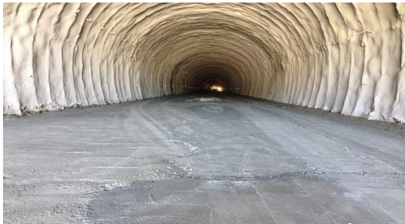
Şekil 4.30: Yerköy-Sivas altyapı ikmal işleri kesim 1 (t - 2 tüneli çıkışı) tünel içi grobeton tamamlandı.
