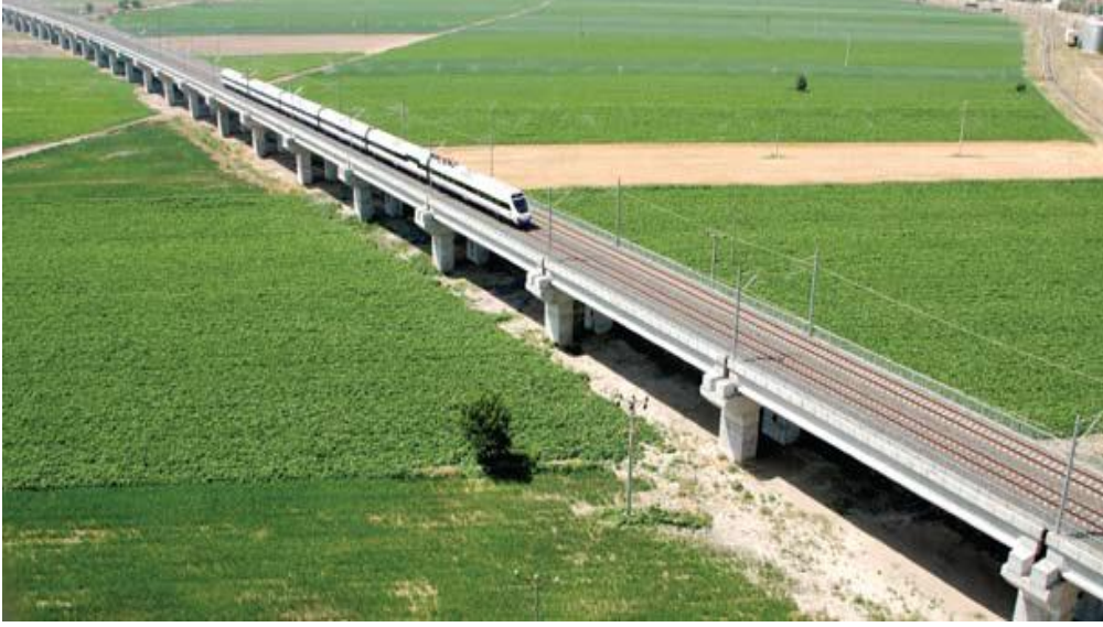
Şekil.4.13 : Sakarya nehri üzerinden geçen hızlı tren güzergâhında 2370 m uzunluğundaki Türkiye'nin en uzun viyadüğü görseli
