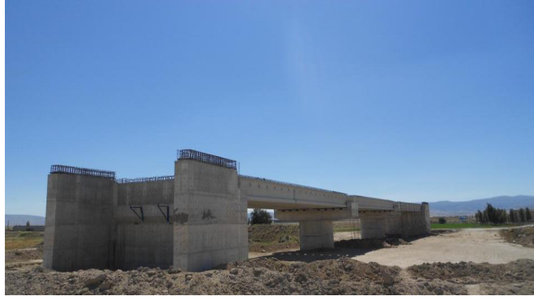
Şekil 4.35: Polatlı- Afyonkarahisar arası Akarçay Köprüsü (2013).
