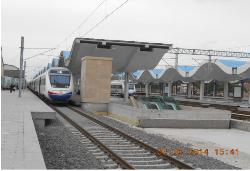
Şekil 4.26: Eskişehir Gar geçişi imalatları tamamlandıktan sonra.
