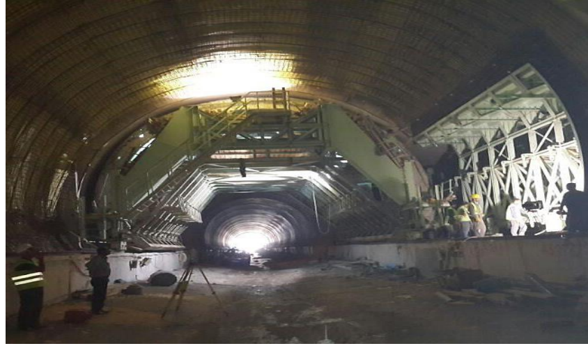
Şekil 4.32: Yerköy-Sivas altyapı ikmal işleri kesim 3 t9 tüneli (428+905 – 431+050).
