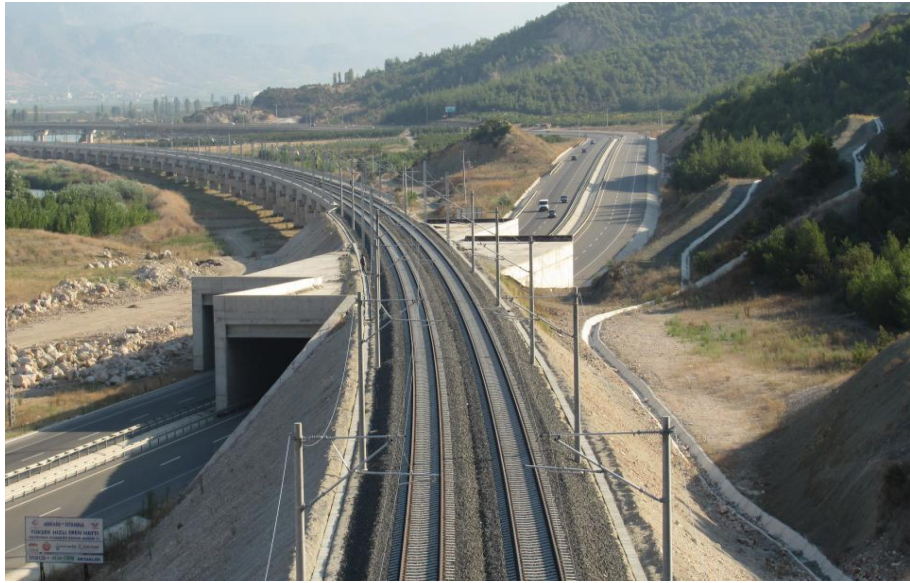
Şekil 4.19: Eskişehir-İstanbul hattı Mekece-Osmaneli Tünel 10 girişi.
