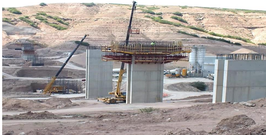
Şekil 4.33: Yerköy-Sivas altyapı ikmal işleri kesim 3 (Viyadük 446).
