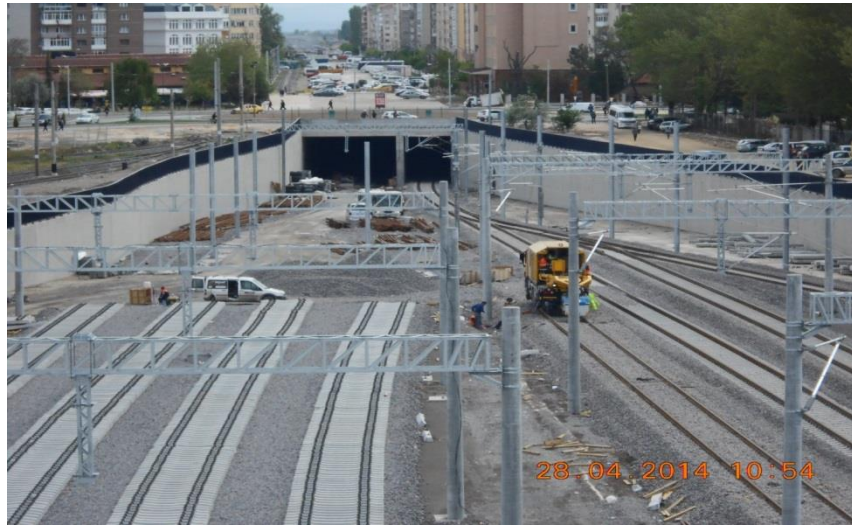
Şekil 4.24: Eskişehir Gar geçişi imalatları devam ederken.
