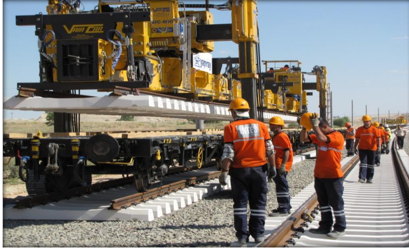
Şekil 4.5 : Ankara-Konya hattında kullanılan B70 tipi beton traversler yerleştirilirken.
