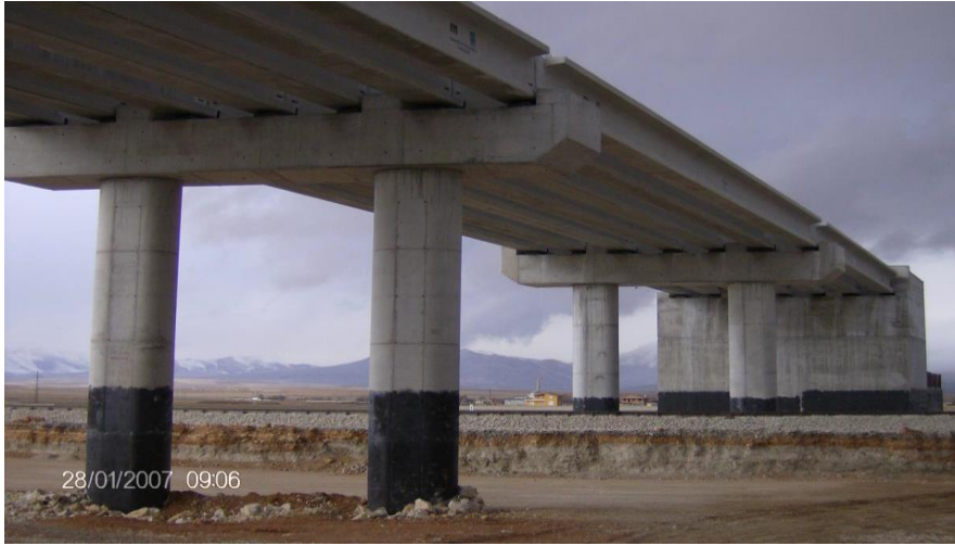
Şekil 4.3 : Ankara-Konya hattı 1. kesim üstgeçit inşaatı (Km:0+000-Km:100+000 arası).
