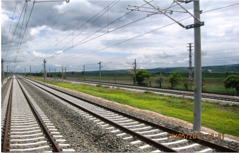
Şekil 4.21 : Eskişehir- İnönü arası elektrifikasyon ve sinyalizasyon işleri.
