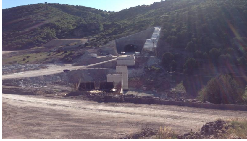
Şekil 4.31: Yerköy-Sivas altyapı ikmal işleri kesim 1 t - 3 tüneli çıkışı ile v293 viyadüğü görünümü.
