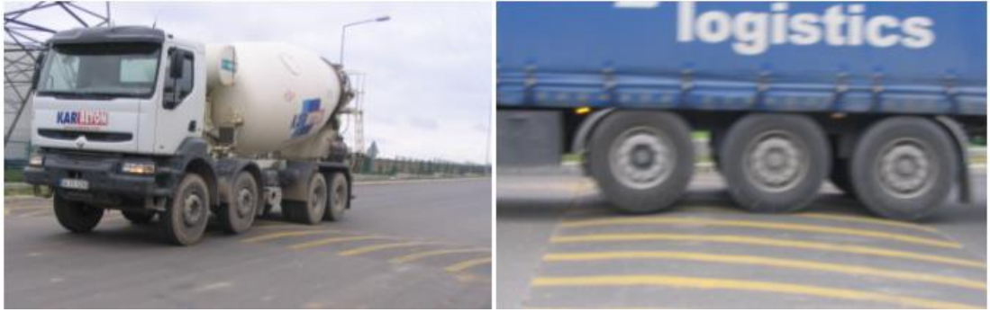
Şekil 6.7: TOSB’de bulunan TSE 6283 standardına uygun hız tümsekleri
