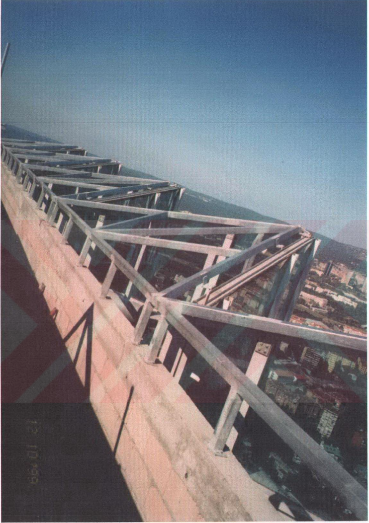
Şekil C.19 İŞ BANKASI Panel Montajı - Üst bitiş panelleri konstrüksüyonu
