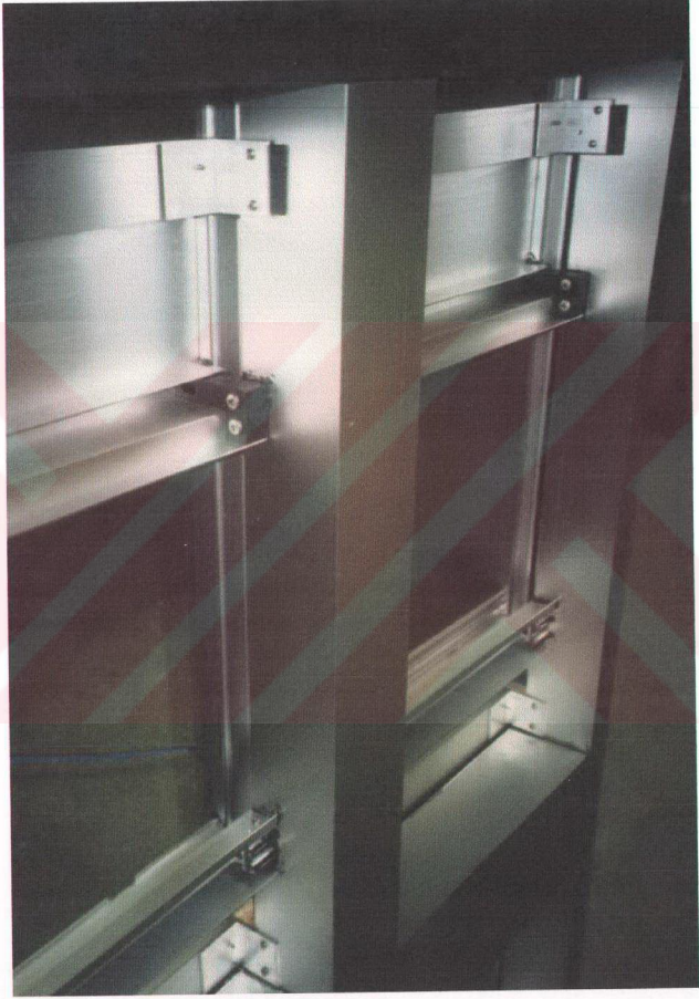
Şekil 3.7 İş Bankası Paneli çerçeve profillerinin birleştirilmiş görünümü
