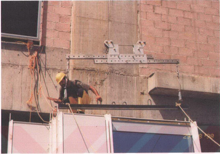
Şekil 3.13 İş Bankası Panel Montajı; panellerin binadaki yerlerine taşınmasını sağlayabilmek için monoray vincine bağlanması
