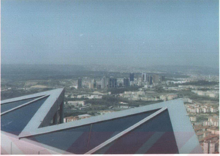
Şekil C.20 İŞ BANKASI Panel Montajı - Üst bitiş panellerinin konstrüksüyona bağlanmış ve üstü kapatılmış hali
