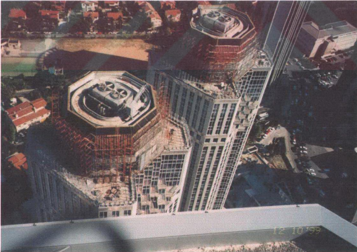
Şekil C.23 Genel Görünüş – İŞ BANKASI kuleleri
