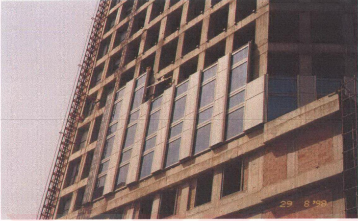
Şekil 3.12 İş Bankası Panel Montajı; aşağıdan yukarıya doğru örülerek yerlerine yerleştirilen paneller
