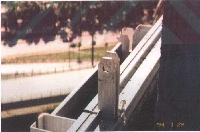
Şekil 3.14 İş Bankası Panel Montajı - Panelleri vinçle taşımaya ve birbirine kenetlemeye yarayan çift işlevli askı lamaları
