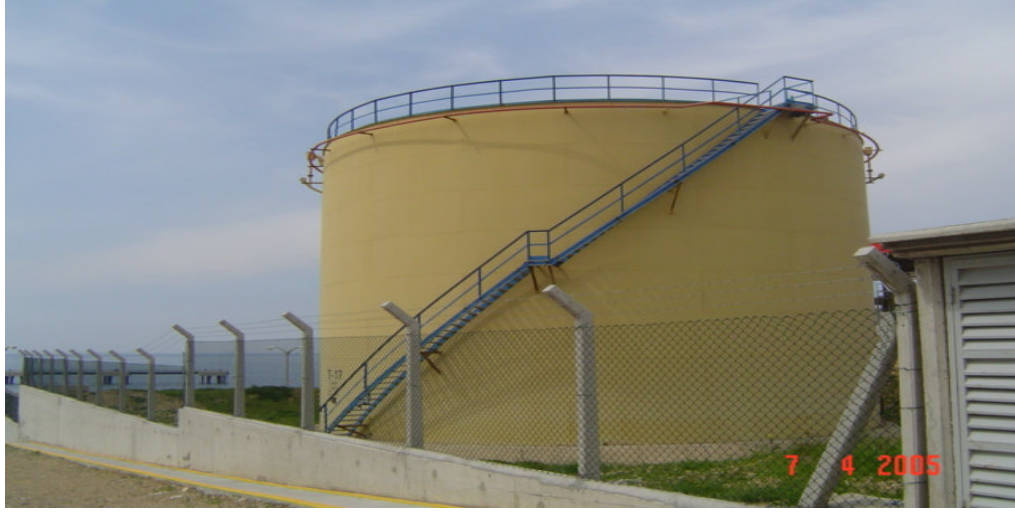
Şekil 6.1: Total Oil T.A.Ş. Aliğa Terminali Atık Depolama Tankı
