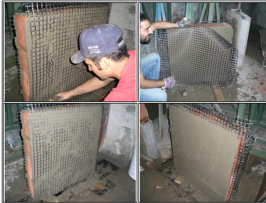
Şekil 2.7: Ağın (SRG45) harcın içine iyice yerleştirilmesi ve harç ile ağın üzerinin kapatılması.
