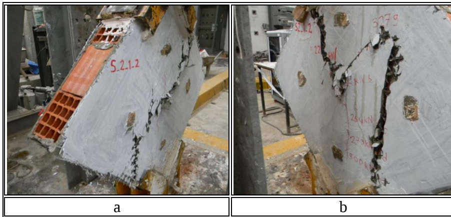
Şekil 2.27: S-2-1-2 numunesinin göçme sonrası durumu a) ön yüz, b) arka yüzü.
