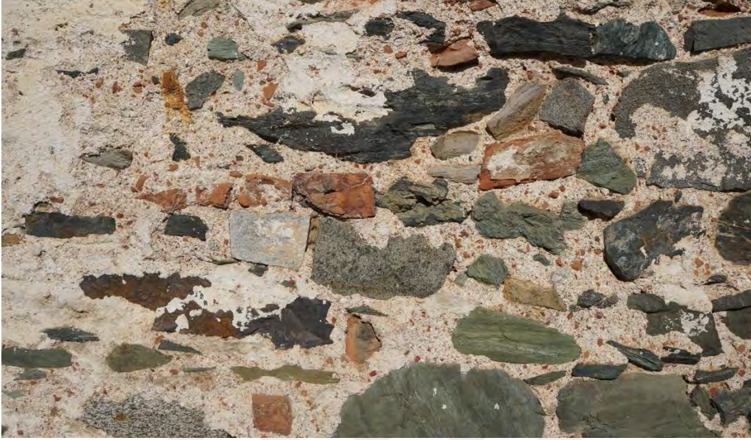
Şekil 4.18: Taş örgü ve horasan harcı.
