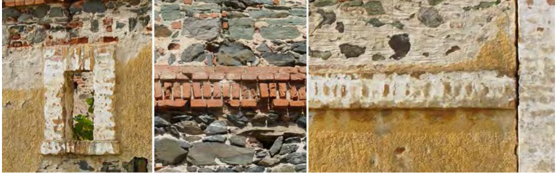
Şekil 4.10: Tuğla söveli pencere açıklığı ve kat silmesi (Y01).
