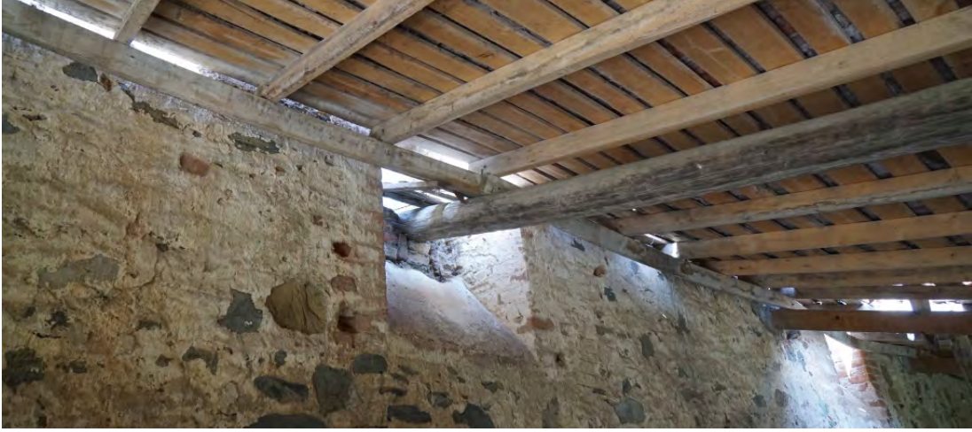
Şekil 4.50: Muhdes yapı ve kuzey duvarı (Y01).
