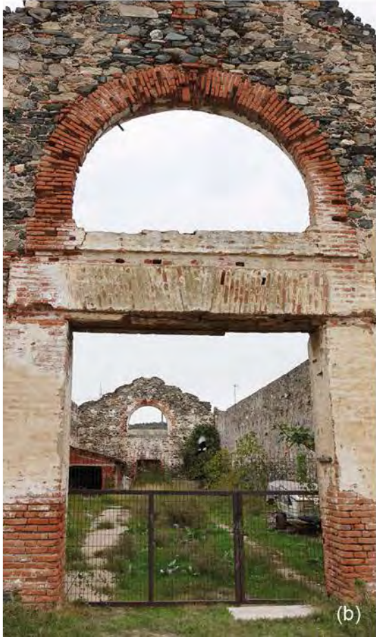
Şekil F.14: Y01 kapı ve pencere açıklıkları.
