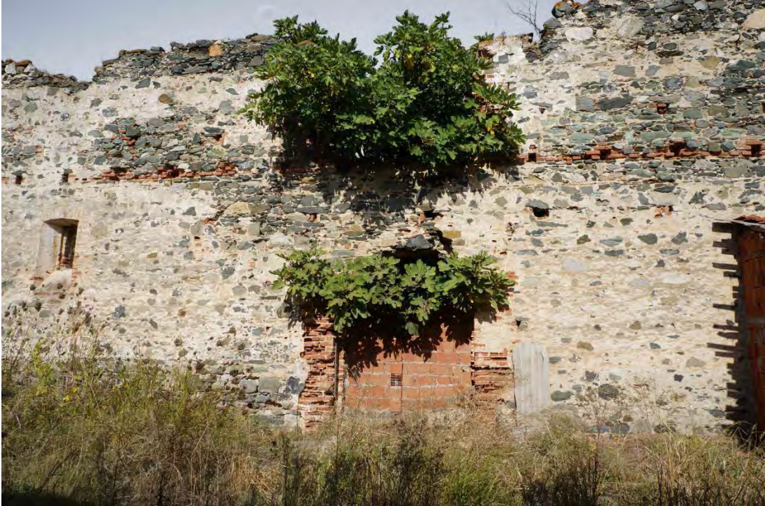
Şekil 4.52: Kuzey duvarı (Almaç, 2019).
