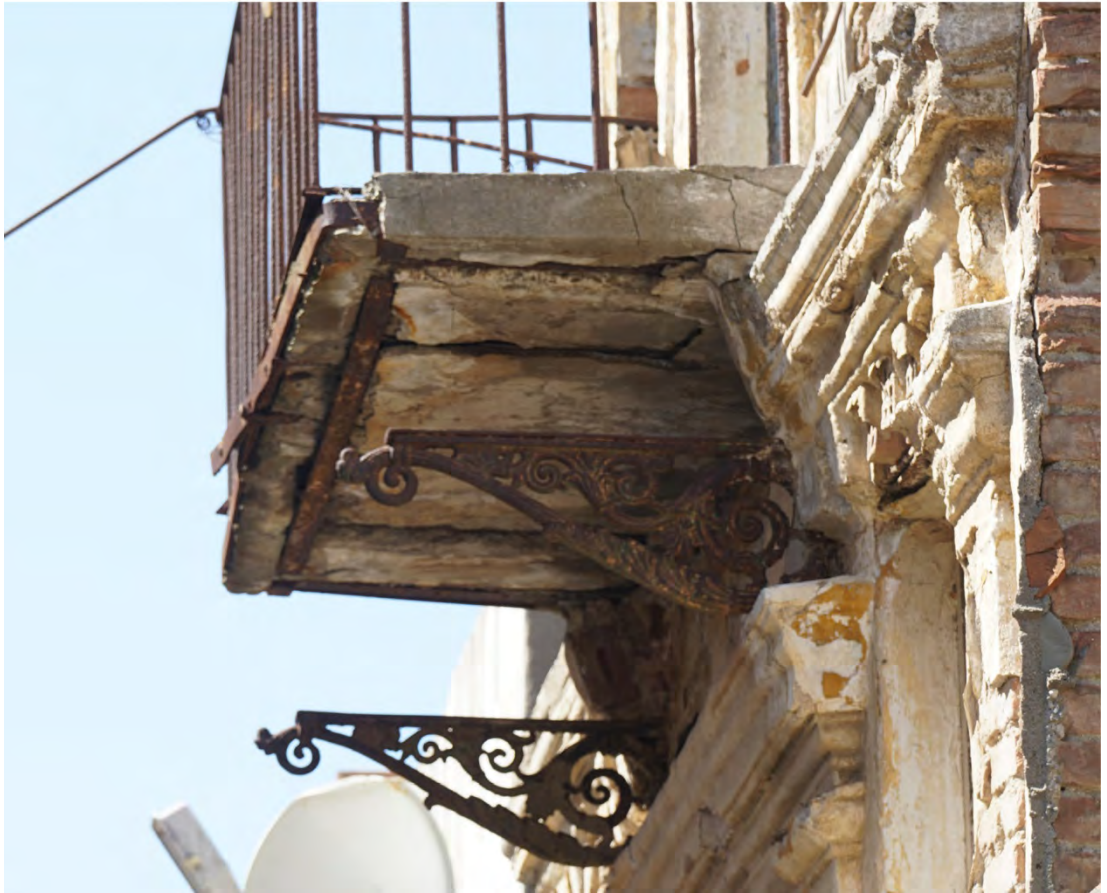
Şekil F.45: Paraçol detayı, Mürefte.
