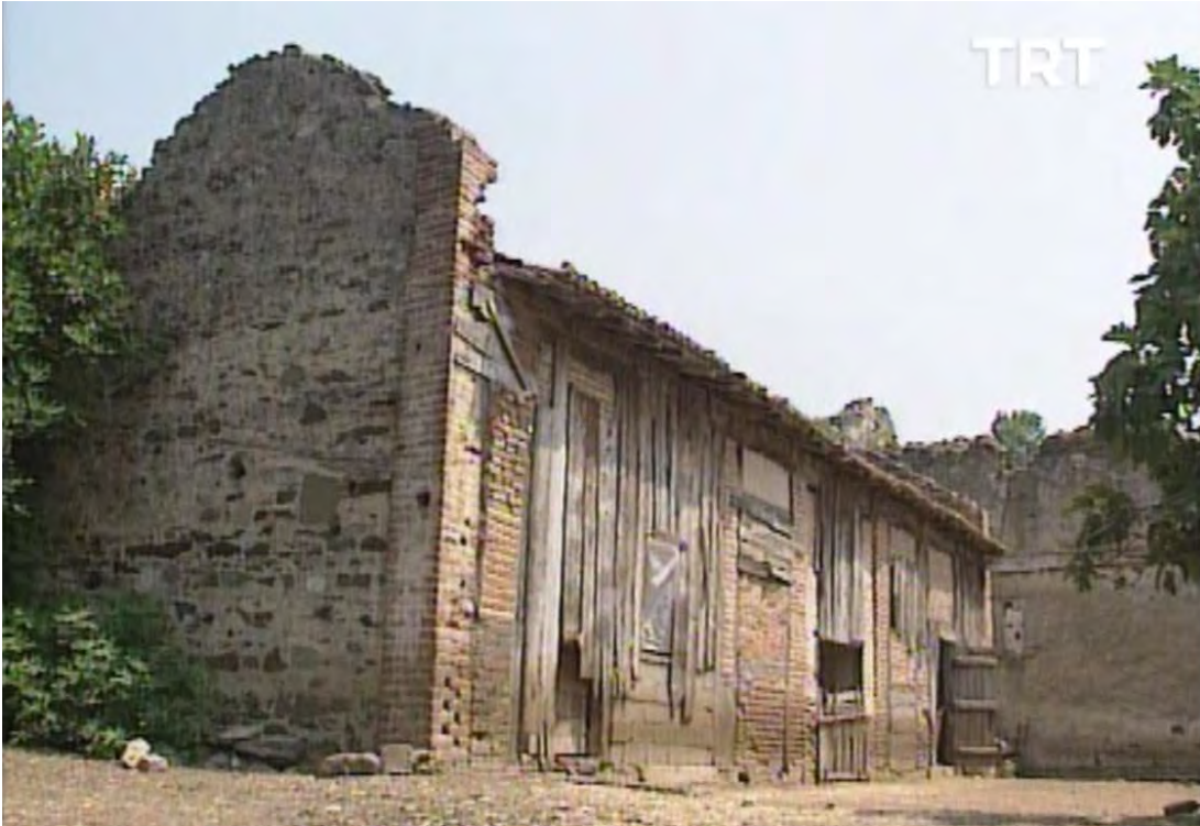
Şekil 5.4: Y04 yapısı 1989 (TRT).
