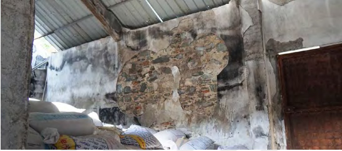
Şekil 4.30: Y04 iç mekânı.
