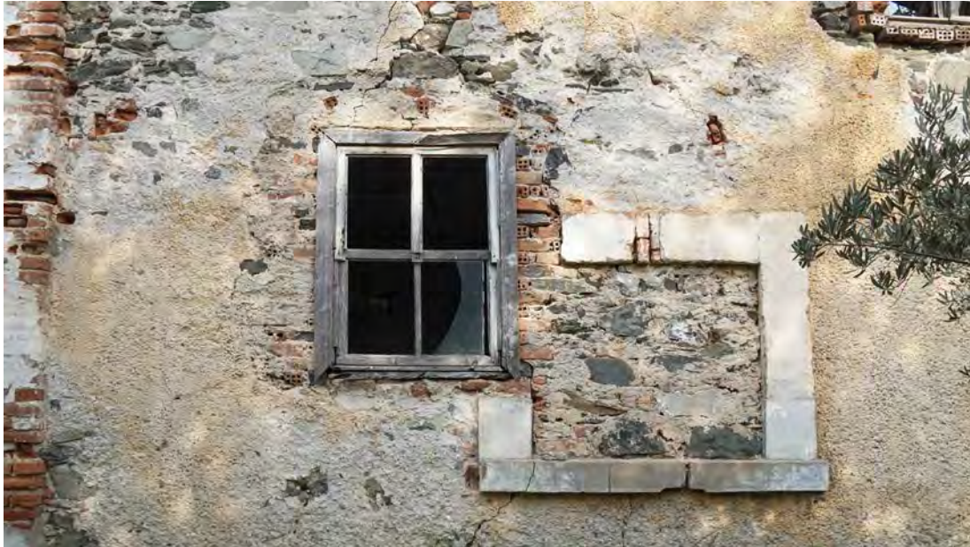
Şekil 4.20: Kapatılan açıklık ve ek pencere (Y02).
