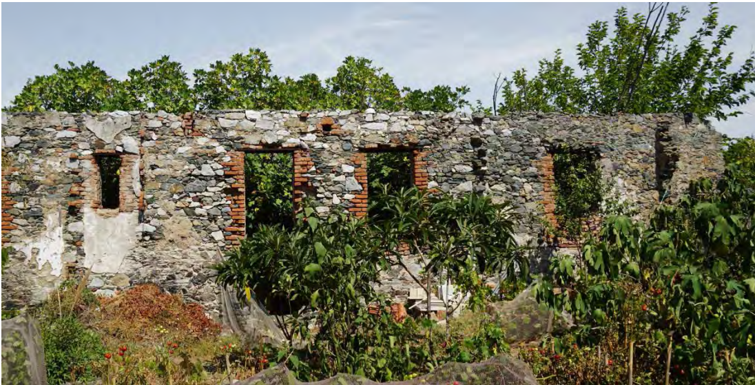
Şekil 4.37: Kuzeydoğu duvarı (Y06).
