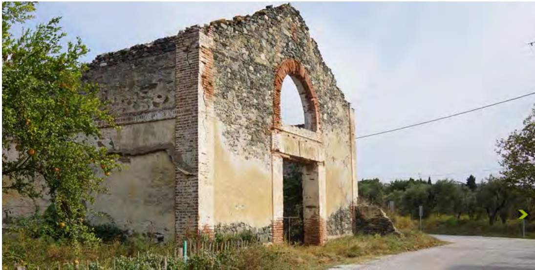
Şekil 4.6: Batı cephesi (Y01).
