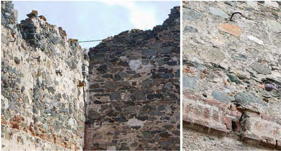
Şekil 4.17: Kuzey duvarının iç ve dış yüzeylerinde bulunan demir kancalar (Y01)
