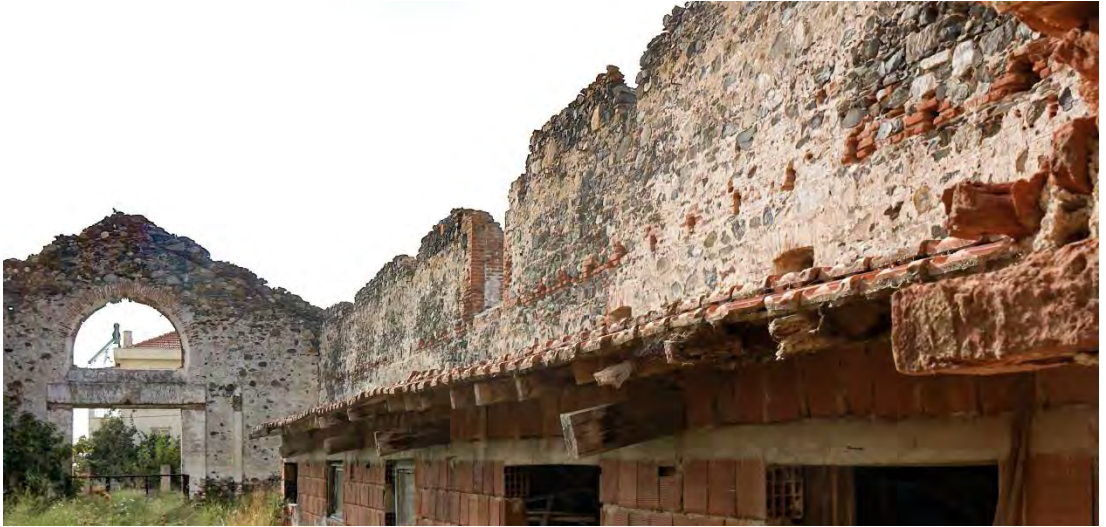
Şekil 5.22: Kuzey duvarındaki kiriş yuvaları.
