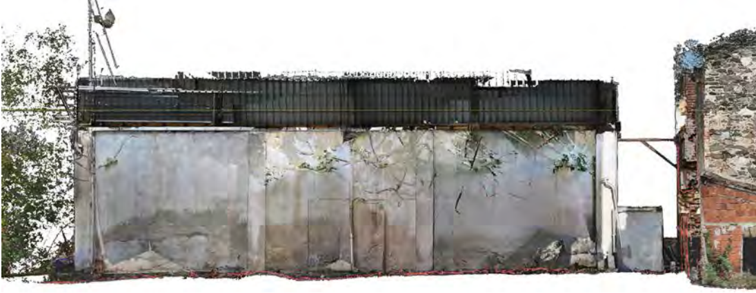
Şekil 4.27: Batı cephesi (Y03) lazer tarama görüntüsü.
