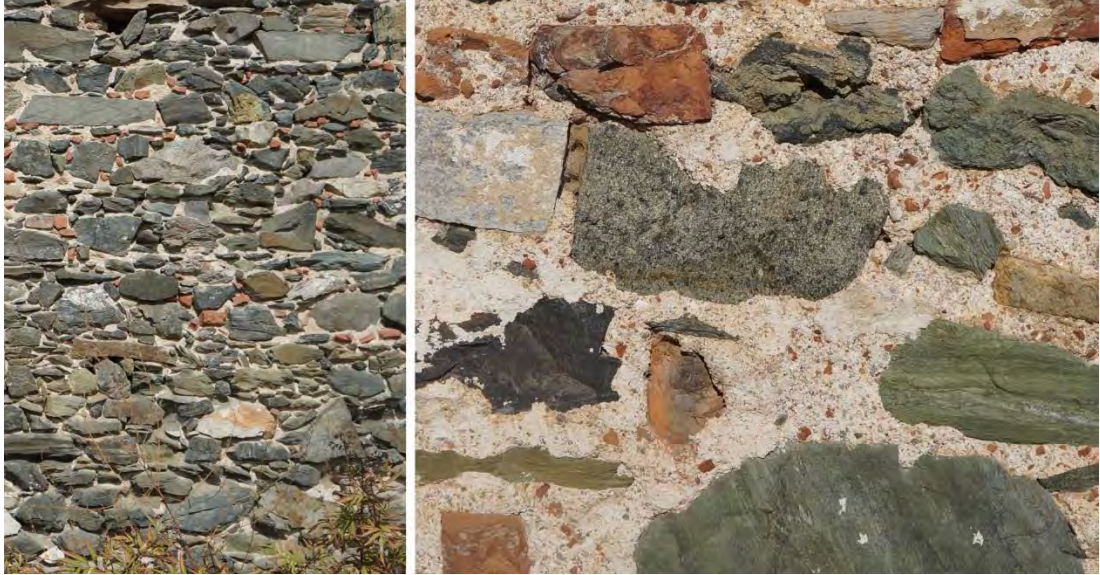
Şekil 4.38: Taş örgü ve horasan harcı.
