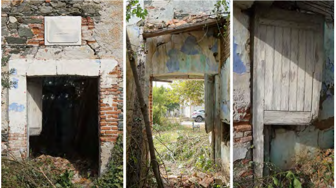
Şekil 4.44: Ahşap kapı (Y02).
