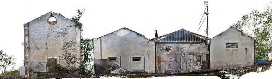
Şekil 4.28: Güney cepheleri (Y02, Y03 ve Y04) lazer tarama görüntüsü.
