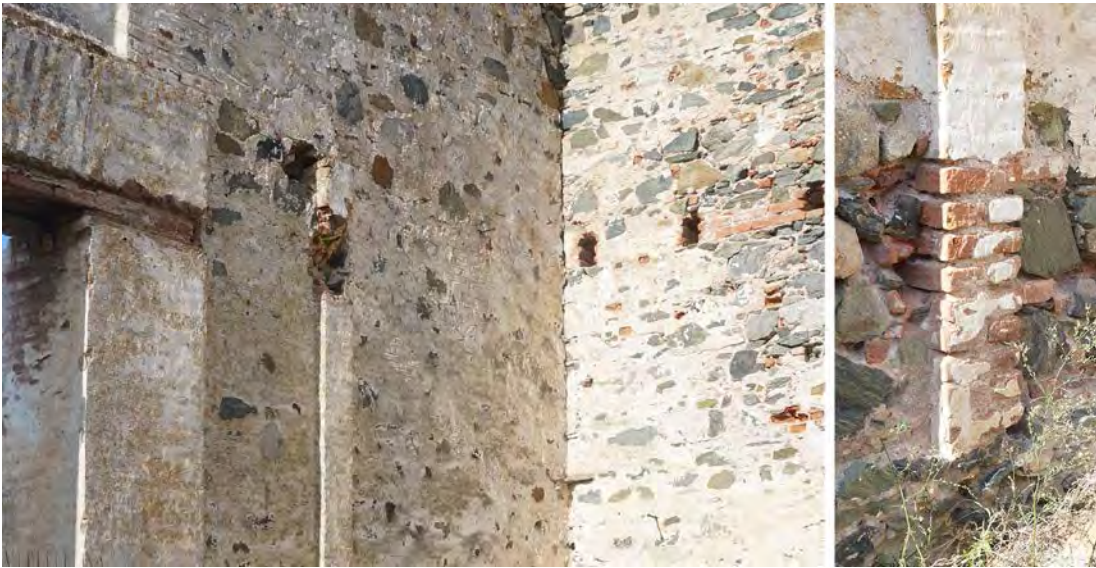
Şekil 4.15: Batı duvarında düşey tuğla detay ve kiriş yuvaları (Y01).
