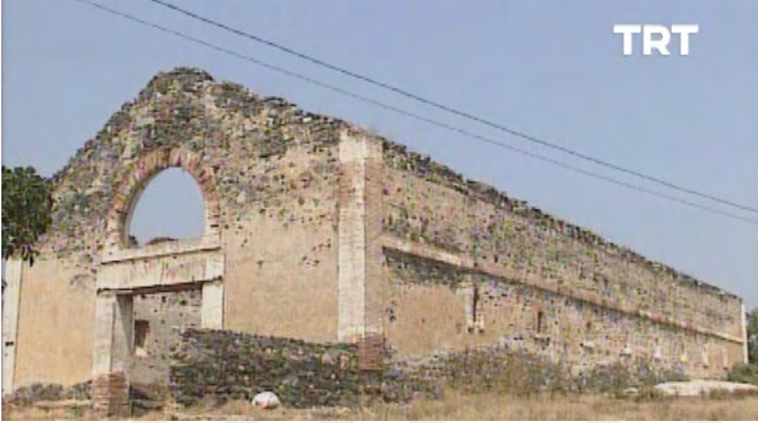
Şekil 5.3: Y01 yapısı 1989 (TRT).
