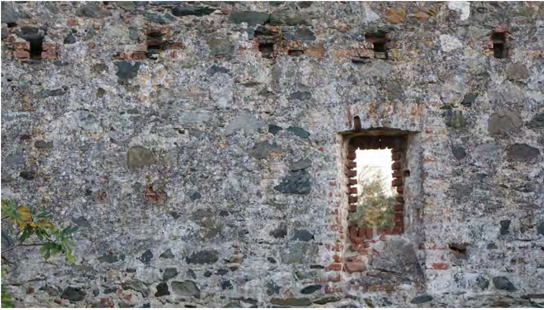
Şekil 4.14: Mazgal pencere ve kiriş yuvaları (Y01).
