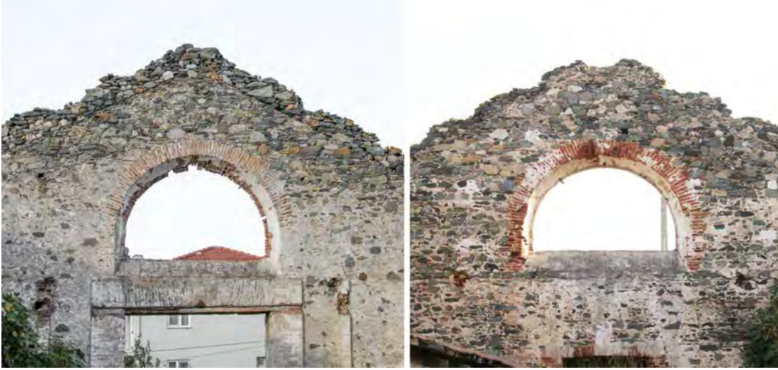
Şekil 5.23: Ara kat döşemesine ilişkin giriş izleri.
