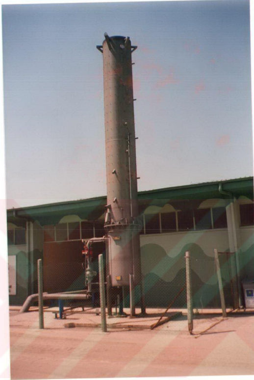
Şekil A.9 Demirtaş Açık Depo Sahası Yakma Bacasının Genel Görünümü
