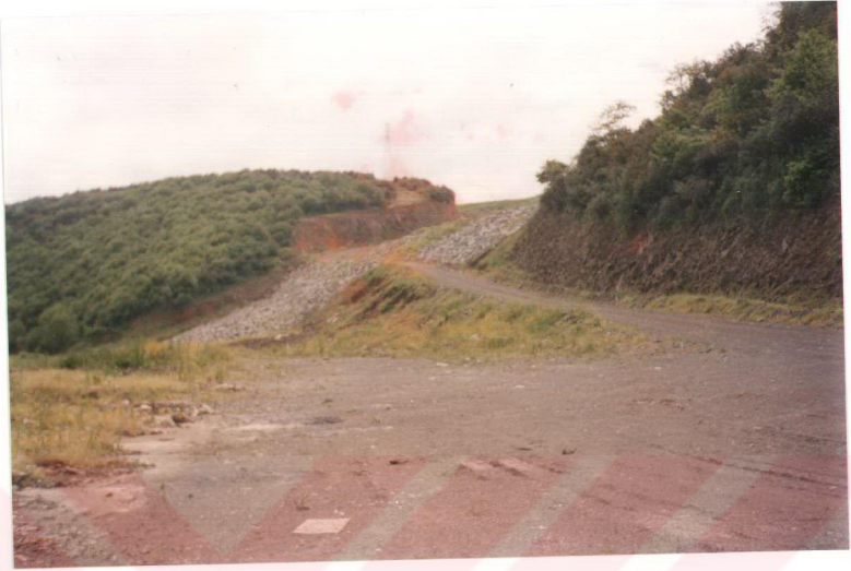
Şekil B.9 Kemberburgaz Açık Depo Sahası Seddenin Görünümü
