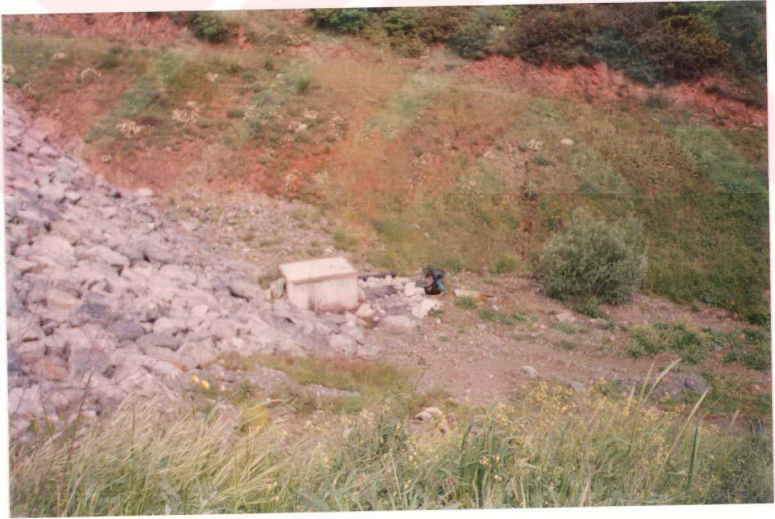
Şekil B.10 Kemberburgaz Açık Depo Sahası Sızıntı Suyunun Toplandığı Noktanın Görünümü
