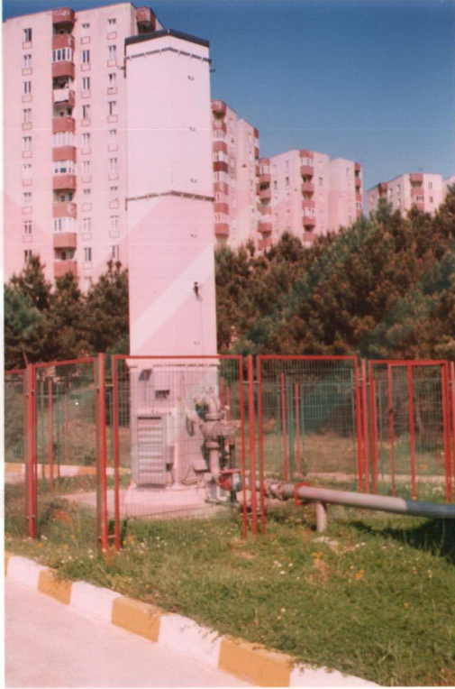
Şekil D.7 Yakacık Açık Depo Sahası Yakma Bacasının Görünümü
