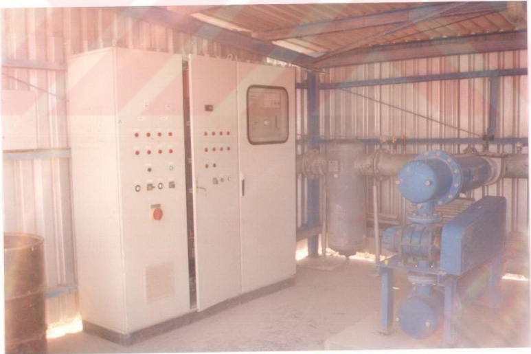
Şekil C.6 Harmandalı Düzenli Depolama Alanı Kontrol Panosunun Görünümü
