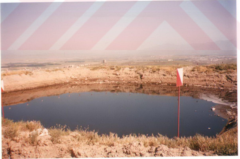
Şekil C.8 Harmandalı Düzenli Depolama Alanı Sızıntı Suyu Toplama Lagününün Görünümü
