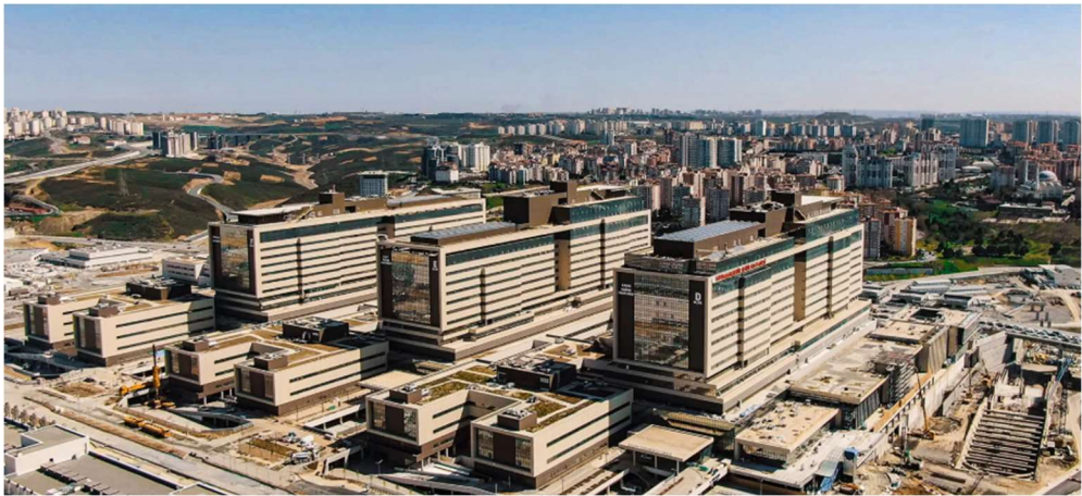
Şekil 2.15: Başakşehir Çam ve Sakura Şehir Hastanesi [27].
