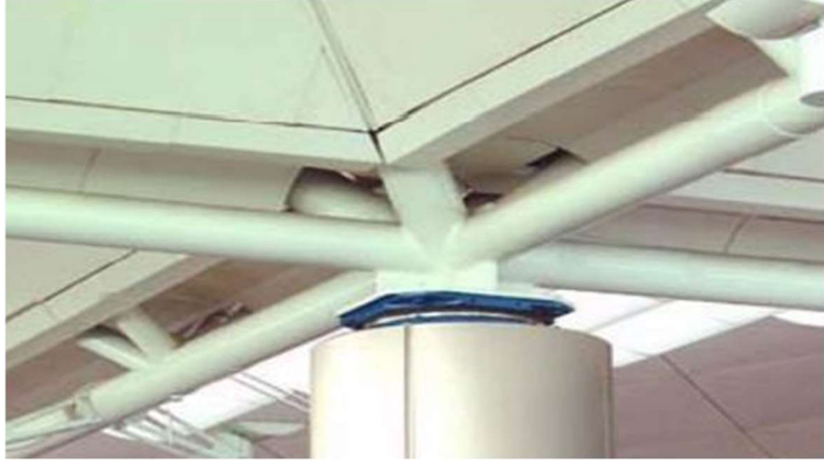
Şekil 2.14: Atatürk Havalimanı çatısında kullanılan izolatör sistemi [25].
