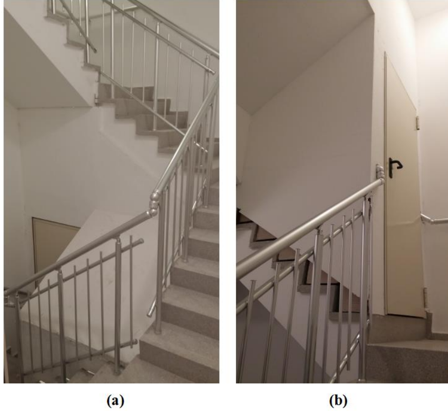
Şekil 4.3 : Merdiveni üst ve orta zona ayıran duvarlar ve zonlar arasında geçişi sağlayan kapı: (a) üst zondan görünüm. (b) orta zondan görünüm.
