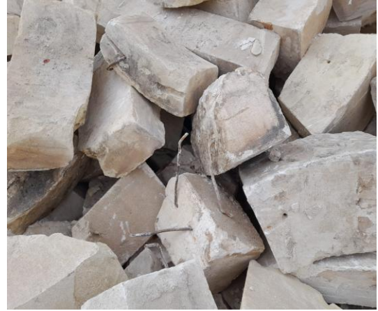
Şekil 1.2 : 6 Şubat 2023 depremleri sonrasında Adıyaman – Tut Camisinde gözlemlenen kenetli bağlantı detayları. Restore edilmiş olmasına rağmen yapı yıkılmış ve bazı taşıyıcı bağlantılar yüzeye çıkmıştır (Ahmet BAL arşivinden).
