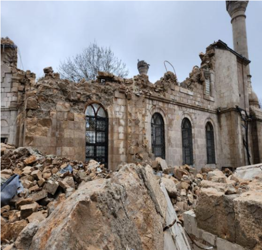
Şekil 1.1 : 6 Şubat 2023 depremleri sonrasında yıkıma uğrayan Malatya Merkez Yeni Cami de yüzeye çıkan kenetler (Ahmet BAL arşivinden).
