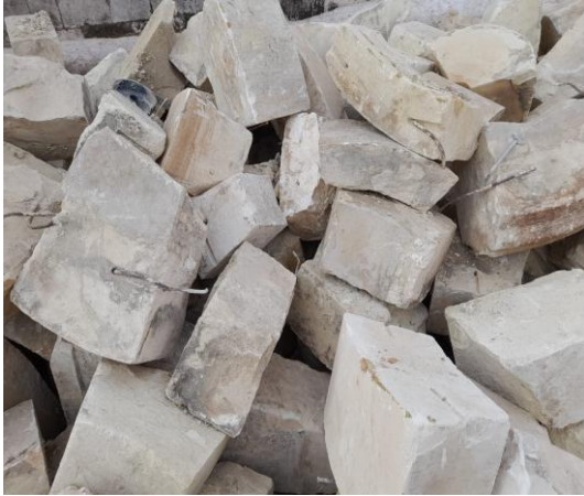
Şekil 1.2 : 6 Şubat 2023 depremleri sonrasında Adıyaman – Tut Camisinde gözlemlenen kenetli bağlantı detayları. Restore edilmiş olmasına rağmen yapı yıkılmış ve bazı taşıyıcı bağlantılar yüzeye çıkmıştır (Ahmet BAL arşivinden).
