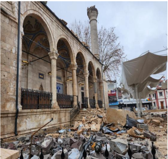
Şekil 1.1 : 6 Şubat 2023 depremleri sonrasında yıkıma uğrayan Malatya Merkez Yeni Cami de yüzeye çıkan kenetler (Ahmet BAL arşivinden).
