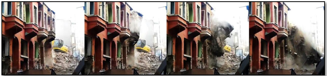
Şekil 4.12 : İkinci görüşme esnasında gerçekleşen yıkım.
