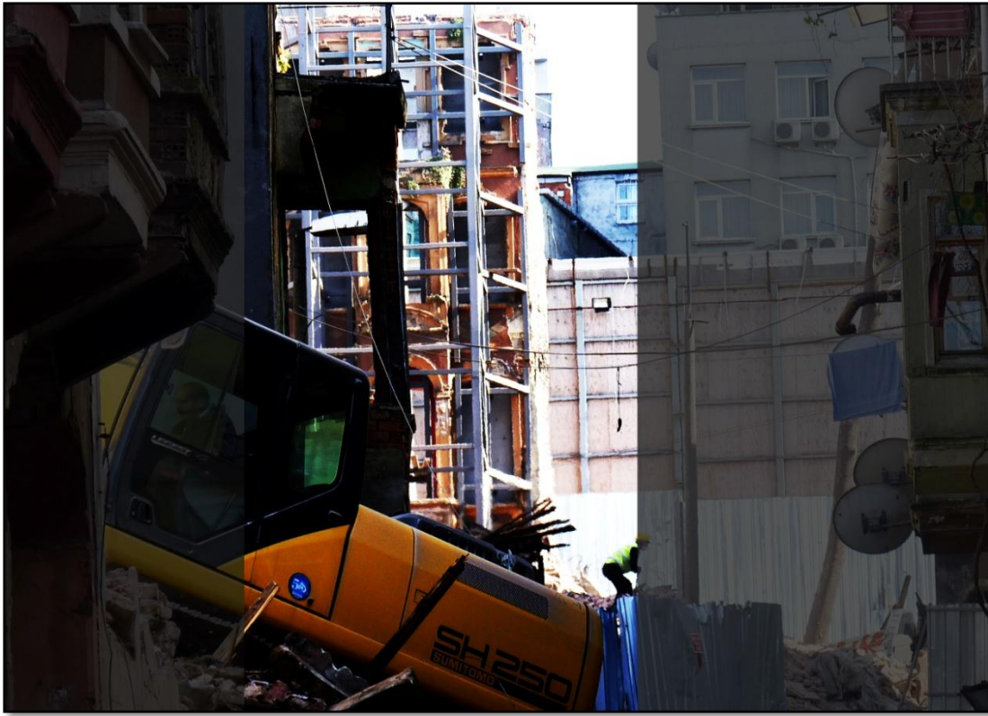
Şekil 4.13 : Tescilli yapının ‘korunması’.
