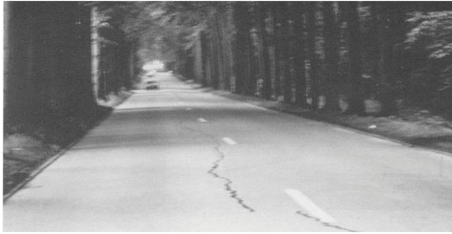
Şekil 4.17: Dreve-de-Lorraine Karayolu, Brussels; 1925 yılında boyuna derz olmadan inşa edilmiş olan derzli rijit üstyapı. [4]
