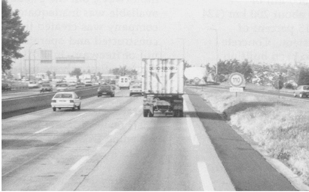
Şekil 4.1: Paris'in güneyinde yer alan, 40 yaşındaki A-6 otoyolunun derzli-donatısız tipteki rijit üstyapı kesimi (Genişletilmiş sınırla eklenen şerit dikkat çekmektedir.) [4]
