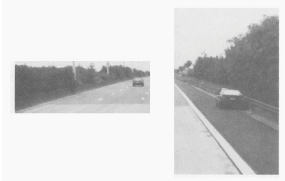
Şekil 4.18: Belçika’da; donatı içeriği % 0.85 olan, asfalt betonu ara tabakalı, zayıf beton temel ve granüler alt temele sahip, 30 yaşını geçmiş olan sürekli-donatılı tipteki rijit üstyapı. [4]
