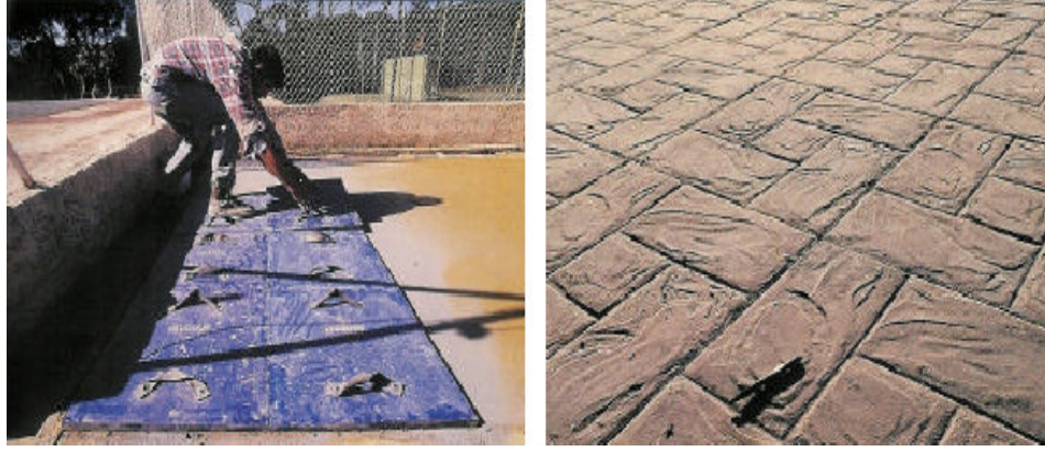
Şekil 7.15: Ön-şekillendirme yöntemiyle elde edilen rijit üstyapı yüzeyi [12]
