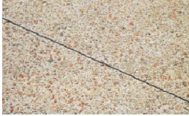
Şekil 7.14: Kimyasal geciktirici kullanılarak elde edilen rijit üstyapı yüzeyi [12]
