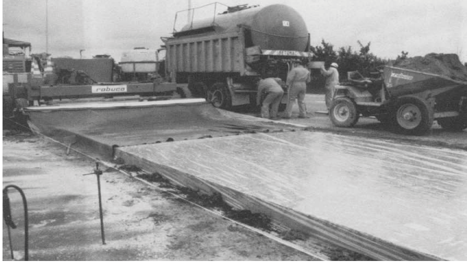
Şekil 4.19: Geciktirici spreylendikten sonra beton yüzeyin üzerine yerleştirilen polietilen örtü (Robuco süreci). [4]
