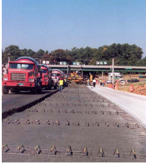
Şekil 7.23: Kayma donatıları kabul edilebilir toleranslarla yerleştirilebilir. Günlük saha ölçümleri kritiktir. [12]
