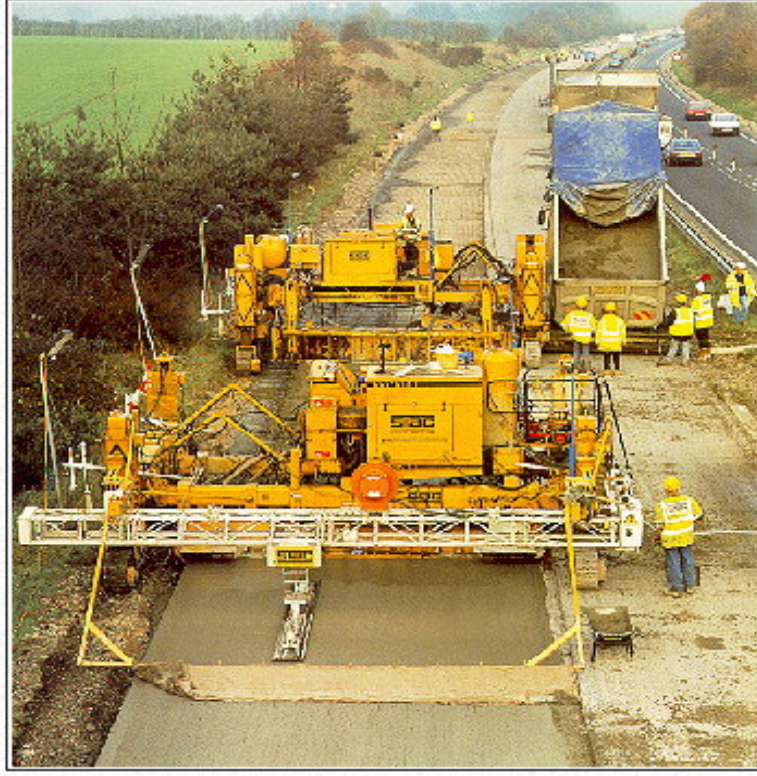
Şekil 2.2: Kayar kalıp sistemi ile rijit üstyapı uygulaması [18]
