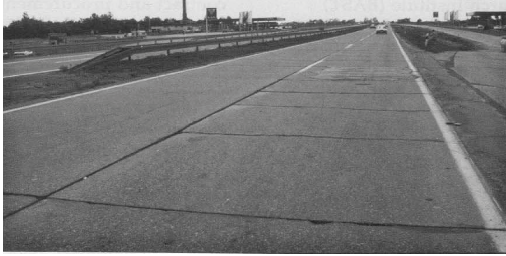
Şekil 4.10: Berlin yakınlarında 1930’lu yıllarda inşa edilen Alman otobanı rijit üstyapısı. [4]
