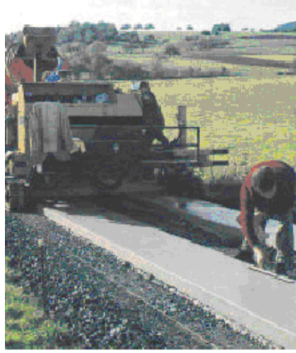
Şekil 7.6: Kırsal yollarda ikili beton şeritlerin inşası [12]
