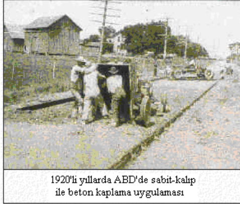
Şekil 2.1: 1920 ile 1930’lu yıllarda rijit üstyapı uygulamaları [18]
