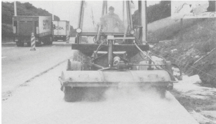
Şekil 4.20: Polietilen örtü kaldırıldıktan sonra yüzeydeki harcı alarak agregalarının ortaya çıkarılmasını sağlayan döner fırça. [4]
