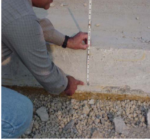
Şekil 7.24: Bağ donatılarının yerleşimi oldukça önemlidir ve günlük ölçüm gerektirir. [12]
