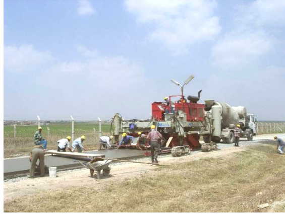
Şekil 4.25: Adana- İncirlik Hava Üssü çevre güvenlik yolu beton dökümü [17]
