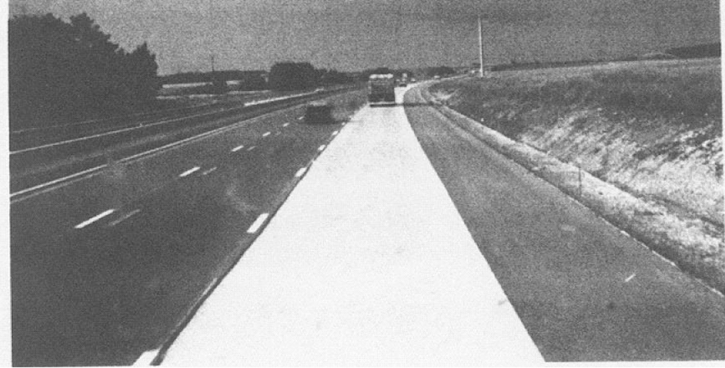
Şekil 4.4: Fransa'da mevcut asfalt üstyapıya eklenmiş, sürekli-donatılı tipteki rijit üstyapı ile inşa edilmiş kamyon şeridi. [4]
