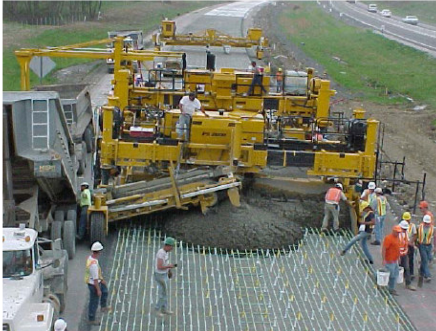
Şekil 7.21: Sürekli donatılı tipteki rijit üstyapılar ağır trafikli karayolları için uygulanabilir bir alternatiftir [12]
