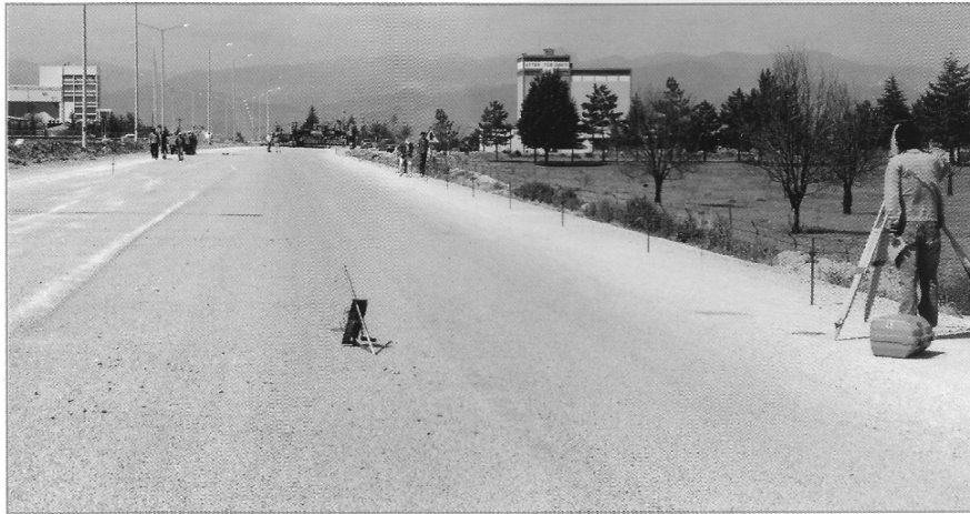
Şekil 4.34: Kılavuz telinin gerilmesi [21]
