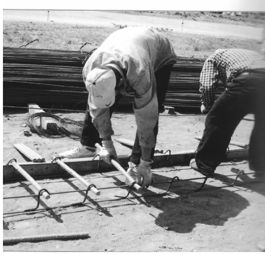
Şekil 4.31: Kayma demirlerinin sehpaye yerleştirilmesi [21]
