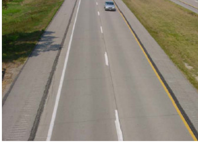
Şekil 7.32: Rijit banketler yapısal desteklik sağlarlar ve acil durum şeridi olarak kullanılabilirler. [12]
