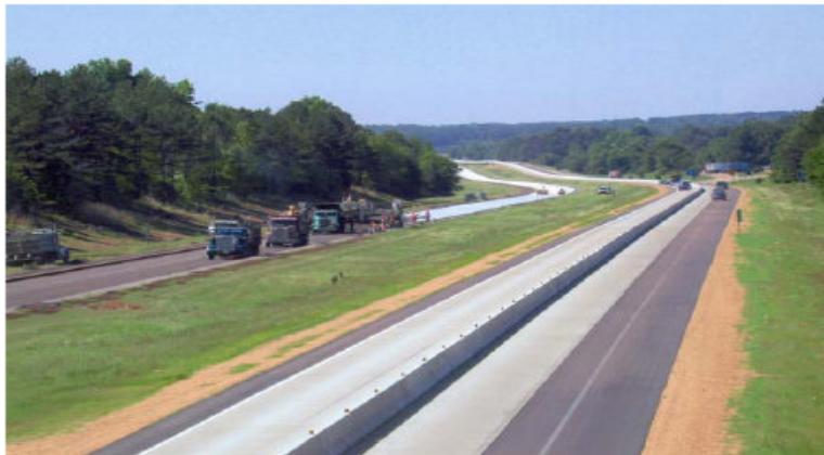
Şekil 7.37: Rijit takviye tabakası mevcut bir üstyapı üzerine yerleştirilirken. [12]
