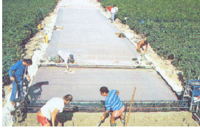
Şekil 7.9: Yerel kırsal yollarda elle yapılan rijit üstyapılar [12]
