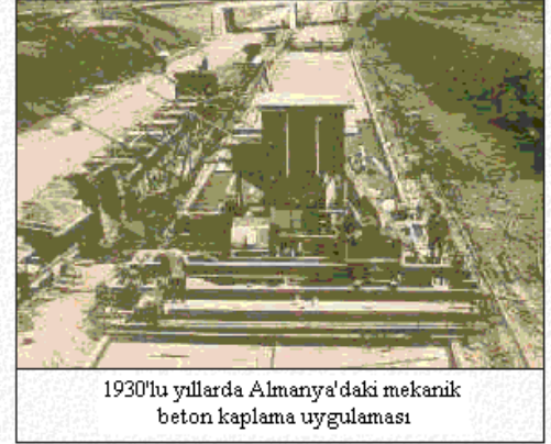
Şekil 2.1: 1920 ile 1930’lu yıllarda rijit üstyapı uygulamaları [18]
