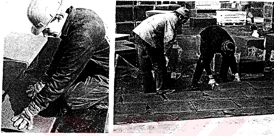
Şekil 3.3 Cam köpüğü levhaların yapıştırılması [38].
