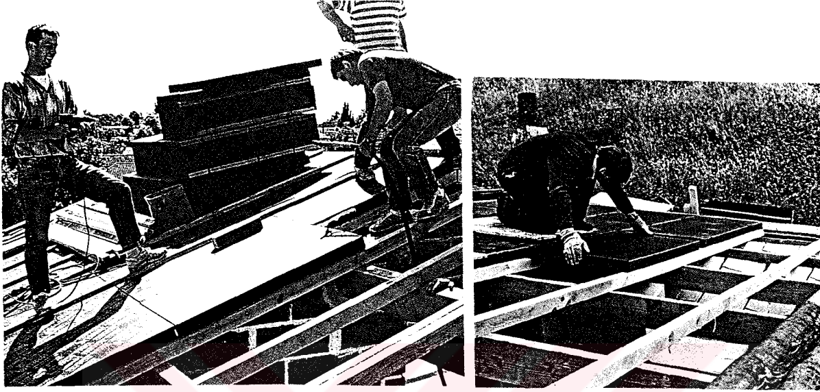
Şekil 3.8 Eğimli çatılarda cam köpüğü uygulanması [38].
