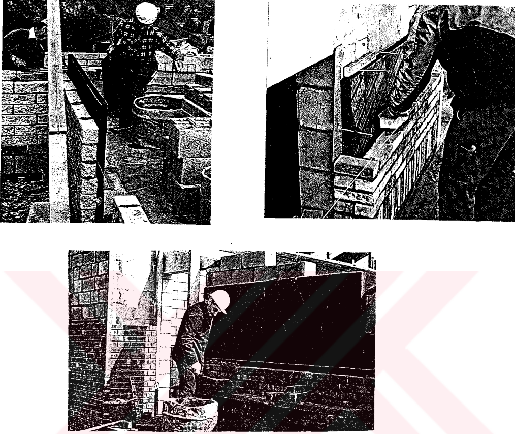
Şekil 3.29 Cam köpüğü levhaların boşluklu duvarlarda uygulanması [35].
