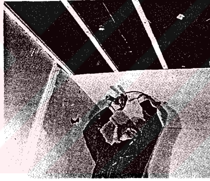
Şekil 3.12 Cam köpüğü levha uygulanmış tavanlarda alçı levha kaplamasının uygulanması [38].
