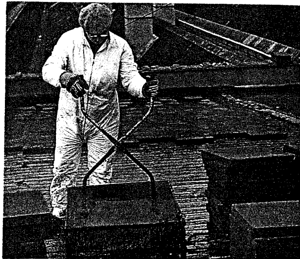
Şekil 3.2 Cam köpüğü levhaların sıcak bitüme batırılması [38].
