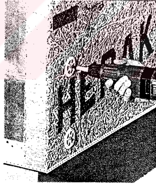
Şekil 3.46 Levhaların dübellenmesi [67].
