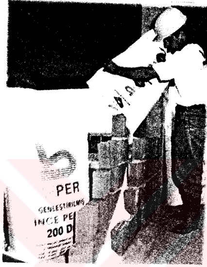
Şekil 3.75 Boşluklu duvarlarda daneli perlit uygulaması [71].
