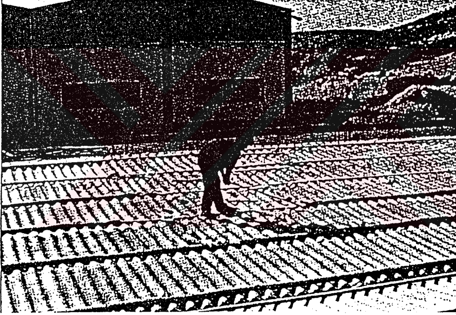
Şekil 3.72 Püskürtme PUR uygulanmış bir çatının korunması amacıyla alüminyum trapez plaka ile kaplanması [72,s 50].
