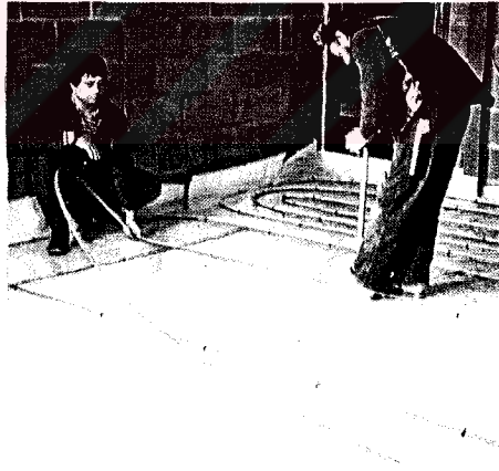
Şekil 3.19 Yerden ısıtma yapılan döşemelerde polistren köpük levha üzerine polietilen folyo serilmesi ve tesisat borularının yerleştirilmesi [42].
