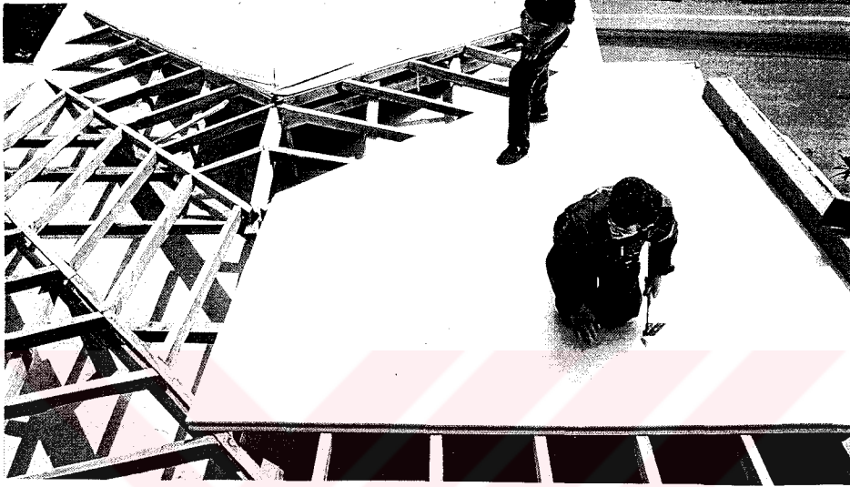
Şekil 3.17 Ekstrude polistren köpük levhaların eğimli çatılarda uygulanması [42].
