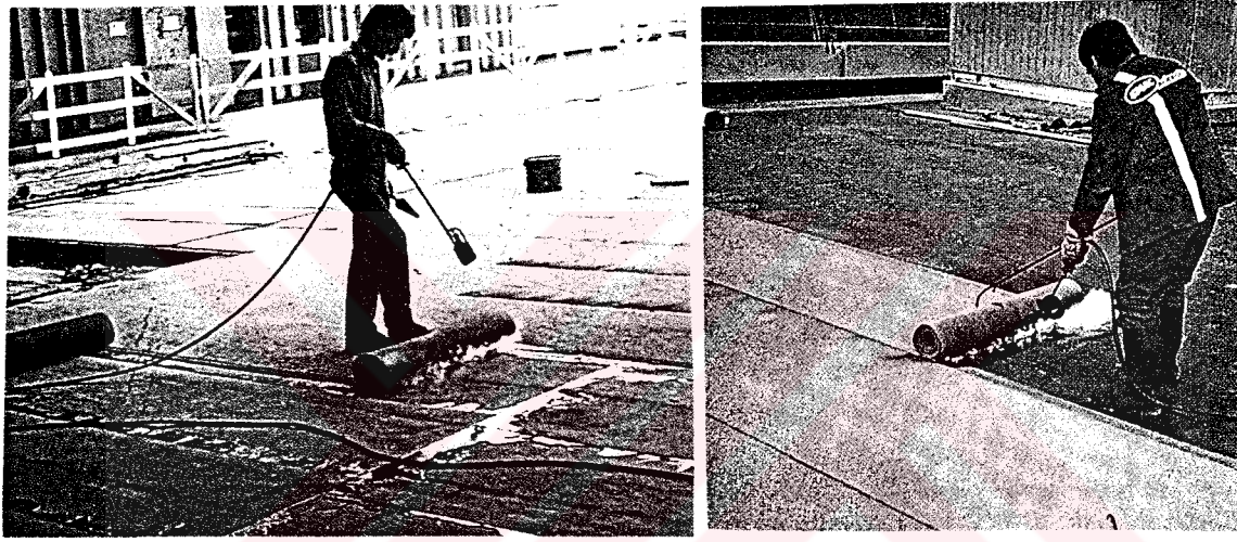
Şekil 3.6 Çatı membranının ikinci katının serilmesi [38].
