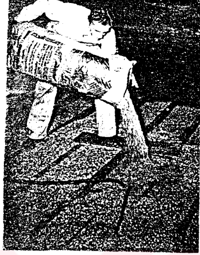
Şekil 3.78 Daneli vermikülitin çatı arası döşemelerde uygulanması [9,s 81].
