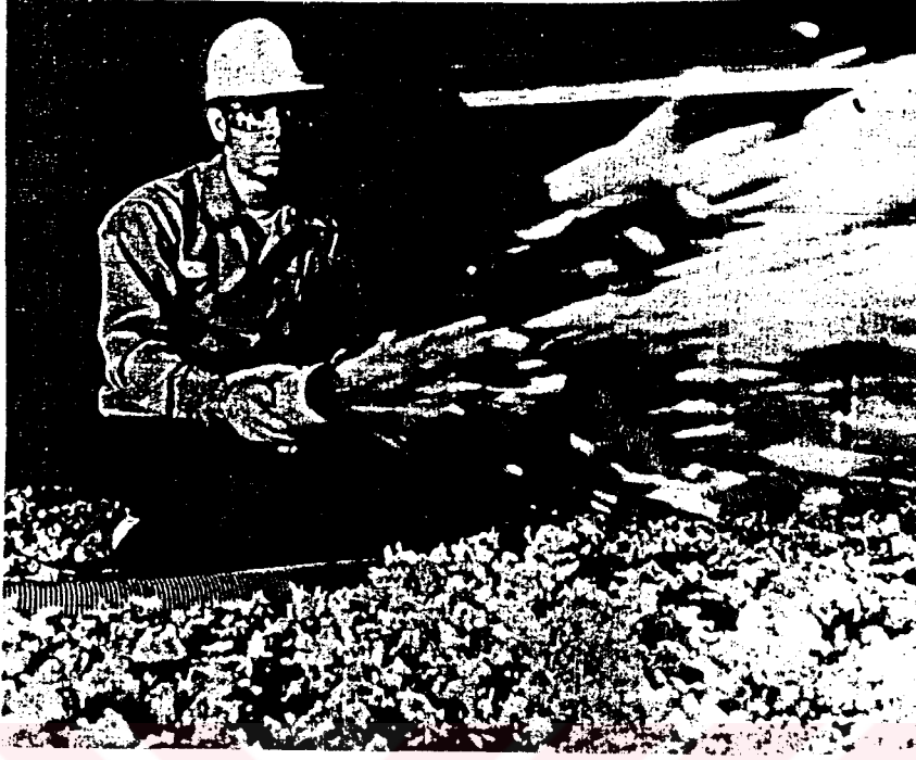
Şekil 3.80 Daneli taşıyının basınçlı hortum ile uygulanması [13,s 483].
