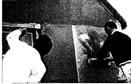
Şekil 3.44 Dıştan uygulamalı polistren köpük levha uygulamasında sıva işlemi [42].
