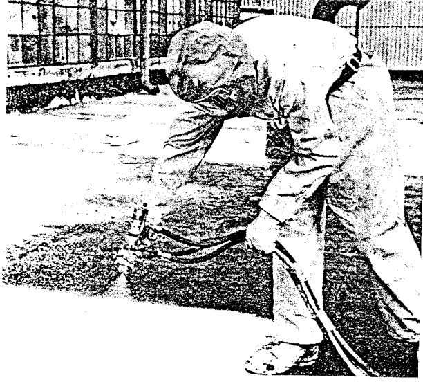
Şekil 3.67 Püskürtme(sprey) yöntemiyle PUR uygulaması [73,s 38].
