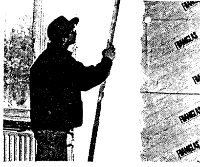
Şekil 3.37 Cam köpüğü levha üzerine fırça ile sıva uygulaması [35].
