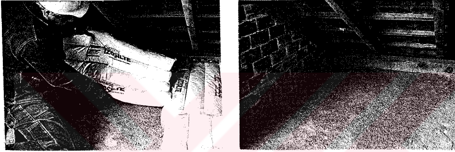
Şekil 3.64 Perlitli şiltelerin kapalı çatılarda uygulanması [71].
