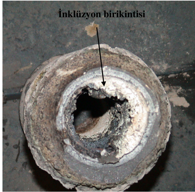
b) Inklüzyon birikmesi sonucu kesit daralması
