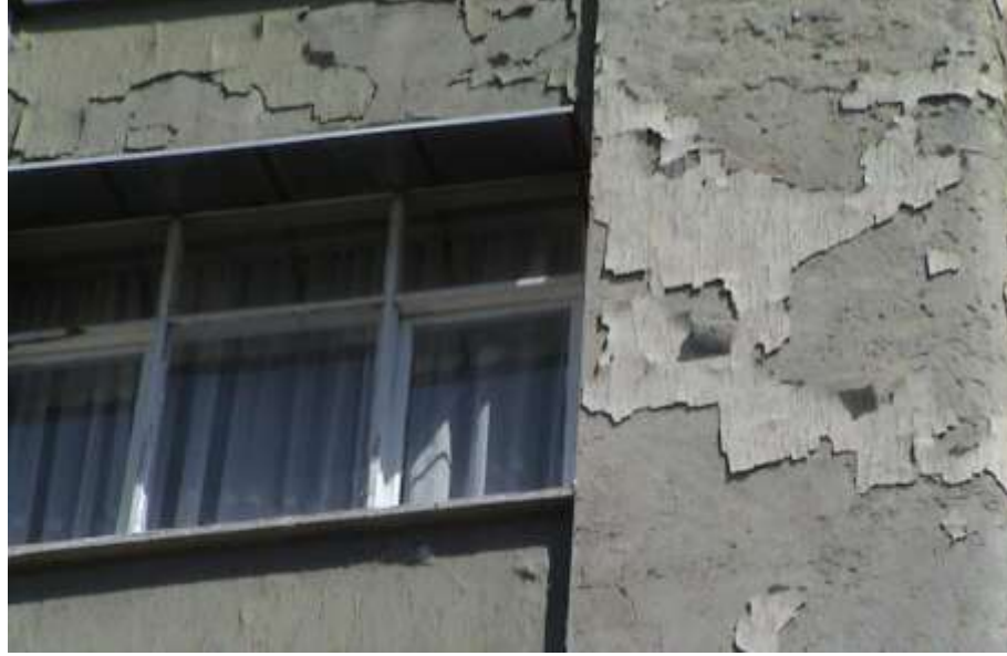
Şekil 4.16 Havanın nemi ve rüzgarla itilen yağmur damlalarının neden olduğu kabarmalar ve dökümler.
