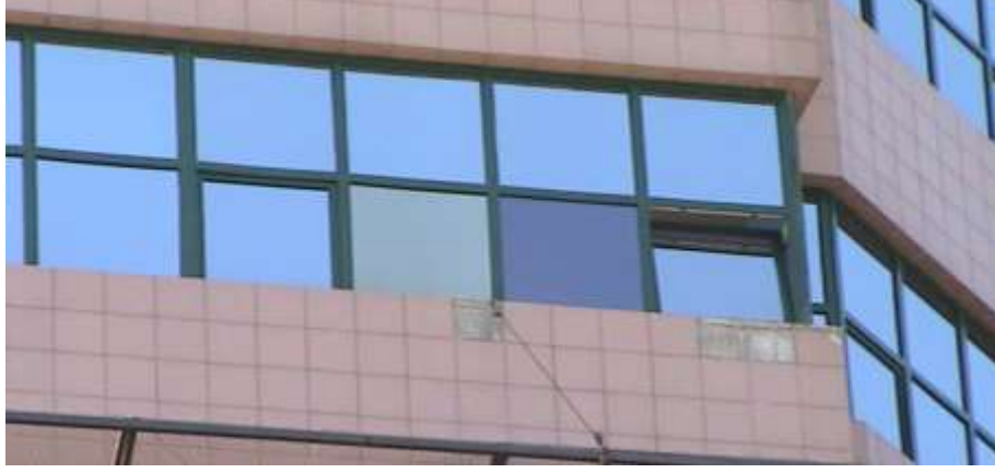
 ekil 4.20 Isıl gerilmeler etkisinde seramik kaplamanın d k lmesi.
