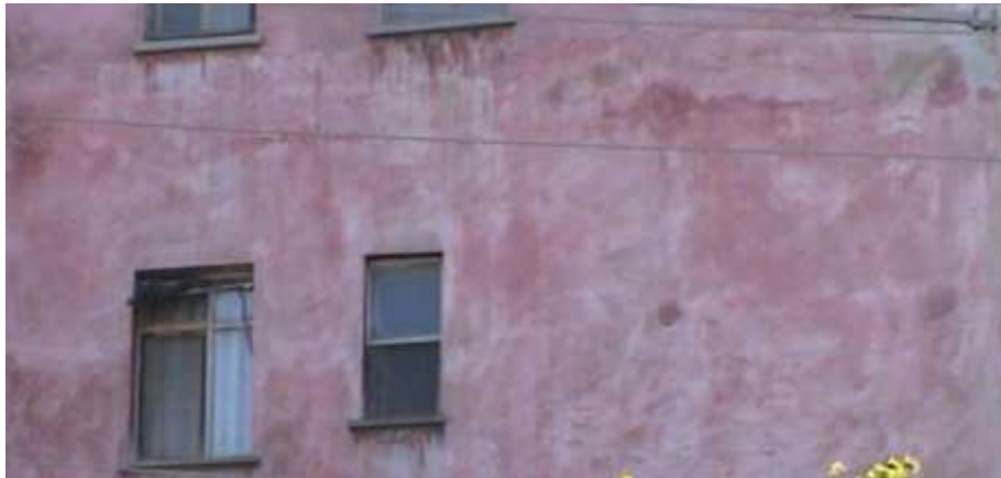
 ekil 4.21 G ne  etkisinde dı  cephe boyasının rengini yitirerek k t  bir g r n m alması.
