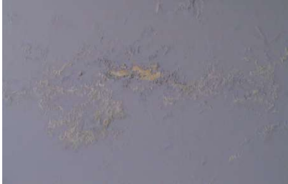
Ş e k i l 4.8 D u v a r k e s i t i n d e o l u ŝ a n g i z l i y o ğ u ŝ m a s u y u, b i t i r m e b i l e ŝ e n i a l t ı n d a ç i ç e k l e n m e y e n e d e n o l m u ŝ t u r.
