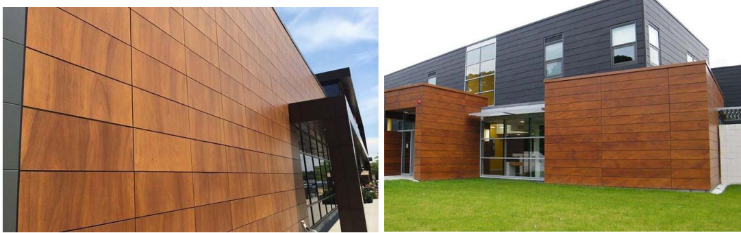
Şekil 4.7 : Ahşap kompozitin cephede kullanımı (YCD Yapı).
