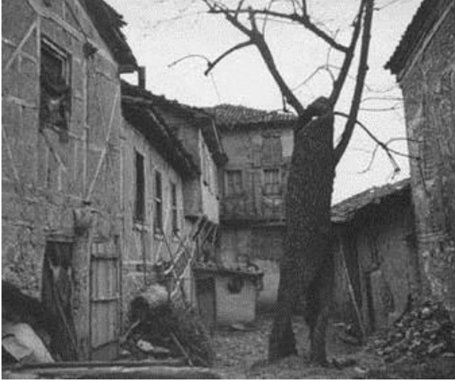
Şekil B18. Çıkamaz sokak ve ahşap karkas yapılar
