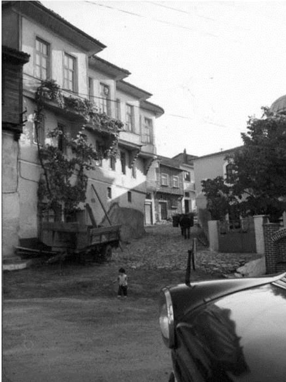
Şekil B15. Cami arkası sokakta çıkmalı ahşap yapı ve sokak dokusu
