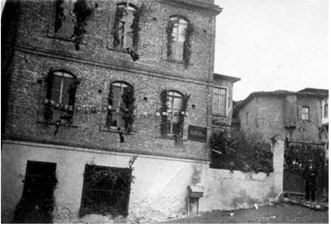
Şekil B28. Eski Rüştîye binası
