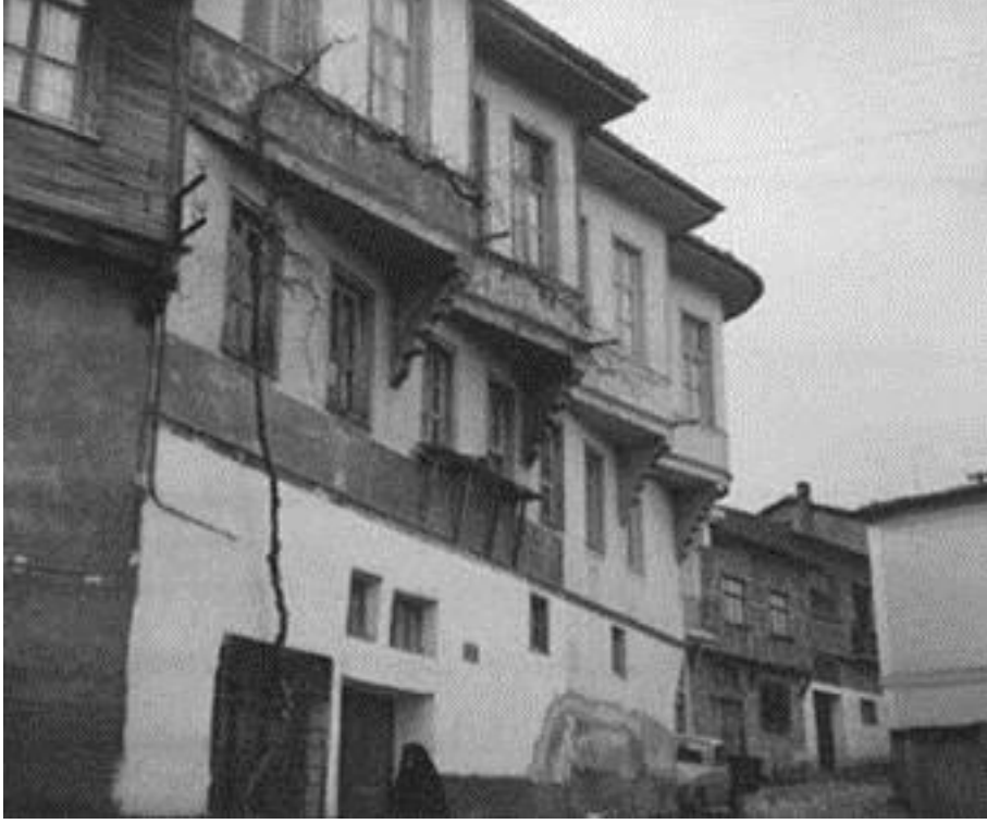
Şekil B14. Cami arkası sokakta çıkmalı ahşap yapı
