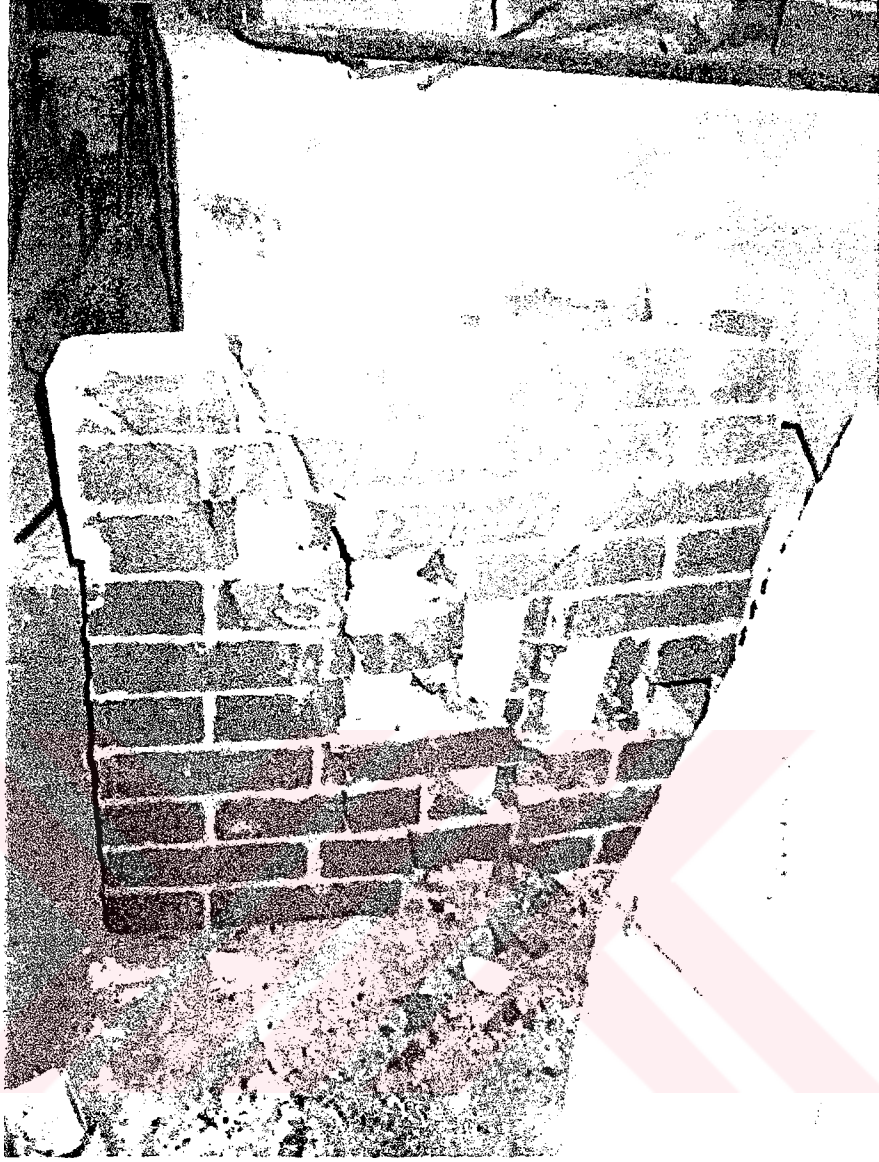
Şekil B.11 Altı donatılı bir numunede yüzeydeki tuğlaların dökülmesi
