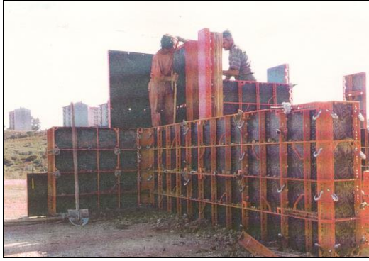
řekil 2.27 Endüstriyel kalıpların hazırlanması [3]
