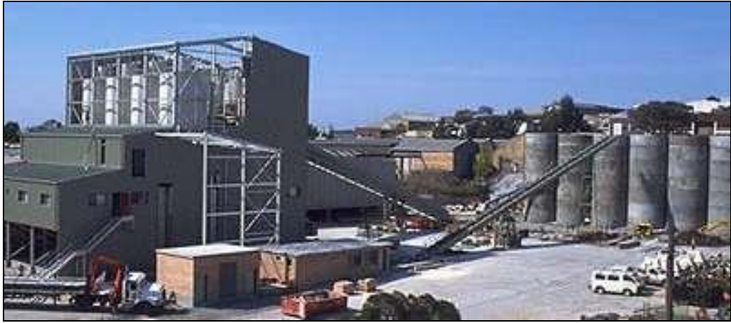
Şekil 3.18 Yaş karışım püskürtme beton hazırlama santrali [49]
