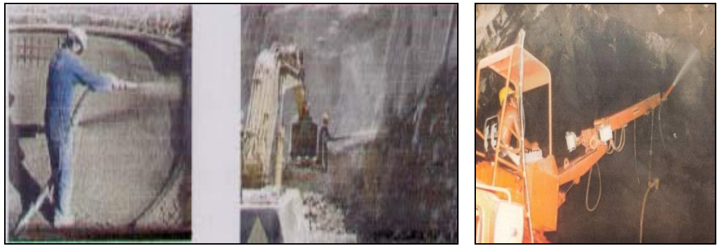
Şekil 3.20 Püskürtme başlığı uygulama pozisyonları [38, 40]
