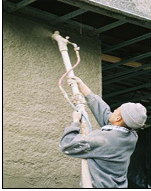
Şekil 3.8 Konut binası duvar ve tavan püskürtmesi [45] Şekil 3.9 Konut binası, Medford [45]
