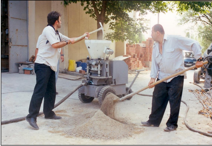
Şekil 4.4 Alçı katkılı toprağın karılarak kompresöre aktarılması
