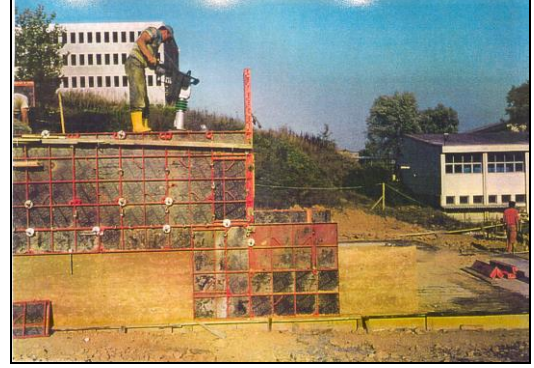
řekil 2.28 Vibrasyonlu kompaktör ile sıkıştırma işlemi [3]
