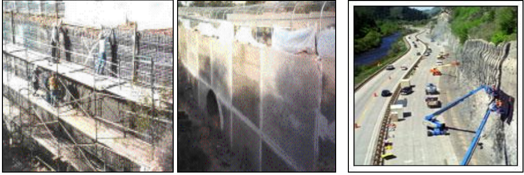
Şekil 3.12 Köprü istinat duvarı, Azerbaycan [41] ve otoyol şev duvarı [46]
