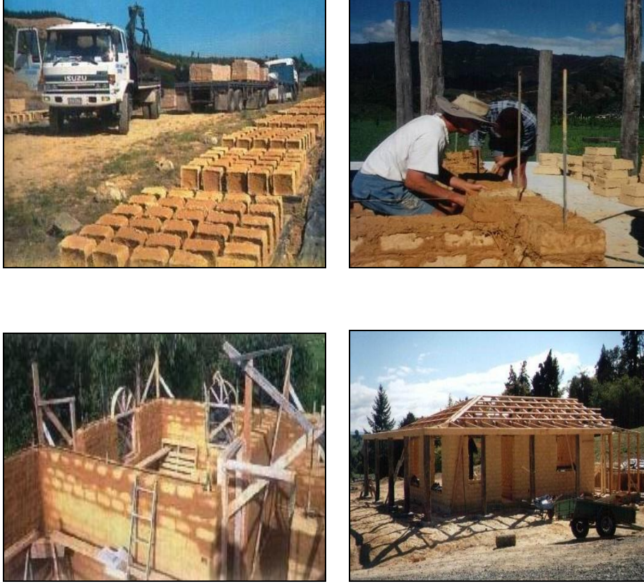
Şekil 2.22 Sahada kerpiç bloklar ile bina yapımı, Yeni Zelanda [11]
