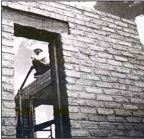
Şekil 2.20 Tüm duvarın blok kerpiç ile örülmesi [25]
