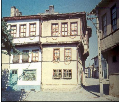
Şekil 2.13 Kerpiç bina, Tavşanlı, Kütahya [19]
