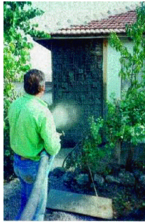
Şekil 3.4 Kagir yapının güçlendirilmesi, Kazakistan [45]
