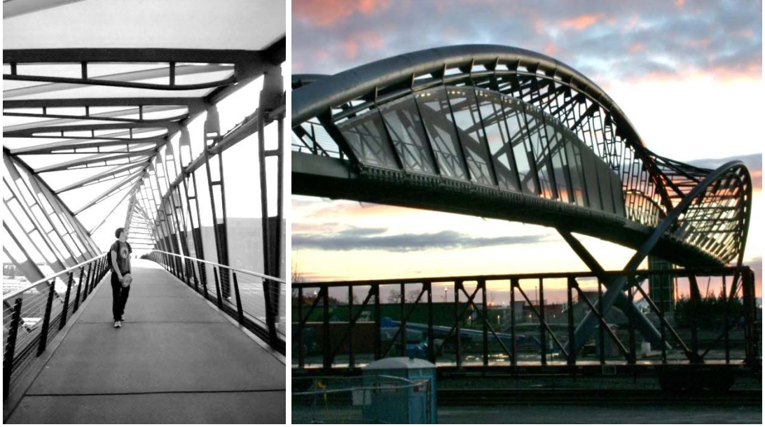
Şekil 3.3 : Helis taşıyıcı sistemlerin kullanıldığı Seattle kentindeki bir köprü.
