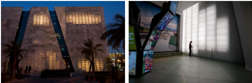
Şekil 2.22 : İtalyan Pavyonu dış ve iç görünüşü [28].
