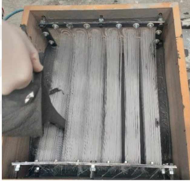
Şekil 3.22 : Beton döküm işlemi (AR1 numune grubu).
