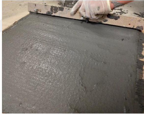
Şekil 3.25 : Beton yüzeyinin düzeltilmesi - mastarlama.
