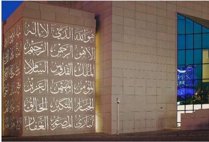
Şekil 2.24 : Al Aziz Cami, panel görünüşü [2].
