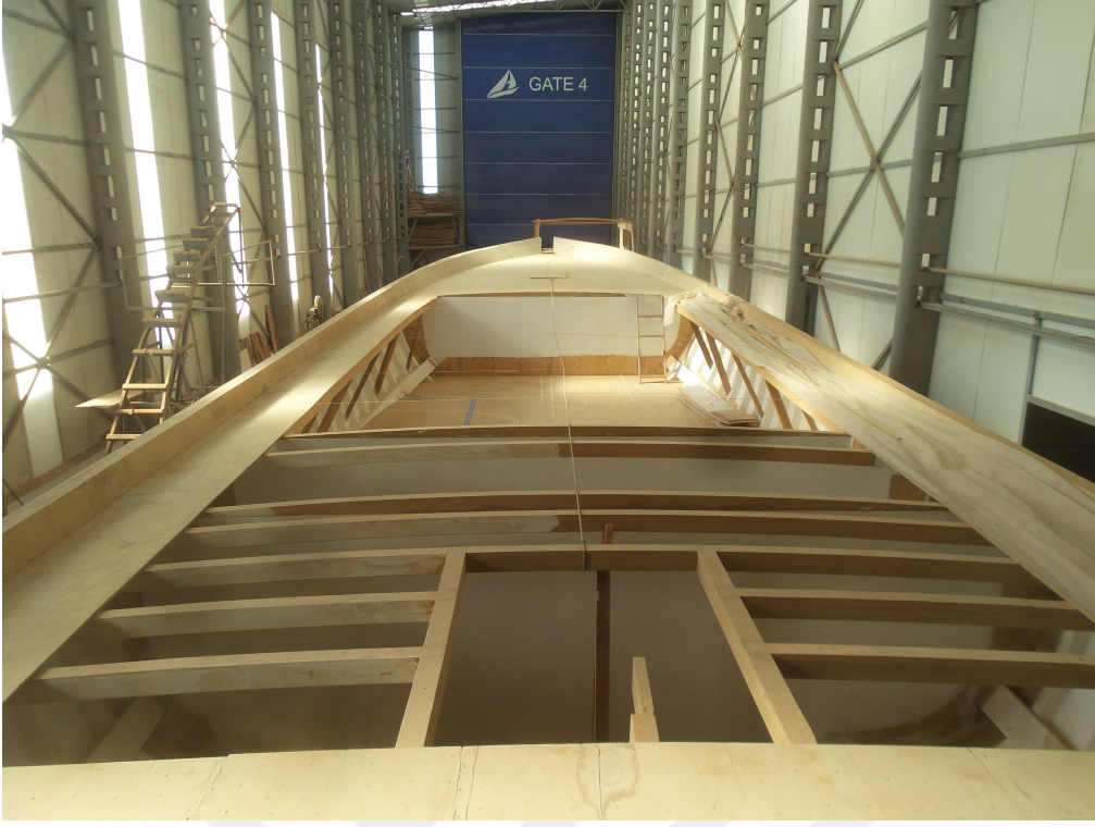
Şekil 4.15 : İnşa aşamasında 24 metrelik, tip onay belgeli, klaşlı, klasik gulet.
