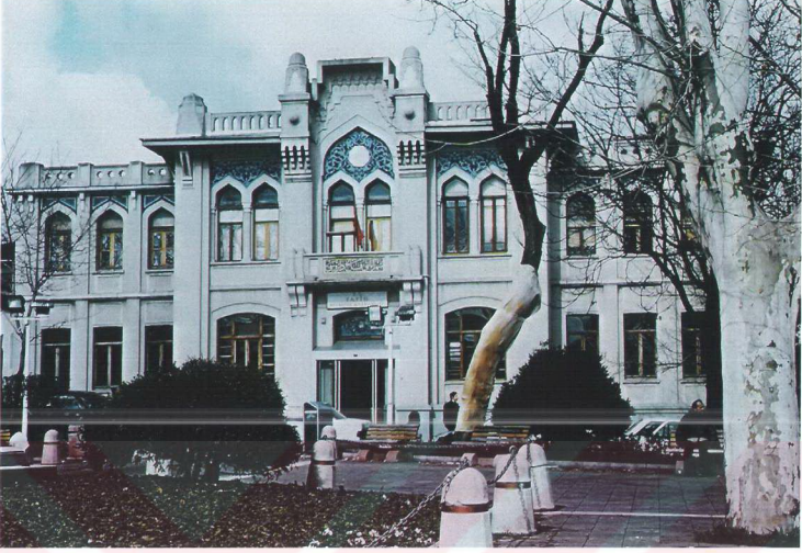
Şekil 5.7. Fatih Kaymakamlığı (Günümüzde Fatih Belediyesi Binası). (Tetik 2004).
