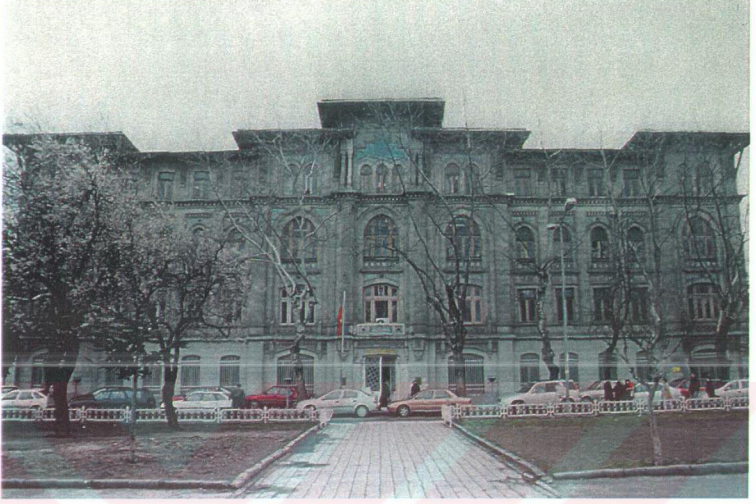
Şekil 5.5. Defter-i Hakani (Tapu Kadastro Binası). (Tetik 2004).
