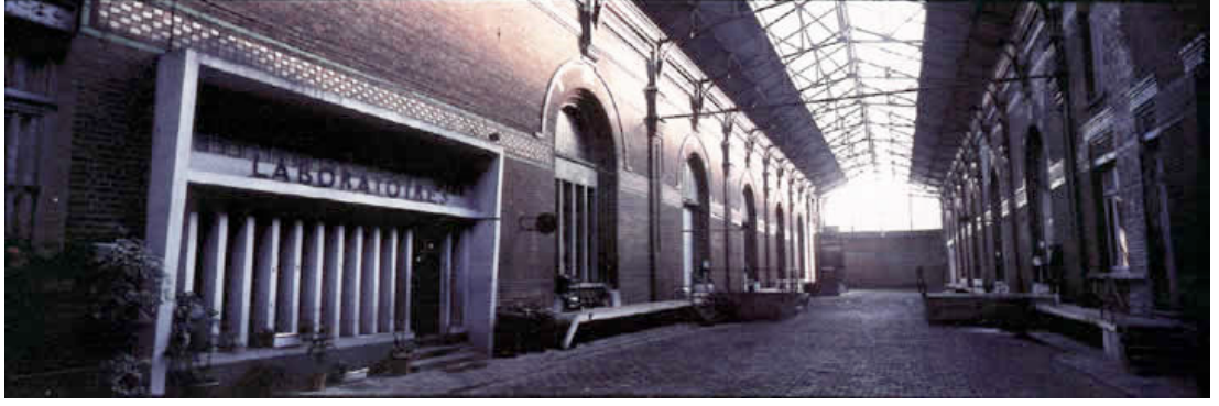
Şekil 4.21: La Condition Publique – Roubaix Çılgınlık Evi
