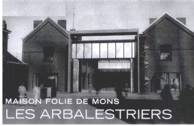
Şekil 4.25: Les Arbalestriers - Mons Çılgınlık Evi
