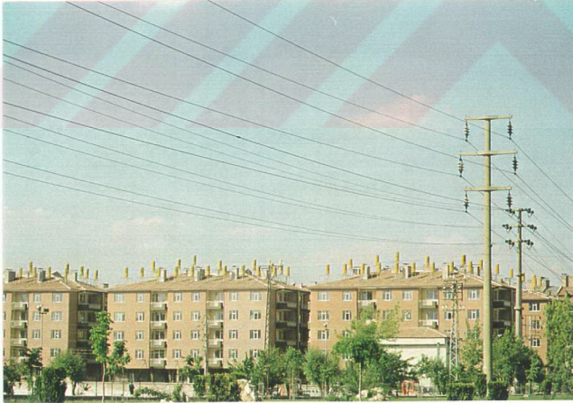
Şekil 5.33: Çatılarda çok fazla sayıda güneş enerjisi sistemi olması, strüktürleri sebebi ile çatıların örtüsünde bir takım problemler oluşturabilirler.
