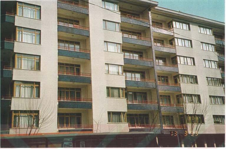
Şekil 5.23: Son dönemlerde dış cepheleri akrilik esaslı boya ve cam karo mozaik ile kaplanmış bir kaliteli kooperatif yapısına ait cephe görülmektedir.
