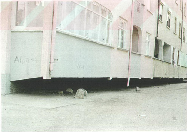
Şekil 5.9: Yanlış tasarım olarak, süreklilik arz eden zemin kat balkonları altında anlamsız boşluklar ortaya çıkmaktadır.
