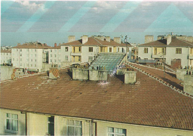
Şekil 5.38: Kalitesiz malzeme ve işçilikle birlikte yanlış yapım tekniği ile bacaların sıvasının dökülmesine sebep olmaktadır.
