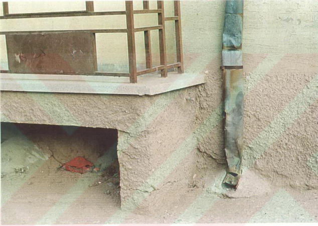
Şekil 5.12: Kullanım sürecinde insanların bilerek hasara sebep oldukları bir yapı elemanı, ezilmiş yağmur borusu.
