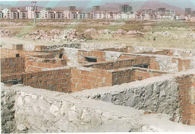
Şekil 5.19: Maliyeti düşük yığma taşıyıcı sistemli kooperatif yapılarında dış duvarlar doğal taş, iç duvarlar ise taşıyıcı tuğla ile inşa edilmişlerdir.
