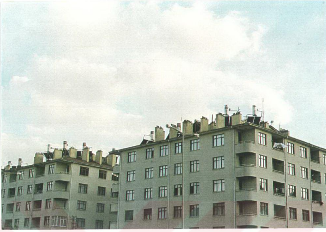
Şekil 5.32: Bir çatıda çok fazla sayıda baca gövdesi ve güneş enerjisi sistemi olması, o çatının örtüsünde bir çok probleme sebep olabilir.
