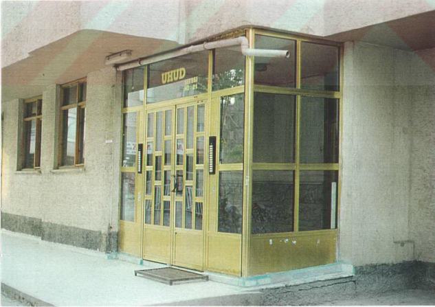
Şekil 5.40: Yanlış tasarım sonucu giriş kapısının konsol hizasına alınması, girişin saçaksız kalmasına, ve zeminde çökmelere sebep olmaktadır. Daha sonra oluşan gelişmeler için Şekil 5.37 ve 5.38 bakılabilir.
