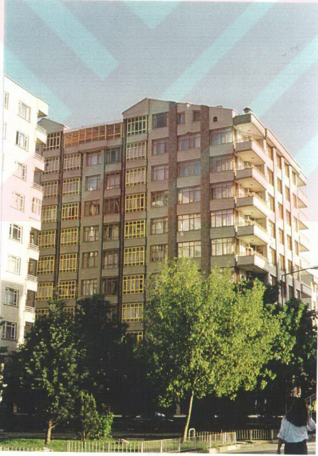
Şekil 5.43: Kaliteli malzeme ve işçilik ile ısı yalıtımının iyi ve doğru yapıldığı lüks kooperatif yapısında geniş pencereler; ayrıca, başlangıçta doğru bir tasarım kararı ile gerekli balkonlar tamamen kapatılmış durumda.
