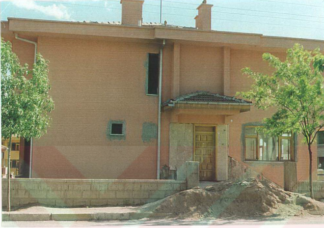
Şekil 5.44: Kullanıcı konutu isteğine göre kullandığında, yaptığı değişiklikler, pencerelerin değişmesi ile dış cepheye gelişigüzel yansımakta.
