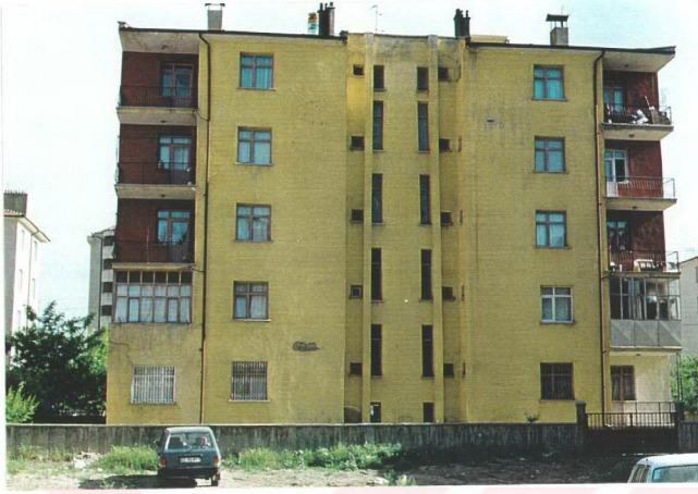
Şekil 5.5: Uzun zaman sonucunda işlevsel ve fiziksel olarak bina bütününe (cephe ve iç kısımları) yansıyan eskime hali görülmektedir.
