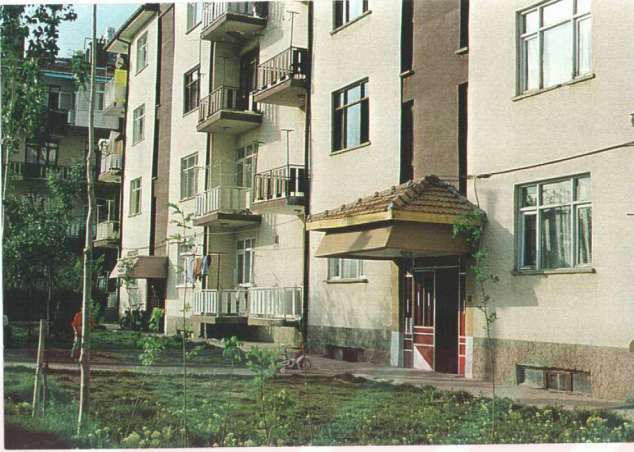
Şekil 5.39: Yanlış tasarım sonucu giriş kapısının dış duvar hizasına getirilmesi, ve yapılan giriş saçığındaki yalıtım probleminin ilginç çözümü.
