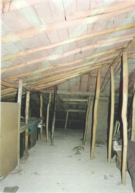
Şekil 5.10: Ekonomik kaygı ile standartlara uymayan çatı malzemesi, ve serbest olarak serilmiş bims kumu yanlıř bir ısı yalıtım detayı olarak yanlıř malzeme seçimi ve uygulamaya örnek olmaktadır.
