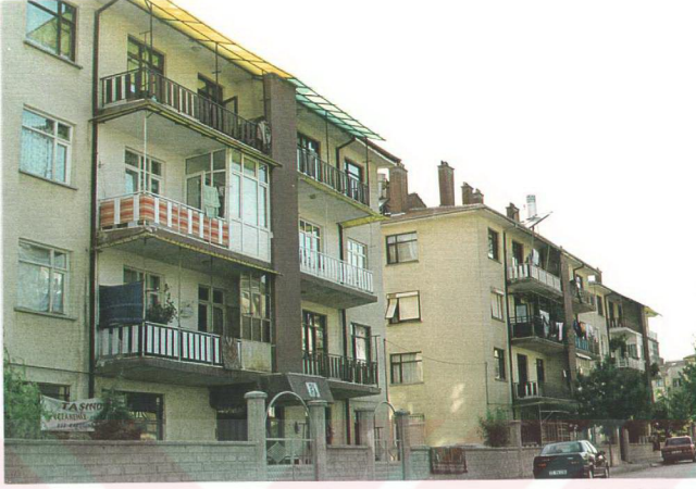
Şekil 5.1: Tasarım hatası sonucu, işlevsel bir kusur olarak saçak genişliğinin balkonları örtmemesi hali ve yapılmış kötü müdahale görülmektedir.
