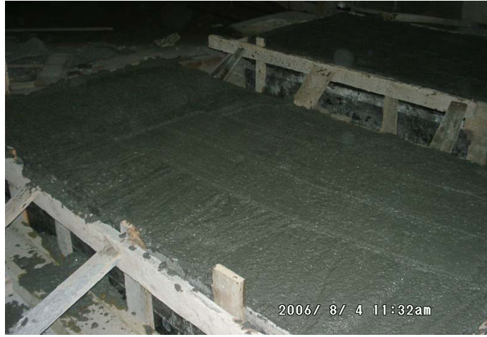
Şekil 3.5: Beton Plakların Tamamlanması
