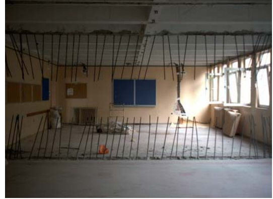
Şekil 1.3: Sisteme Yeni Perde İlavesi için Yapılmış Ankrajlar [2]
