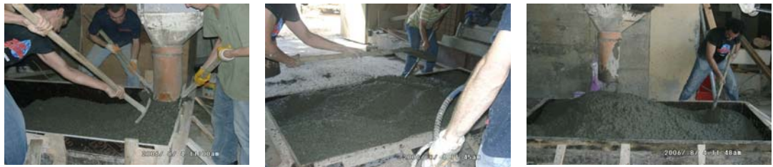
Şekil 3.3: Betonun Kalıplara Yerleştirilmesi
