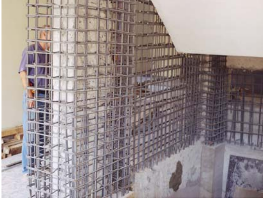
Şekil 1.2: Betonarme Manto Uygulaması [2]
