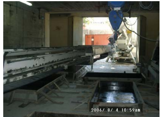
Şekil 3.2: Bantlı Mikser ile Beton Dökümü
