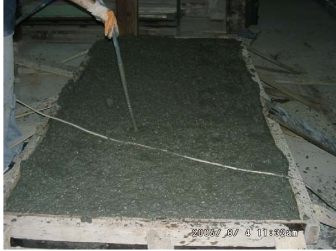
Şekil 3.4: Vibratör Uygulaması
