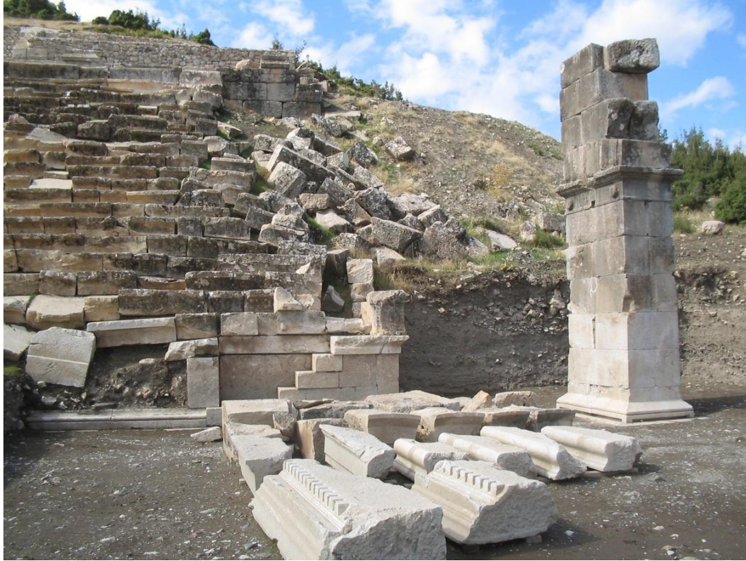
Şekil 1.13a: Kibyra antik kenti (Göhlisar-Denizli) stadyumu girişinde M.S. 417 ve M.S. 23 tarihsel depremleri ile meydana gelmiş hasar görünümü (Çubuk ve Taymaz, 2009c)
