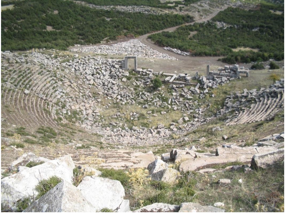
Şekil 1.13b: Kibyra antik kenti (Çameli-Göhlisar, Denizli) tiyatrosunda M.S. 417 ve M.S. 23 tarihsel depremleri ile meydana gelmiş hasar görünümü (Çubuk ve Taymaz, 2009c).
