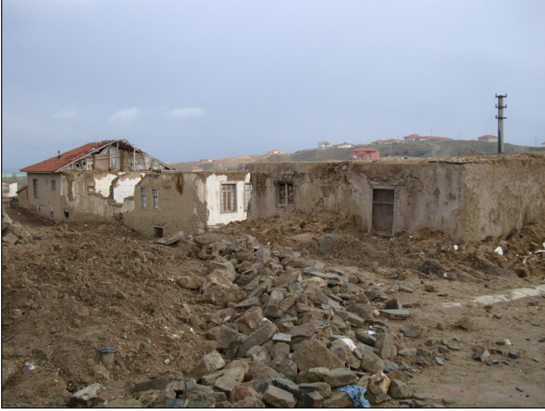
Şekil 1.4b: Bâla ilçesinde M_L=5.6 ve 5.5 olan 2007 yılı depremlerinde hasar görmüş evler (Çubuk ve Taymaz, 2009a, b).
