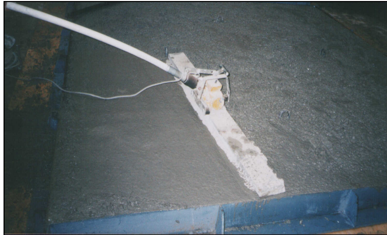
Şekil 2.11: Vibratörlü Yüzey Masterı Yardımıyla Beton Yüzeyinin Düzeltilmesi
