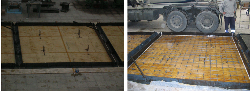
Şekil 5.1: Beton Döküm Düzeni
