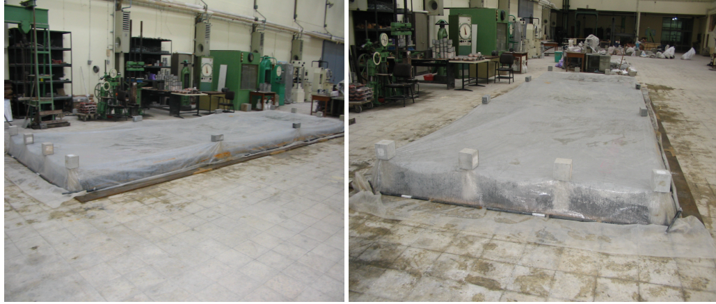
Şekil 3.3: Beton Yüzeyinin Su Geçirimsiz Örtü ile Korunması
