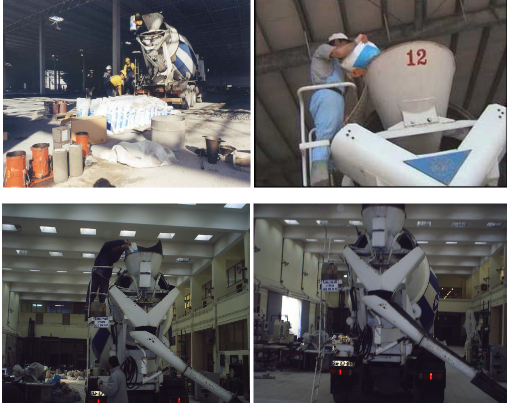
Şekil 2.9: elik Tellerin Transmiksere İlave Edilmesi
