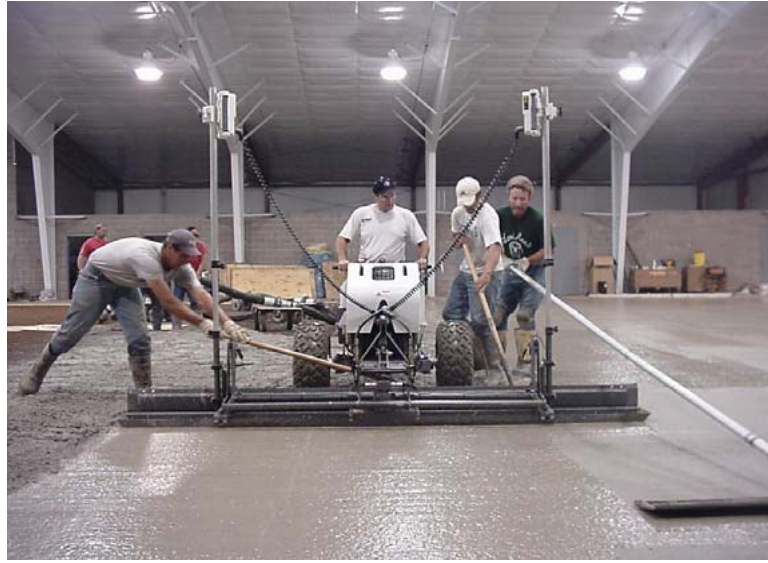
Şekil 2.13: Lazerli Master Kullanılarak Beton Yüzeyinin Düzeltilmesi
