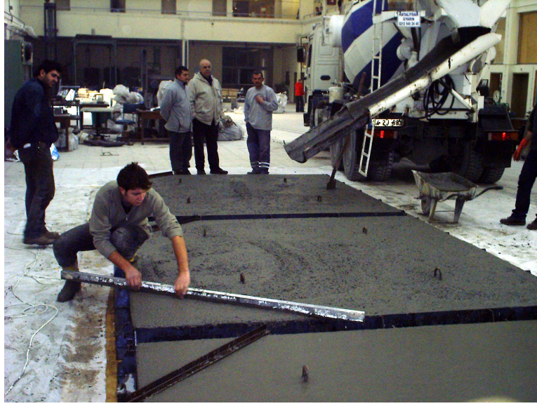
Şekil 2.10: El Masterı Yardımıyla Beton Yüzeyinin Düzeltilmesi
