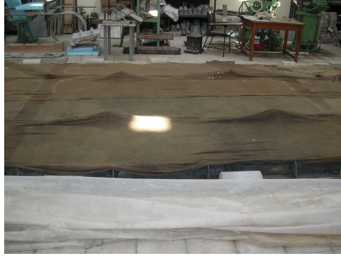
Şekil 3.2: Beton Yüzeyinin Islak Örtü ile Korunması
