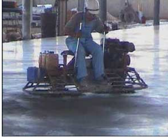
Şekil 2.14: Perdah Makinesiyle Beton Yüzeyinin Sıkıştırılması
