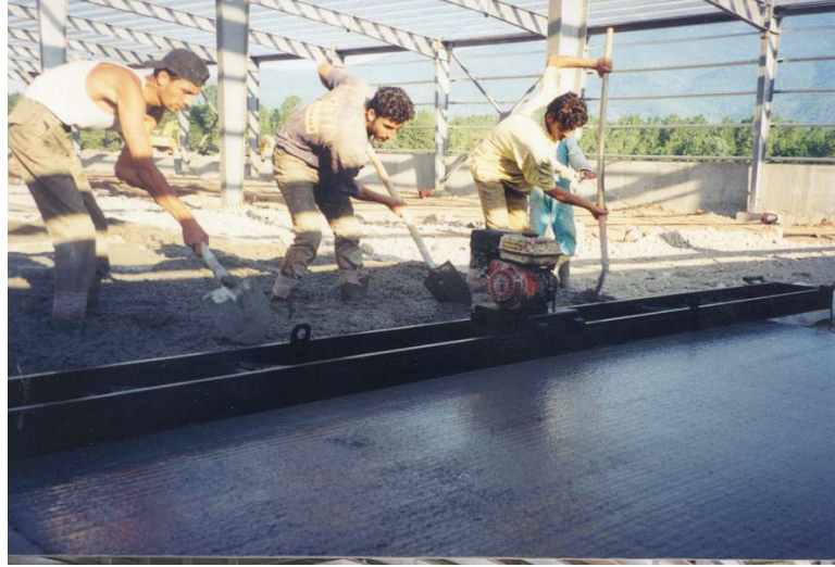
Şekil 2.12: Çerçeve Üzerinde Hareket Eden Vibratörlü Yüzey Mastarı
