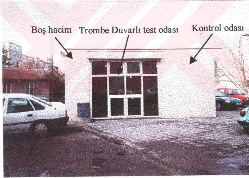
Şekil 4.1 Trombe Duvarlı Pasif Sistemin önden görünüşü
