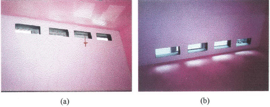
Şekil 4.4 Ventilasyon deliklerinin yerleştirilişi, a) üst, b) alt
