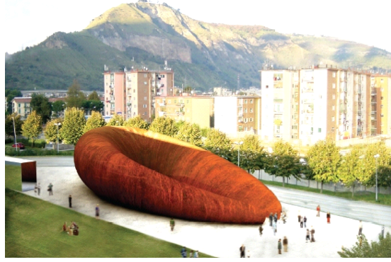
Şekil 4.19 : Napoli Monte St. Angelo Metro girişi tasarımı (Url-34).
