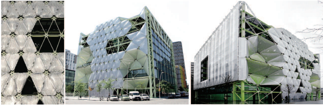
Şekil 3.21 : Media TIC Ofis Binası, Cloud9 Architects/Enric Ruiz-Geli, 2010 (Url-25).
