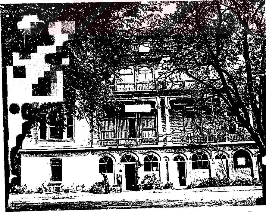
Yükseltilmiş zemin kat planı ve arka cephenin restorasyon öncesi görünümü
