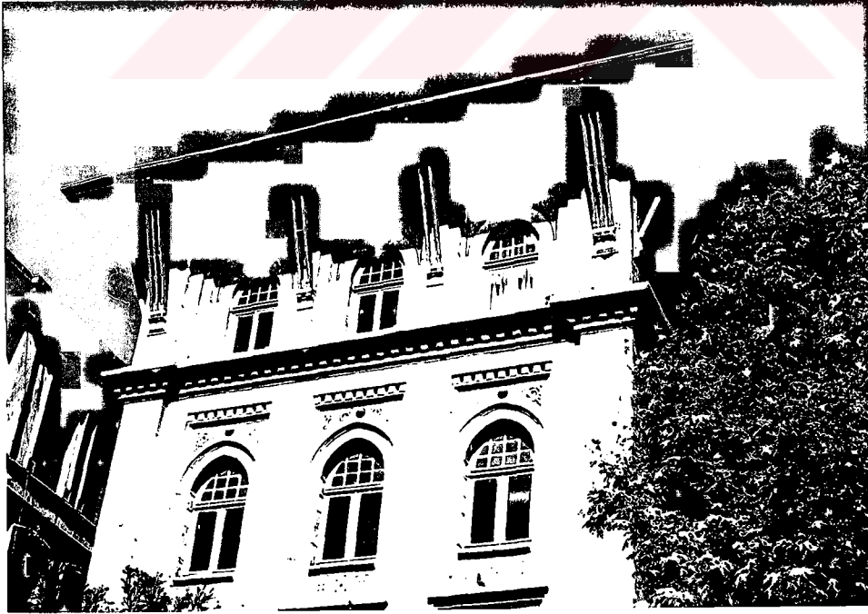
Tapu ve Kadastro Binası
