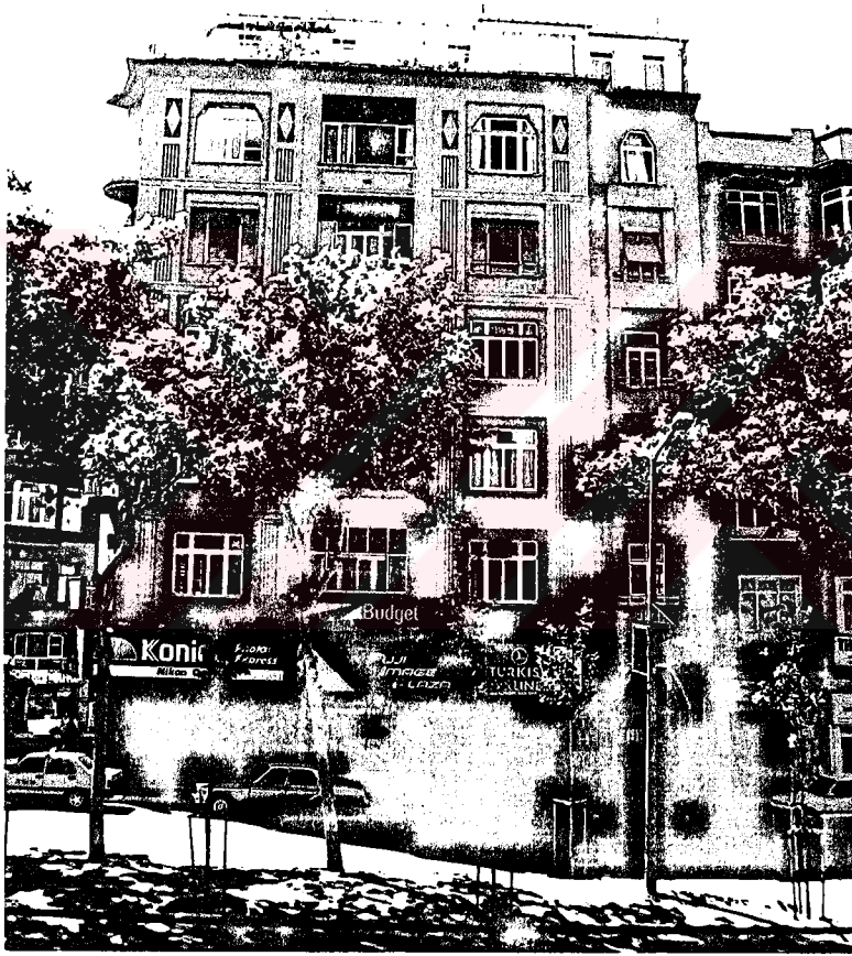
Şekil 4.12. Pertev Apartmanı: Cumhuriyet Caddesi cephesi (1999)
