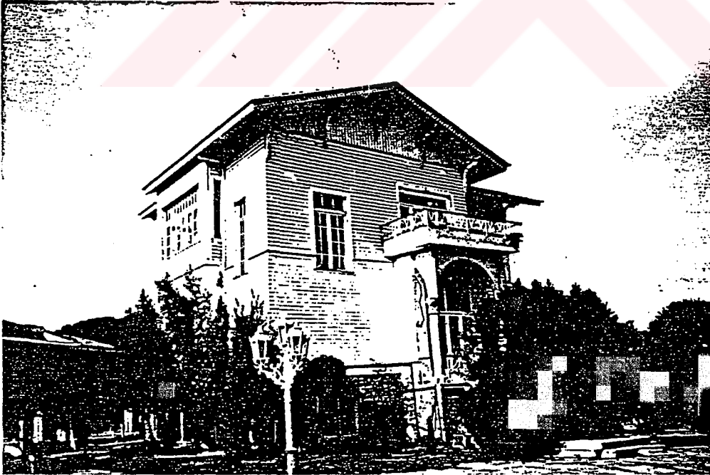
Şekil 3.7. Ana giriş cephesi
