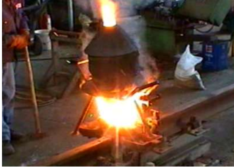
Şekil 3.28 Reaksiyon ve dökümün başlangıcı
