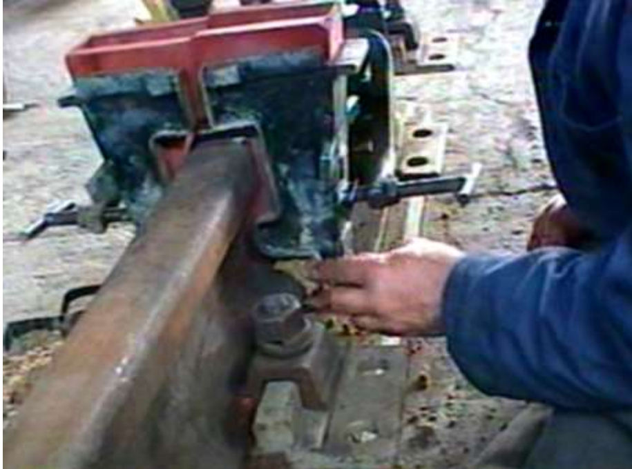
Şekil 3.10 Kalıbın kılı kum ile sıvanması
