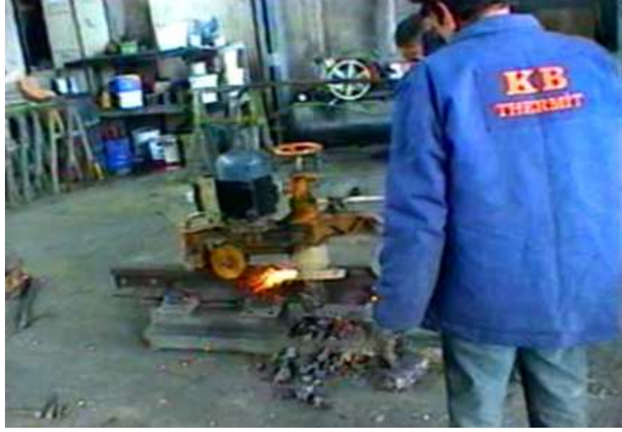
Şekil 3.32 Elektro taşlama makinesi ile ray yüzeyinin temizlenmesi
