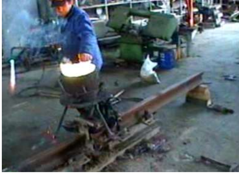
Şekil 3.25 Tutuşturucu maytap ile ateşleme
