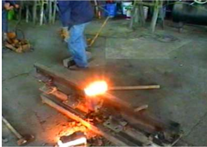
Şekil 3.31 Kaynağın soğumaya bırakılmış hali
