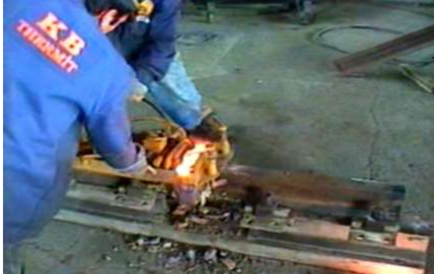
Şekil 3.33 Ray oluklarının traşlanması
