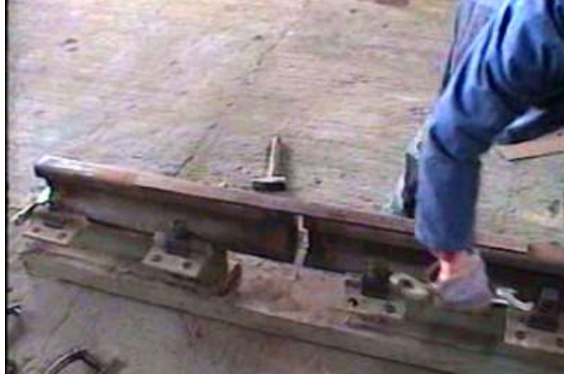
Şekil 3.2 Kaynak boşluğunun hizalanması
