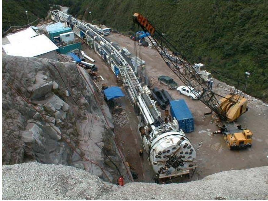
Şekil 2.9 Tam cepheli tünel açma makinesi ve yedekleme sistemleri (Herrenknecht)
