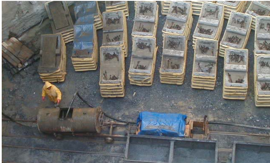
Şekil 8.4 Montaja hazır haldeki segmentler
