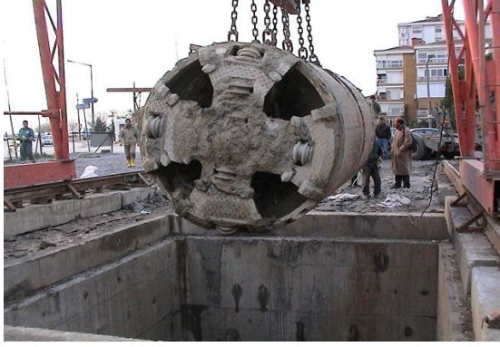
Şekil A.1 : Mikrotünel makinesinin kazıyı tamamlama aşamaları.
