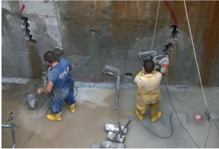
Şekil A.4 : Makinenin kesme yönünde kuyuda açılan ilerleme çemberi.
