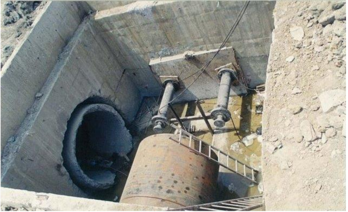
Şekil A.14 : Klasik metodla boru itme işlemi.
