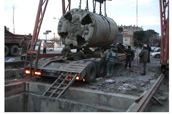
Şekil A.1 : Mikrotünel makinesinin kazıyı tamamlama aşamaları.
