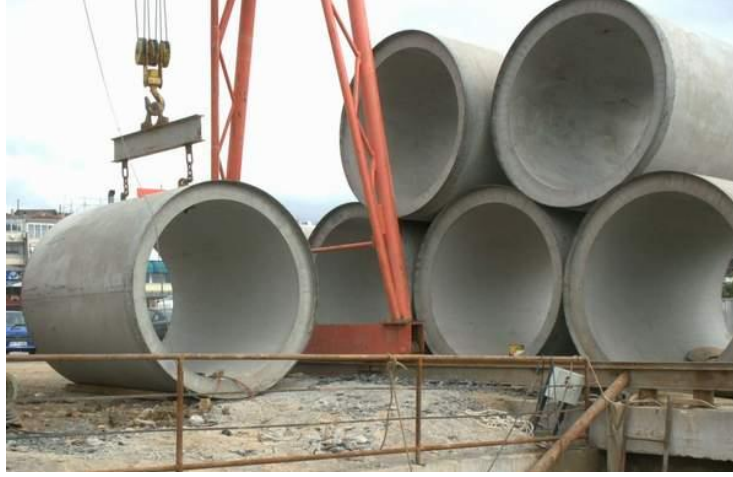
Şekil A.13 : Boruların kuyuya indirilmesi.
