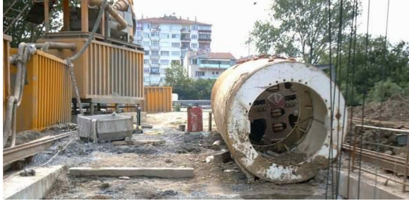
Şekil A.11 : Mapaları bağlanmış olan makine ve kesici kafanın indirilmesi.
