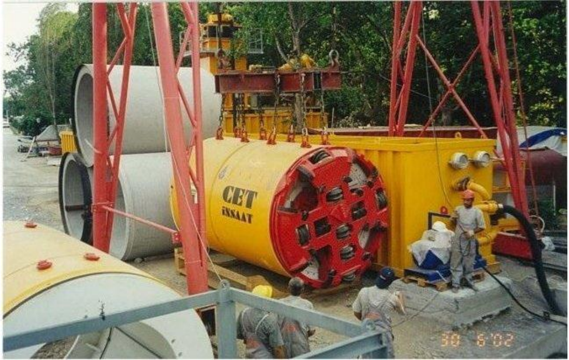
Şekil 3.14 : Mikrotünel makinesinin ilk kurulumu.
