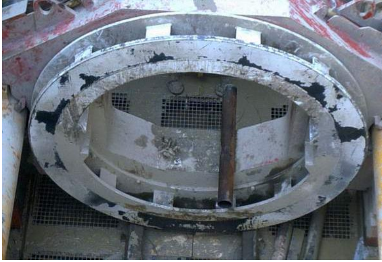
Şekil A.9 : İtme şaftına indirilen platformun yerleştirilmesi.
