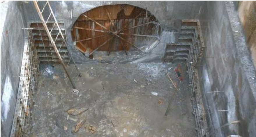
Şekil A.10 : Açılan kuyuda makinenin ilerleyeceği yönü belirleyen kalıp.
