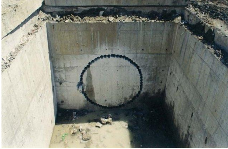
Şekil 3.22 : Çıkış kuyusuna MTBM'nin ulaşması için delik açılması.
