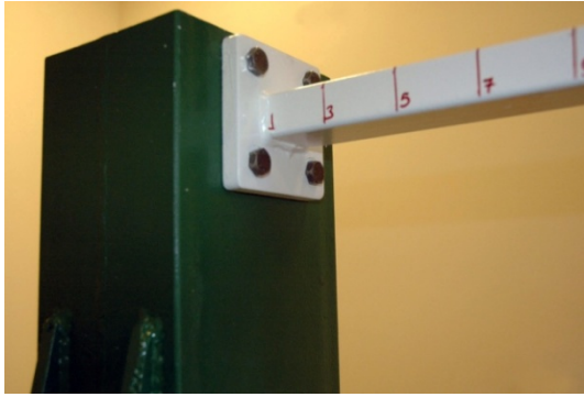
Şekil 2.74 : Üstyapı ile profil bağlantıları.
