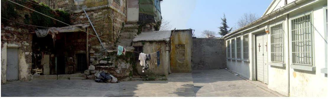
Şekil 14- Rum Kilisesi ve etrafındaki yapıların durumu
